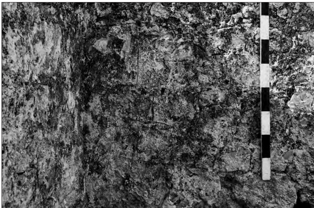
Fig. 4. Disposição do opus incertum na Insula do aqueduto. Foto H. Rendeiro©MMC/DGPC.
