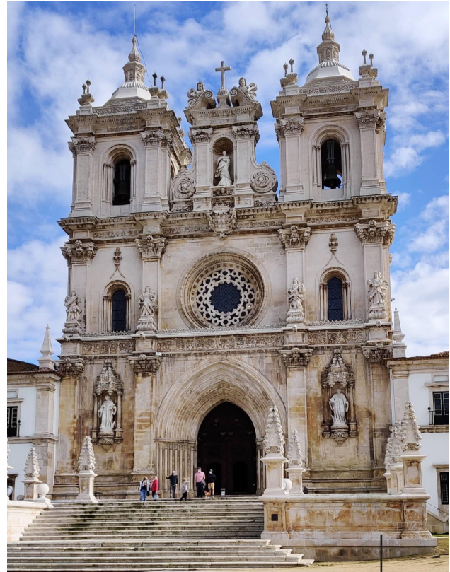
Mosteiro de Alcobaça: Conservação e restauro; 3
