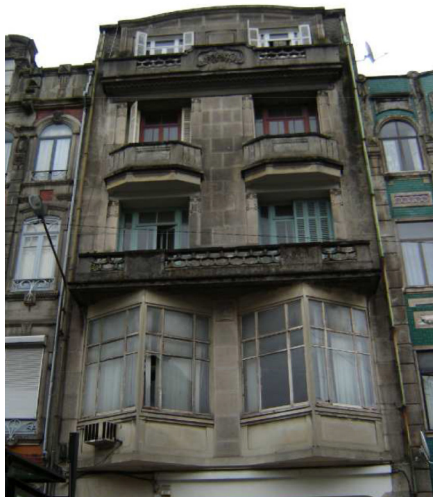
18 | Edifício da Rua Alexandre Braga;
