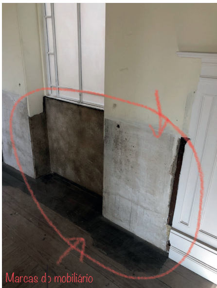
102 Interior do edifício António Enes Baganha | Marcas do mobiliário;
