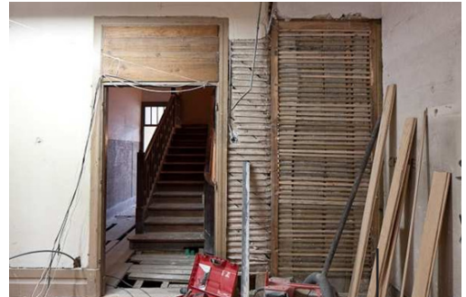
Interior do edifício; 54 Situação Preexistente
