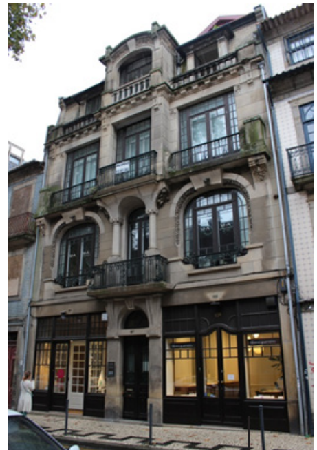
Fachada prédio da Rua do 100 Rosário;
