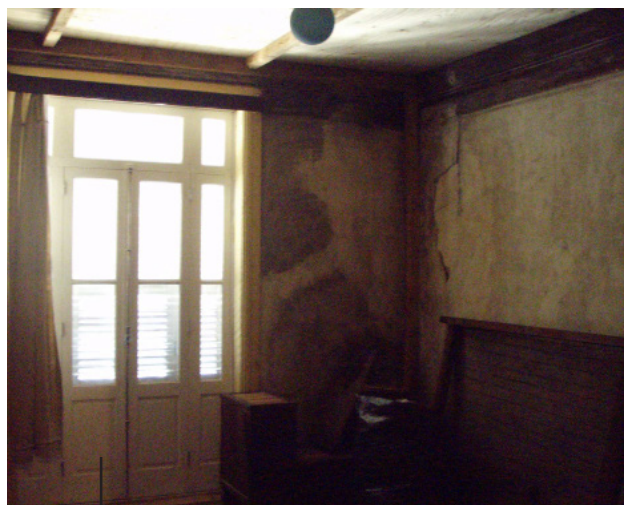
30 Interior do edifício da Rua Alexandre Braga; Situação Preexistente
