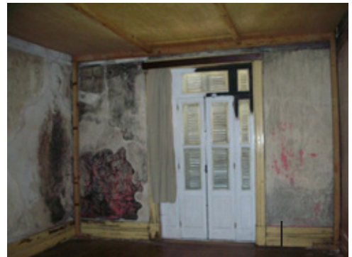
Interior do edifício; 50 Situação Preexistente
