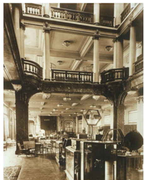
Interior dos Grandes Armazéns Nascimento; 78
