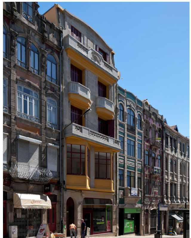
Edifício da Rua Alexandre Braga: 31
