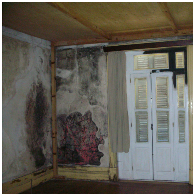
29 Interior do edifício da Rua Alexandre Braga; Situação Preexistente
