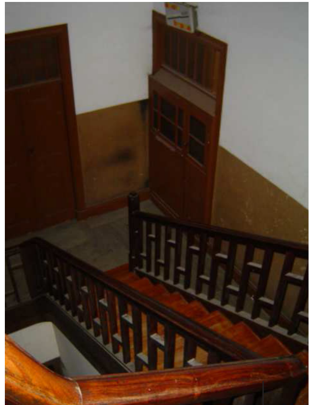
Interior do edifício da Rua Alexandre Braga; 22 Situação Preexistente
