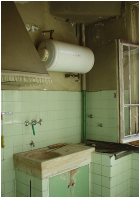
56 Interior do edifício | Situação Preexistente;
