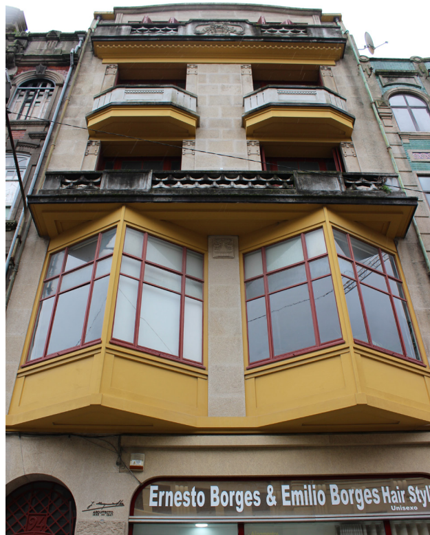
49|Prédio da Rua Alexandre Braga, 2021;
