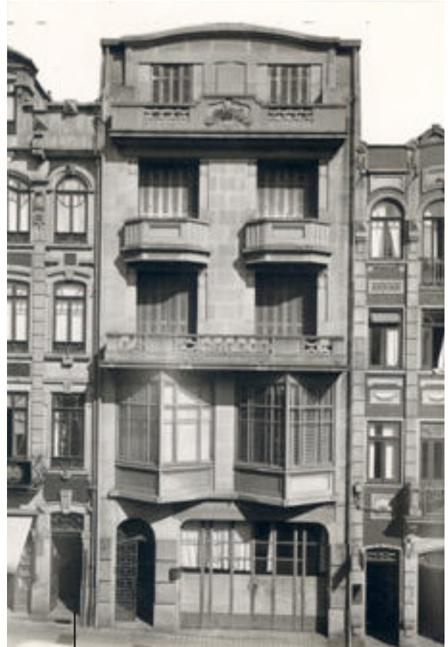
21 Edifício da Rua Alexandre Braga;
