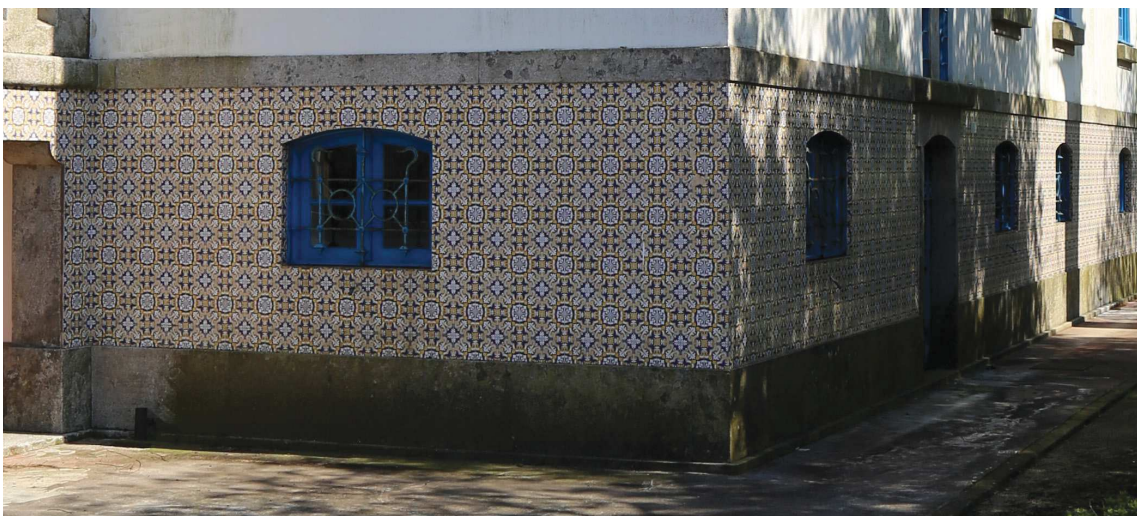
Figura 75 – Fotografia do porão alto com o soco em cantaria de pedra.
