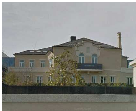
Figura 144- Alçado frontal depois da intervenção
