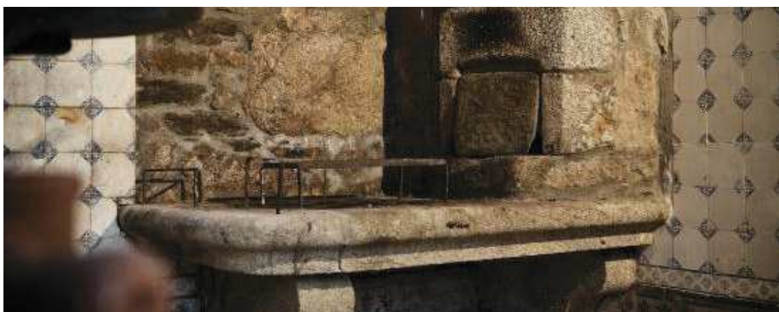
Figura 111 - Lareira original existente na casa dos caseiros.
