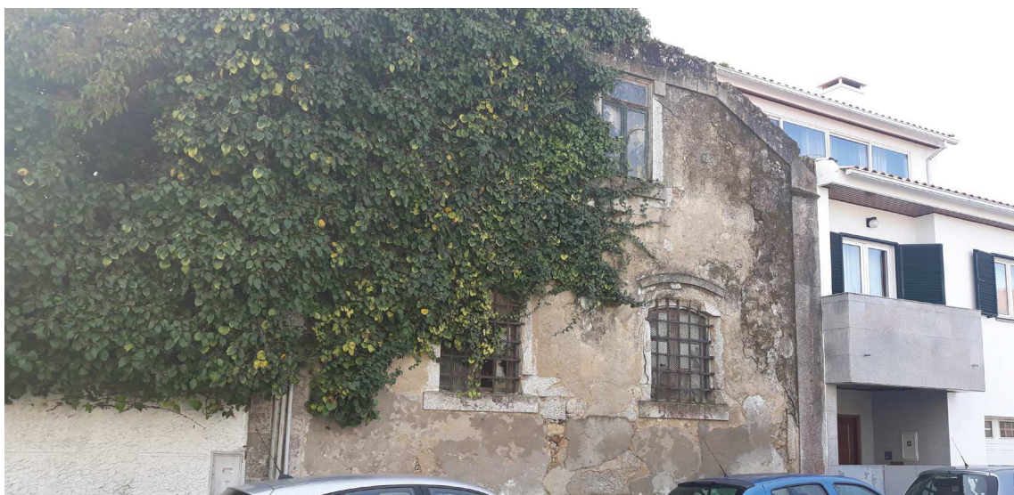
Figura 90 - Levantamento fotográfico do alçado norte, da ruína.
