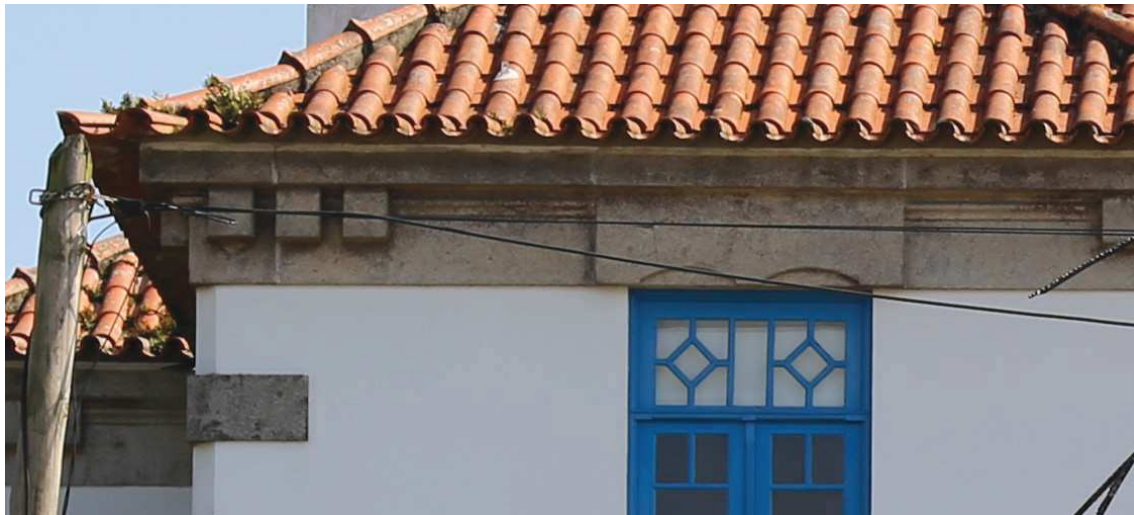
Figura 70 – Fotografia dos cachorros, cunhais e frontão retangular do Palacete das Almas.
