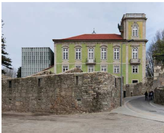
Figura 122 - Intervenção na parte posterior.
