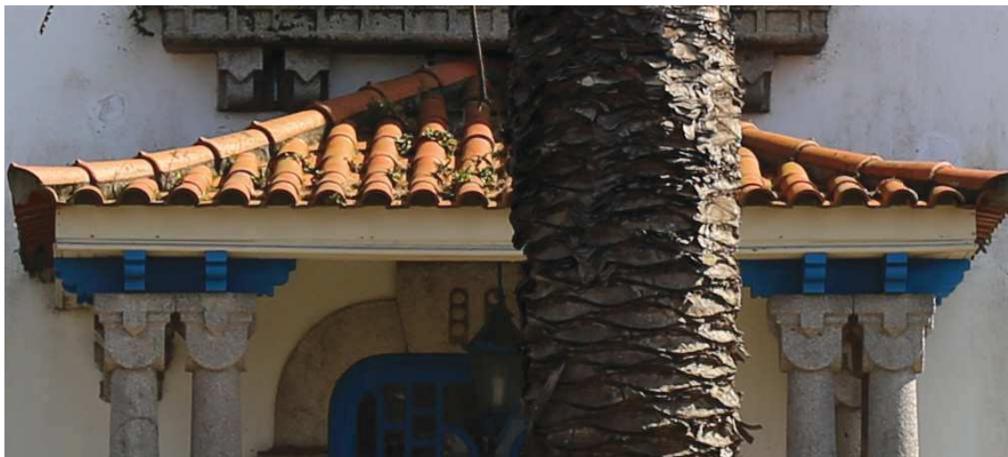
Figura 72 – Fotografia das missulas de apoio.
