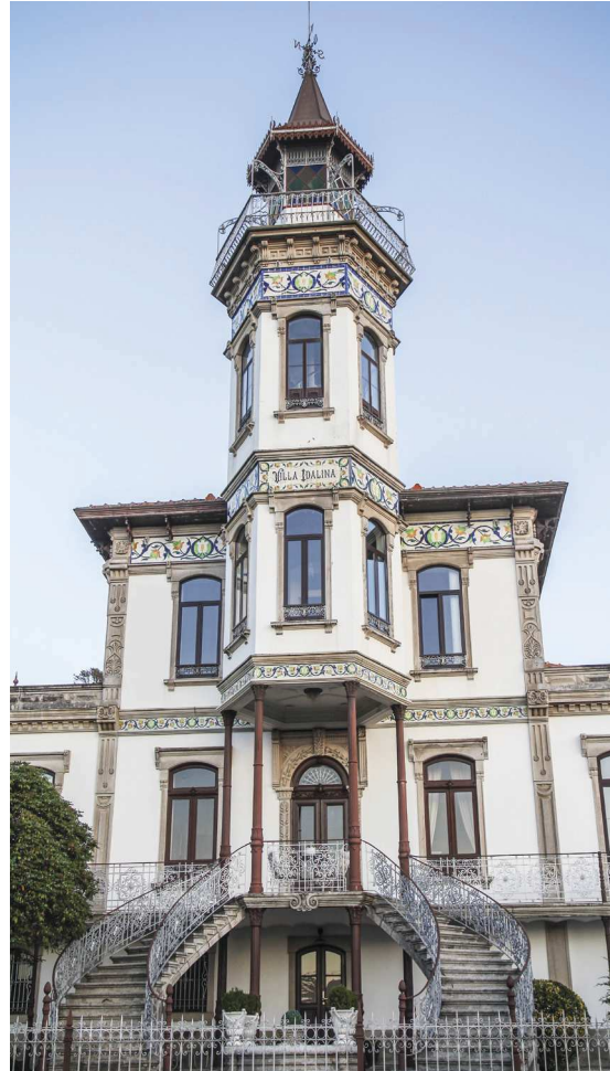
Figura 106 - Torre hexagonal da Villa Idalina.
