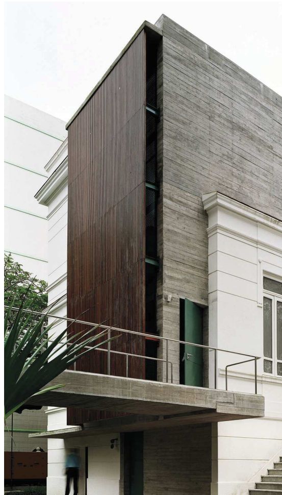
Figura 161 - Intervenção no palacete.
