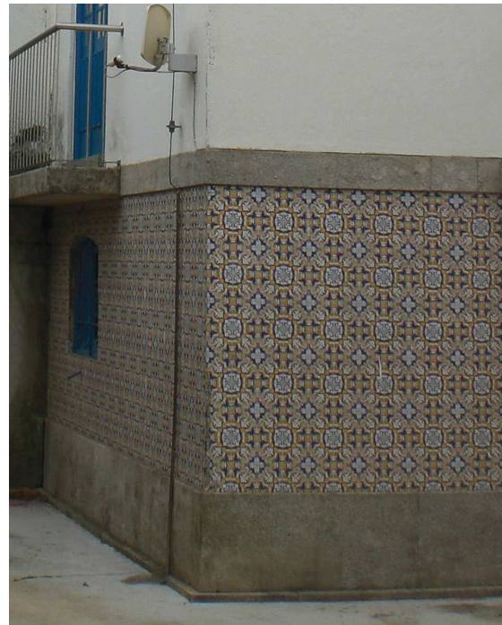
Figura 56 – Parte inferior do palacete.
