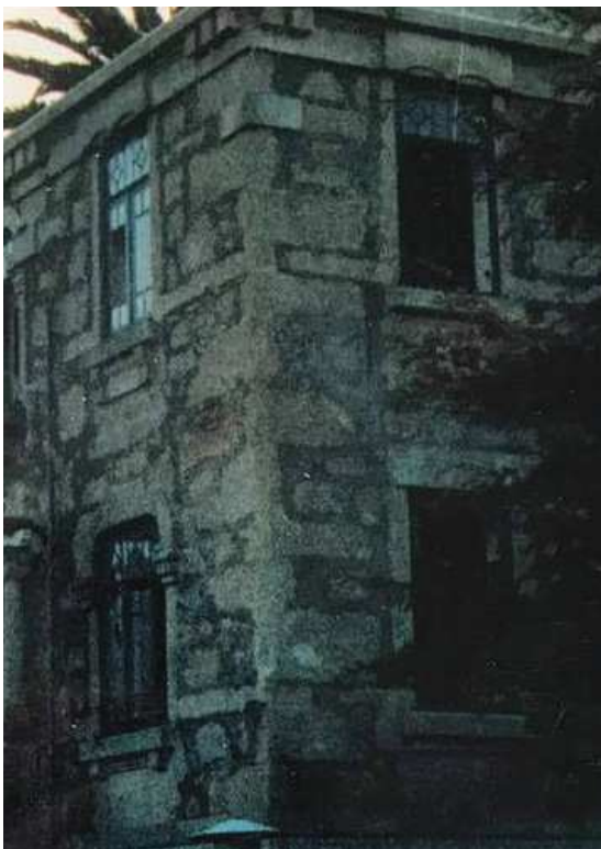
Figura 57 – Fotografia do palacete em fase de obras.
