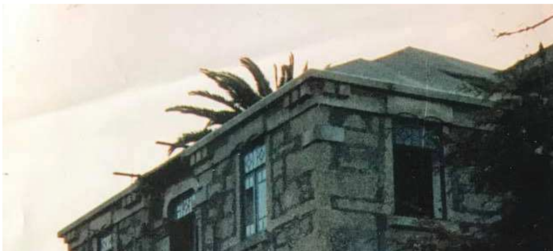
Figura 66 – Fotografia do palacete em obras já com a laje de betão realizada.
