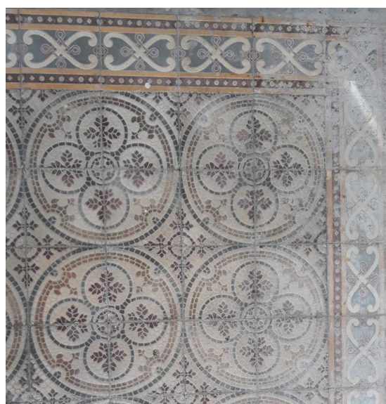
Figura 61 – Pavimento cerâmico existente.
