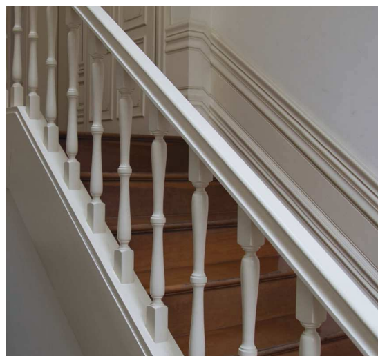
Figura 69 – Fotografia do corrimão existente.
