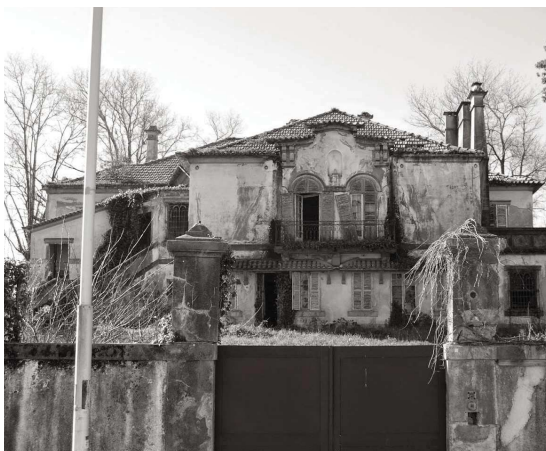
Figura 143- Alçado frontal antes da intervenção
