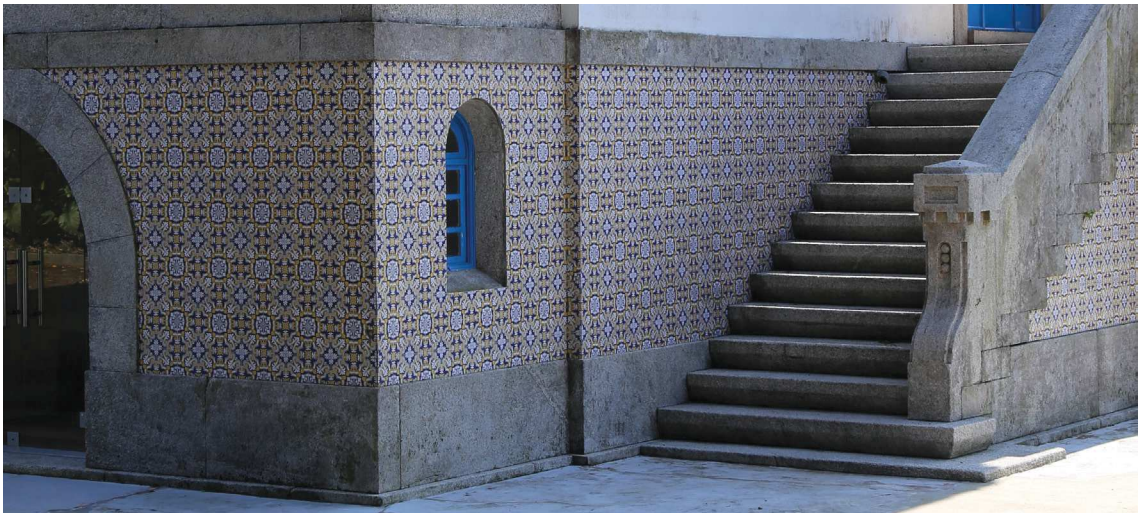
Figura 73 – Fotografia das escadas de acesso à porta de entrada do palacete.
