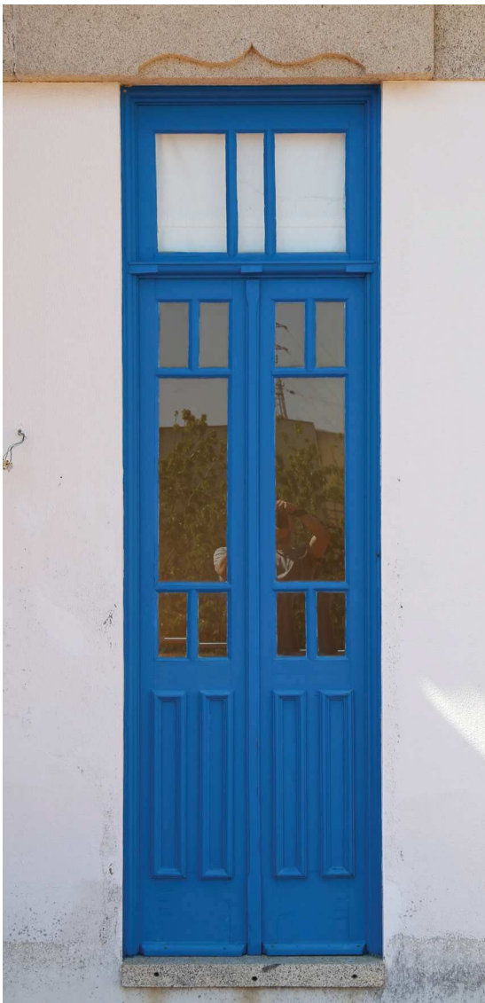
Figura 62 – Exemplar da porta exterior.
