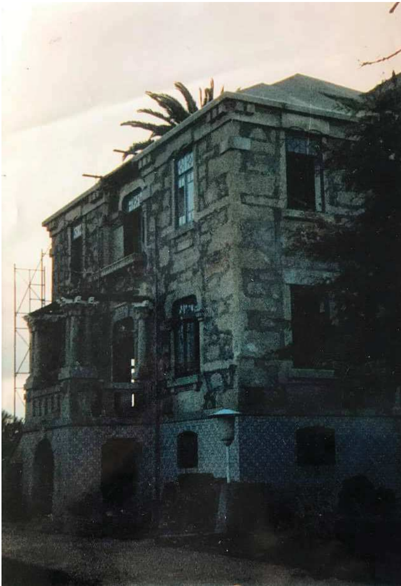
Figura 46 - Fotografia do palacete em fase de obras de reabilitação e ampliação, 1984.
