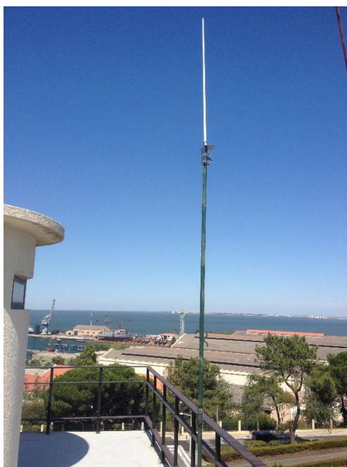
Figura 40 - Local da montagem da antena
