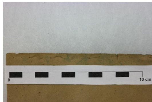
Figura 126 - Fotografia de pormenor da união do papel com revestimento metálico antes da intervenção.
