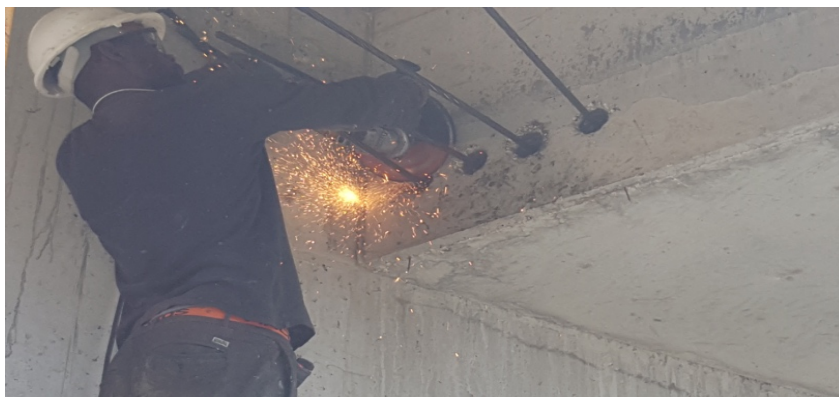
(Fig. 43 – Corte dos Cabos)
