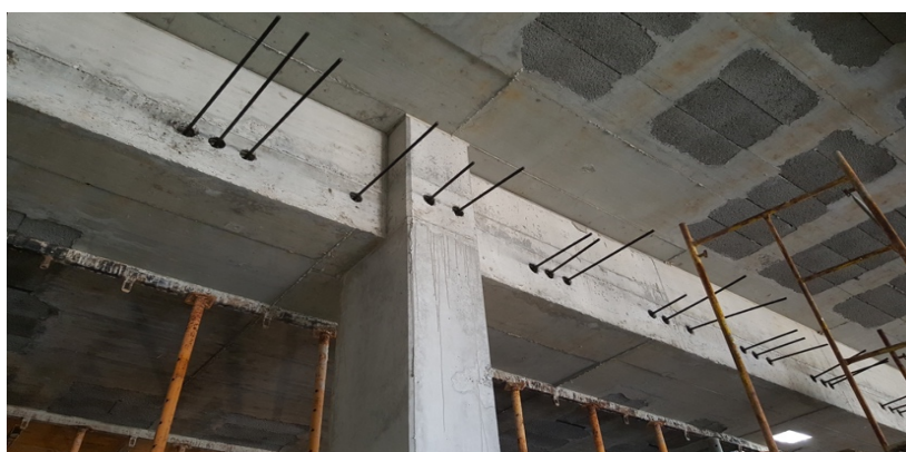
(Fig. 42 – Alongamentos dos Cabos)
