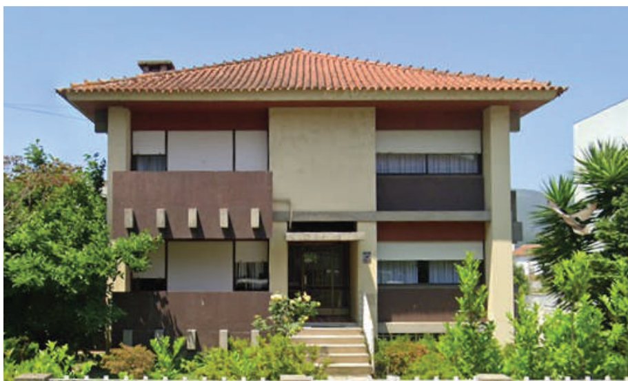
Fig. 9: Habitação antes de intervenção.
