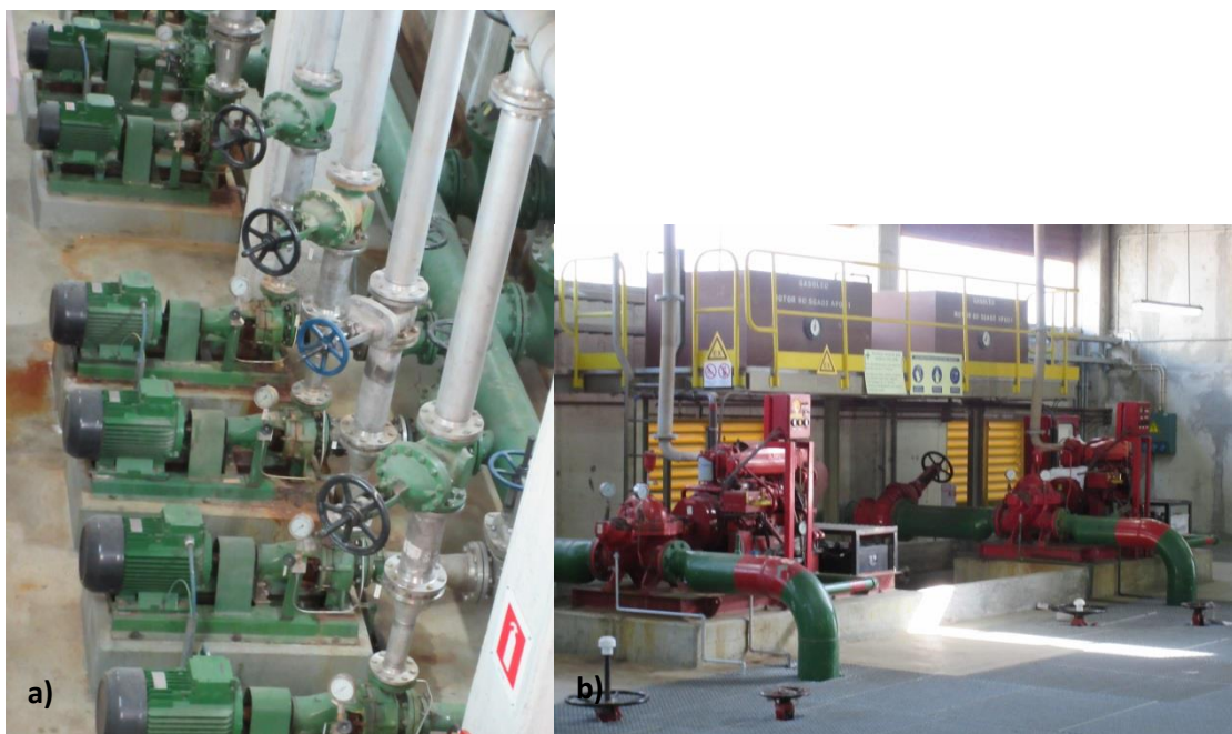
Figura 9: a) e b) bombas utilizadas para o transporte da água no interior da ITA.
