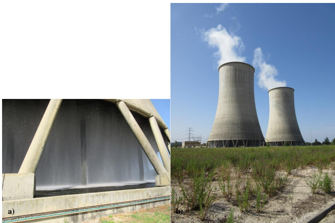
Figura 5: a) - Bacia da torre de refrigeração; b) - Vista sobre as torres de refrigeração.
