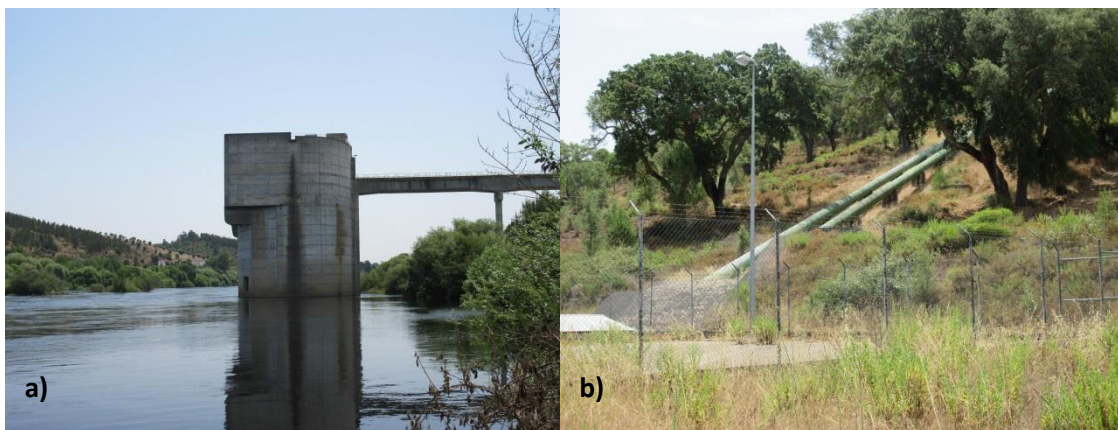
Figura 8: a) Local de captação de água no rio Tejo; b) Tubagens que conduzem a água bruta à ITA.
