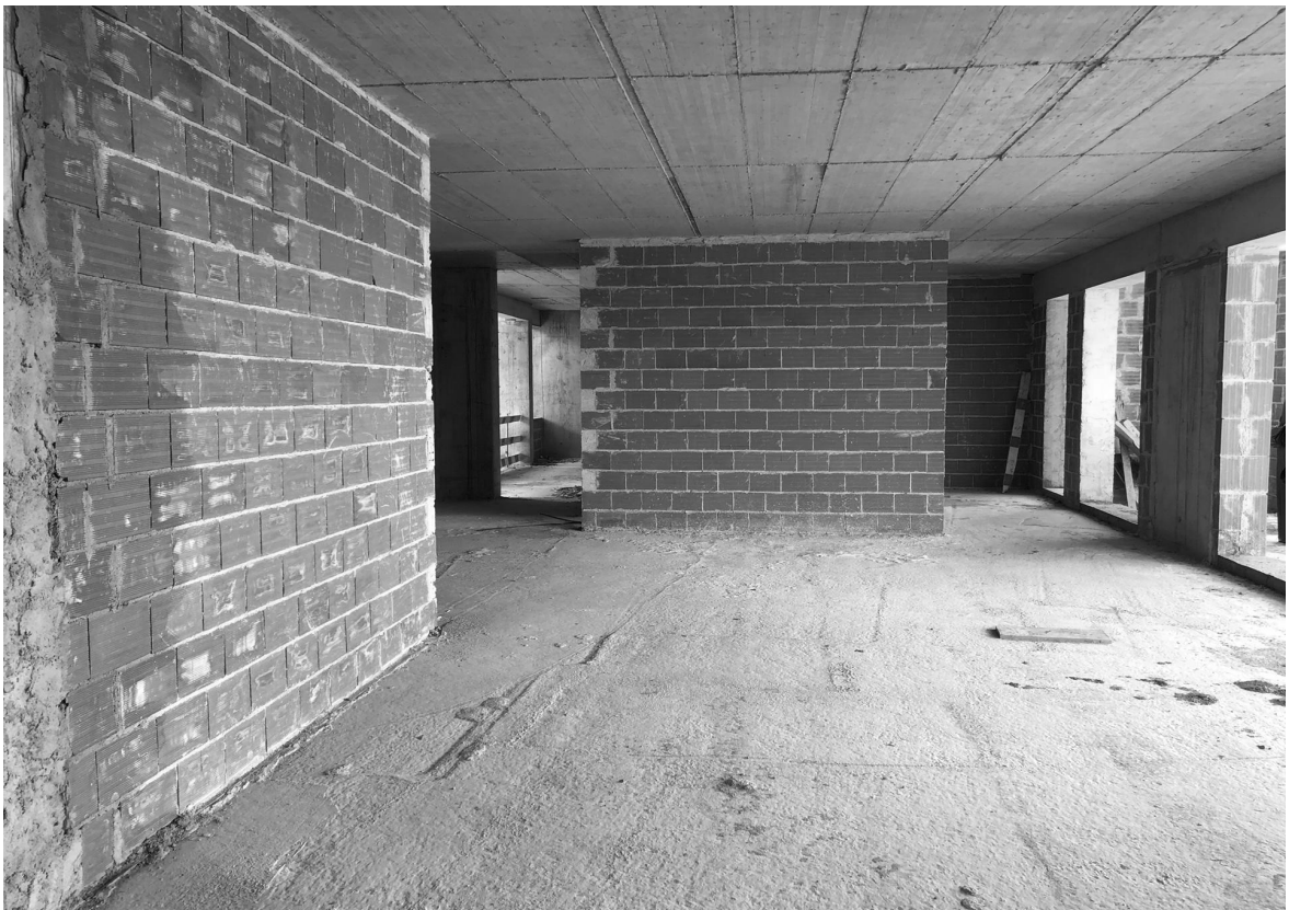
Imagem 57, 58 e 59 - Fotografia do local pré-existente, Lisboa (2019).
