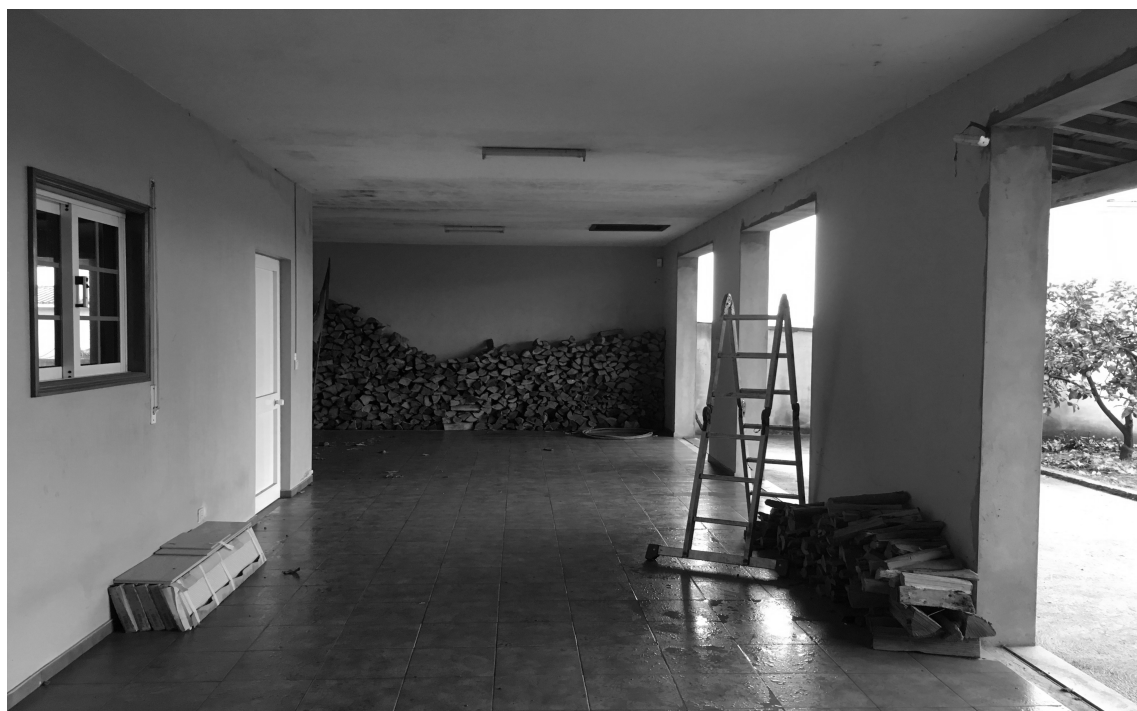
Imagem 54 e 55 - Fotografia do local pré-existente, Ribeirão (2019).
