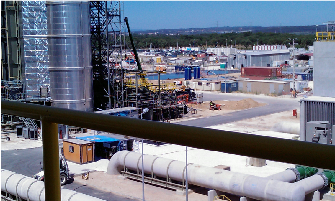
Figura 5-11 – Vista da chaminé e caldeira do grupo 40 e estaleiro da Siemens
