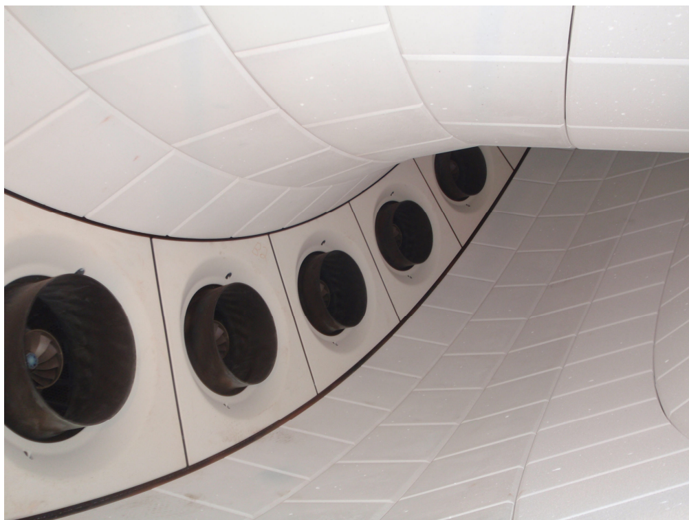
Figura 5-5 - Câmara de combustão da turbina a gás natural
