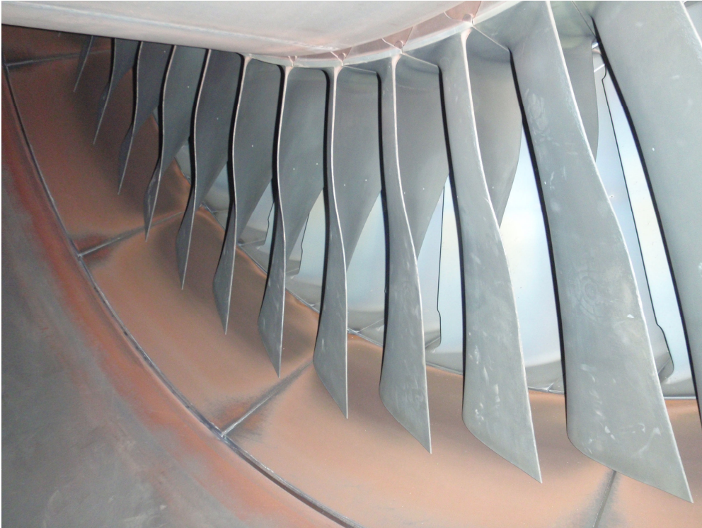
Figura 5-6 - Último andar da turbina a gás natural
