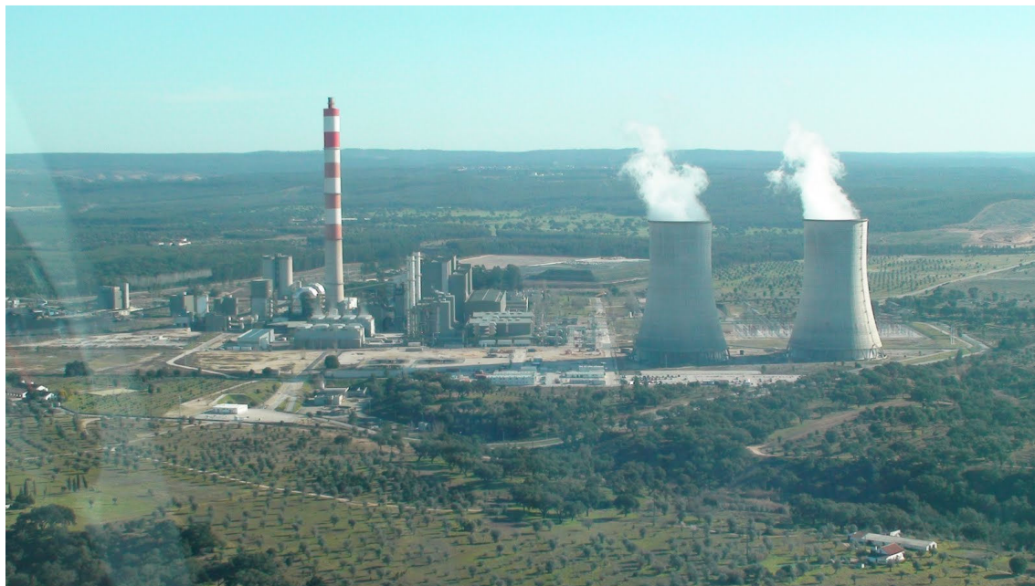
Figura 4-1 – Centro de Produção de Eletricidade do Pego com os dois grupos a carvão em funcionamento.
