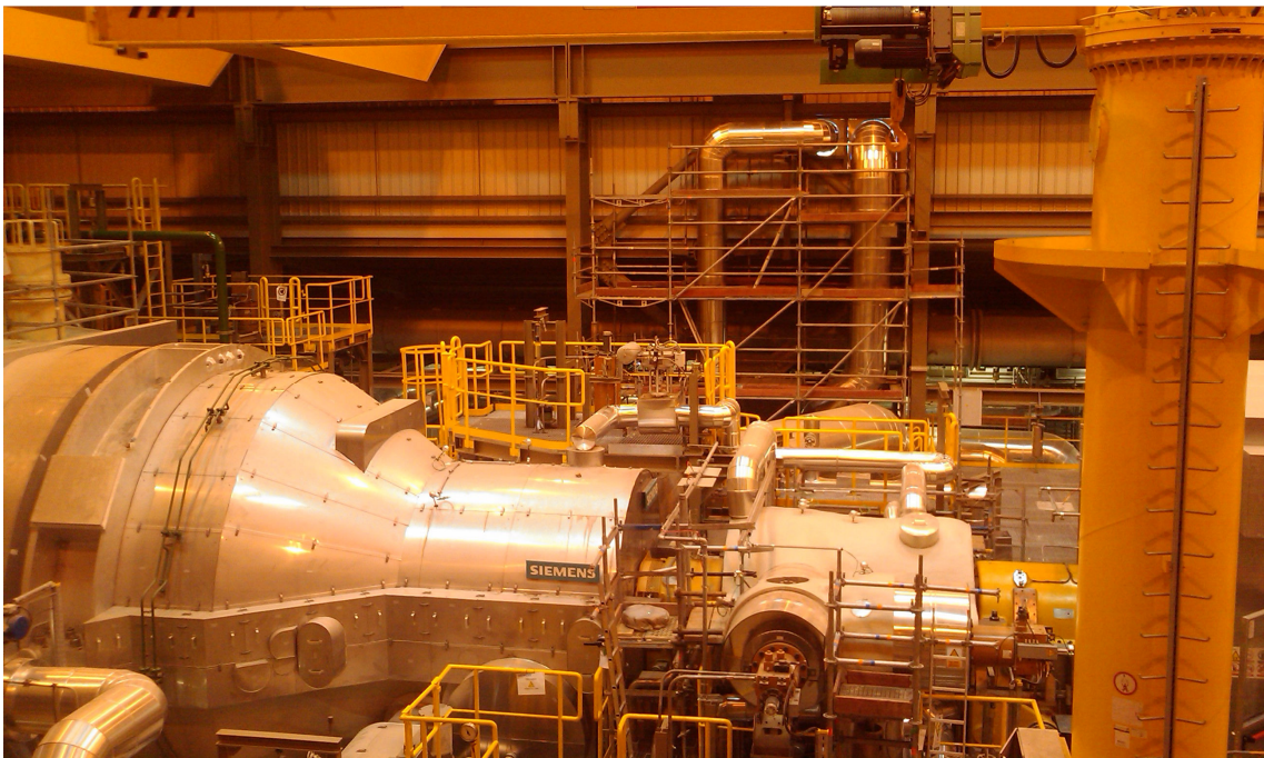
Figura 5-1 - Turbina a vapor (turbina de alta pressão à direita seguida das turbinas de média e baixa pressão)
