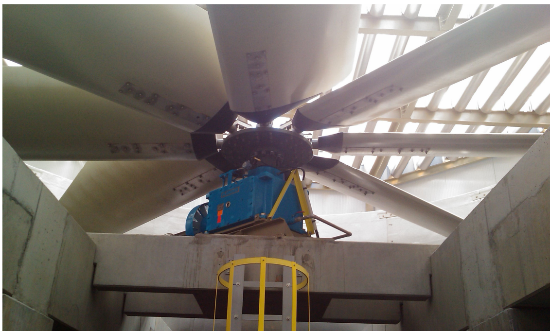
Figura 5-10 - Um dos oito ventiladores de uma torre de refrigeração e respetiva caixa redutora
