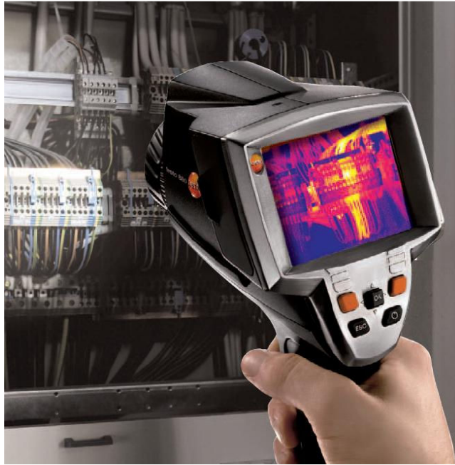
Figura 1-3 - Análise termográfica para a deteção de pontos quentes (maus contactos em barramentos).
