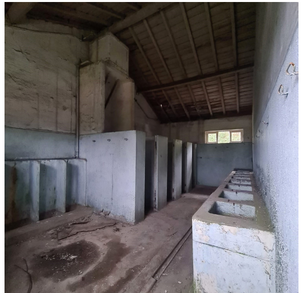
Imagem 57. Casa de banho, 1º piso - Casa da Malta
