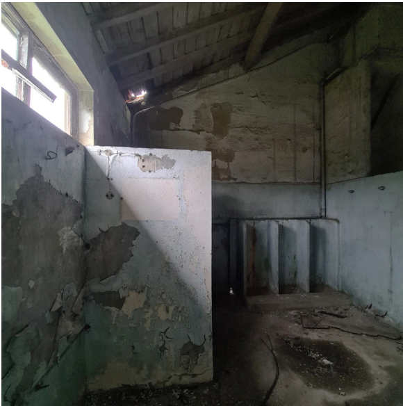
Imagem 56. Casa de banho, 1º piso - Casa da Malta
