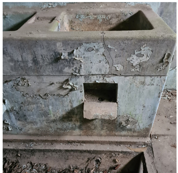
Imagem 59. - Pormenor de lavatorio da casa de banho - Casa da Malta
