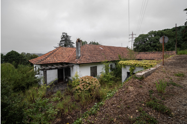
Imagem 25. Casa para trabalhadores dos quadros técnicos
