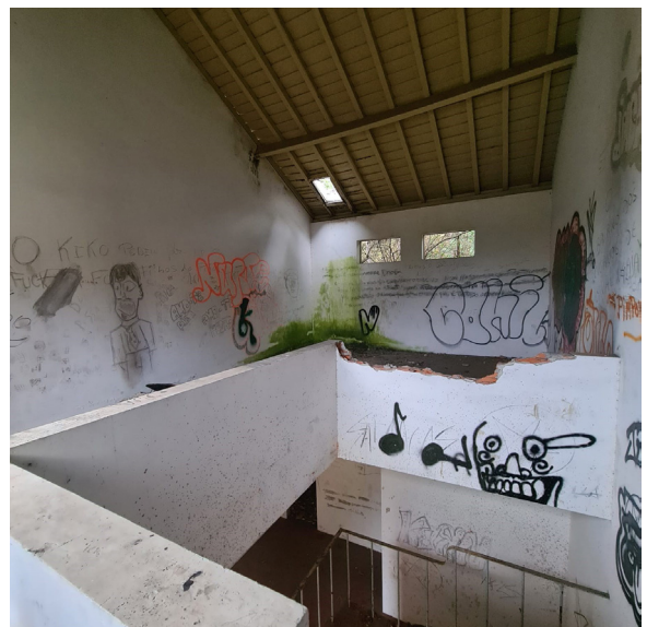
Imagem 47. Casa da Malta.
