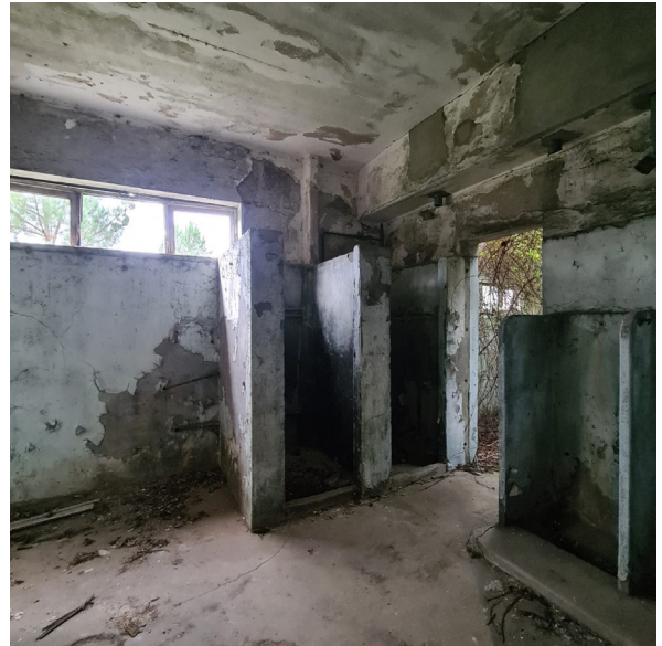
Imagem 55. Casa de banho, res do chão - Casa da Malta
