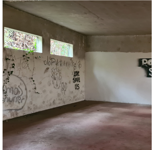
Imagem 49. Salão, res do chão - Casa da Malta
