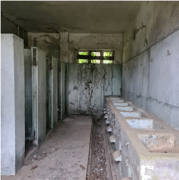
Imagem 54. Casa de banho, res do chão - Casa da Malta
