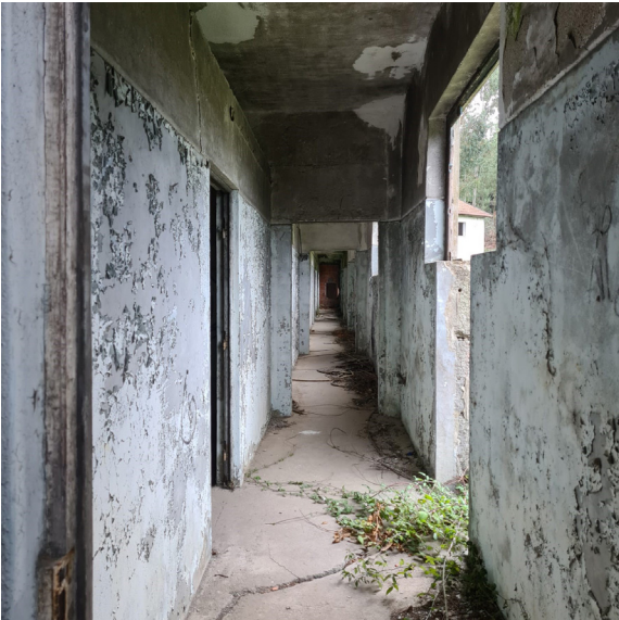
Imagem 44. Corredor, Res do chão - Casa da Malta
