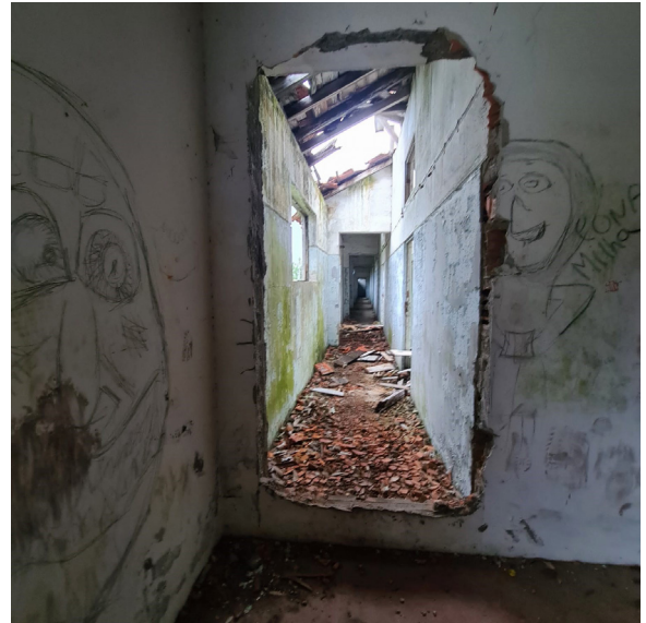
Imagem 45. Corredor, 1º piso - Casa da Malta
