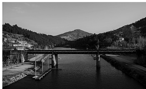
Imagem 4. Ponte de Pedorido construída no ano de 1893
