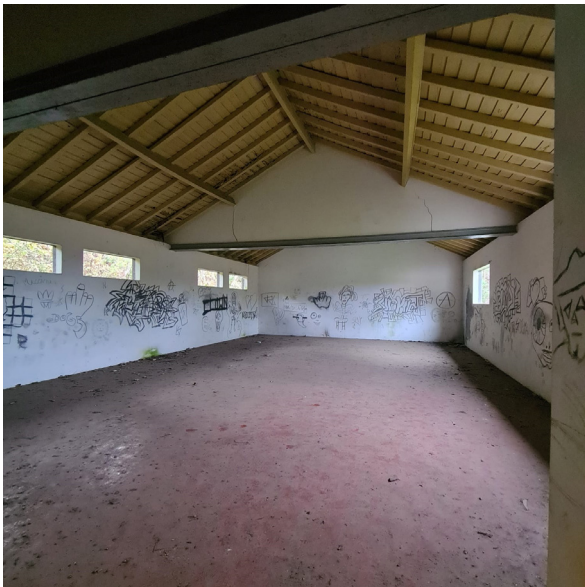
Imagem 50. Salão, 1º piso - Casa da Malta
