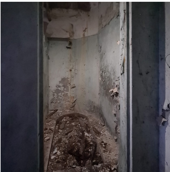
Imagem 58. Cabine, casa de banho - Casa da Malta
