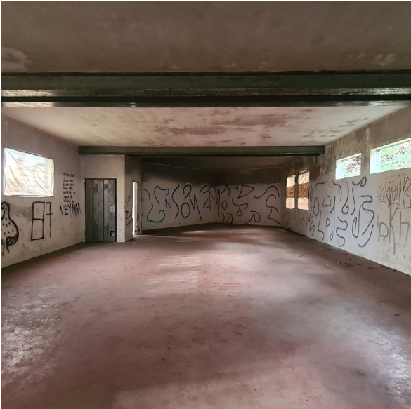
Imagem 48. Salão, res do chão - Casa da Malta
