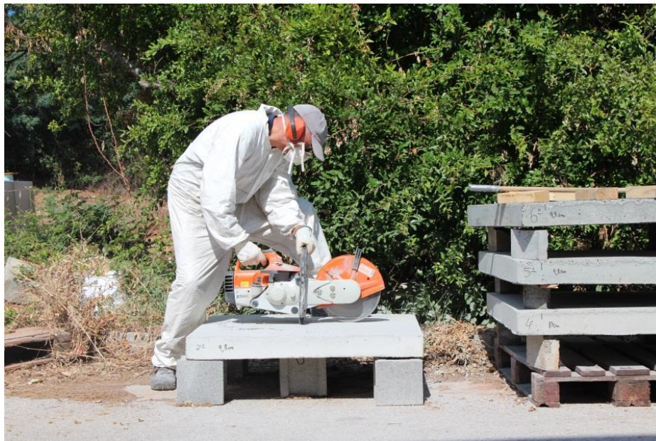
Figura 5.13 – Corte das 6 lajes ensaiadas.
