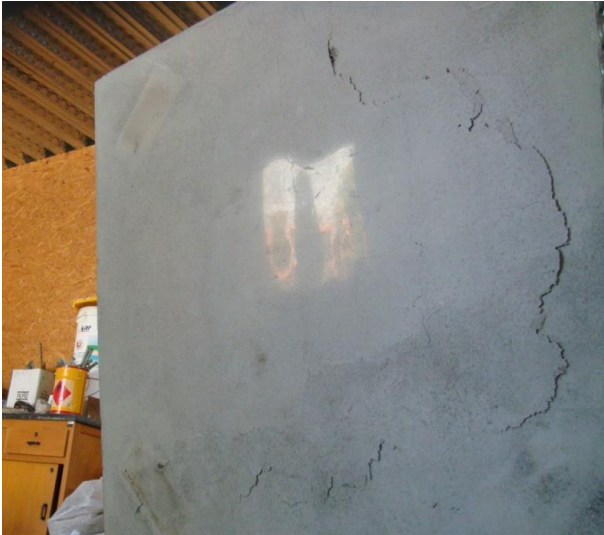
Figura 5.6 – Superfície de rotura da laje LA1-LC30.
