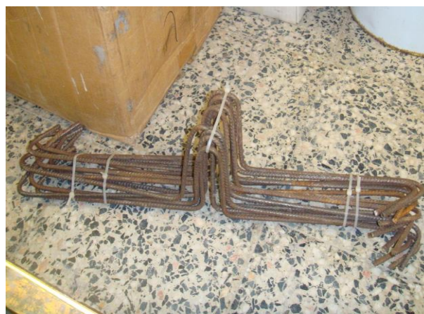
Figura 4.7 – Varões para movimentação da laje.
