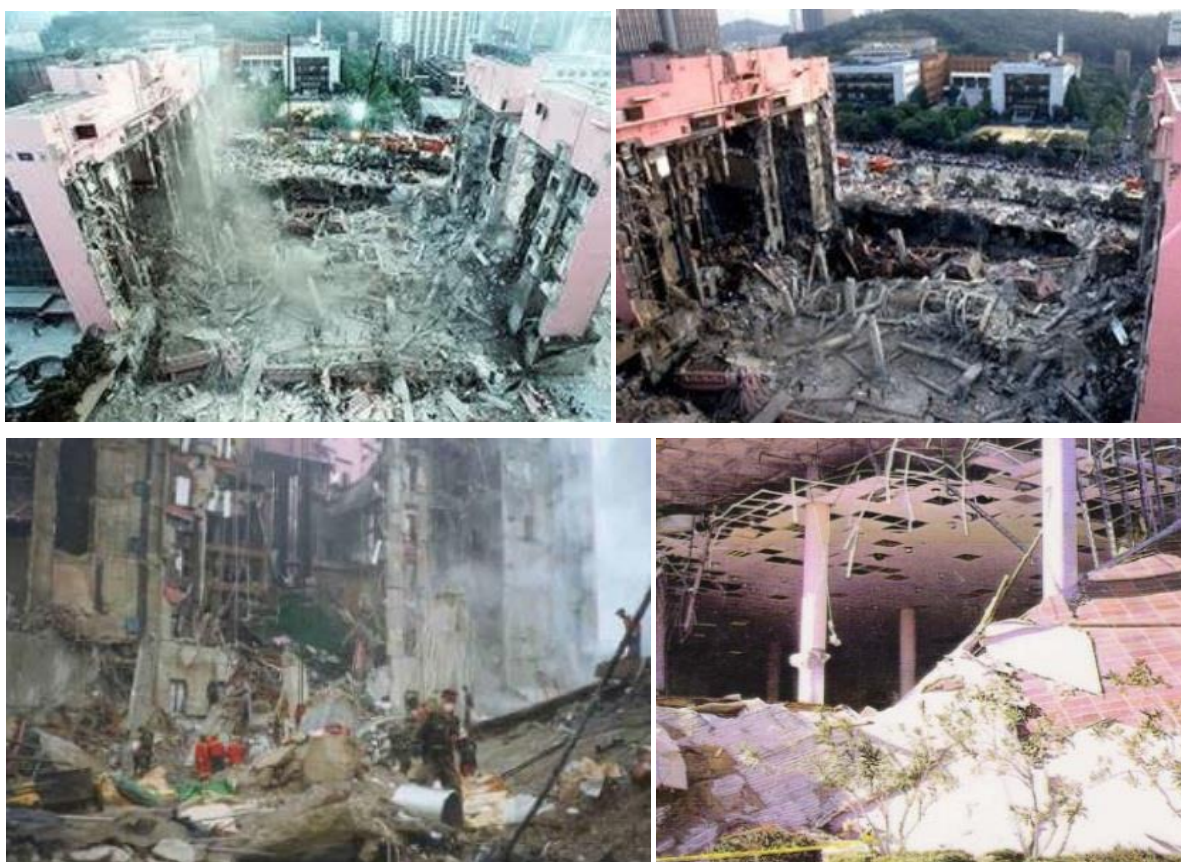
Figura 3.7 – Colapso do centro comercial Sampoong (Google, 2009; Ramos e Lúcio, 2006).
