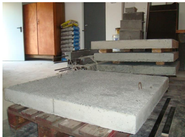
Figura 4.11 – Armazenamento das lajes.
