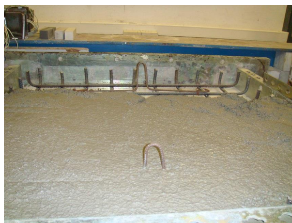
Figura 4.9 – Betonagem da laje.
