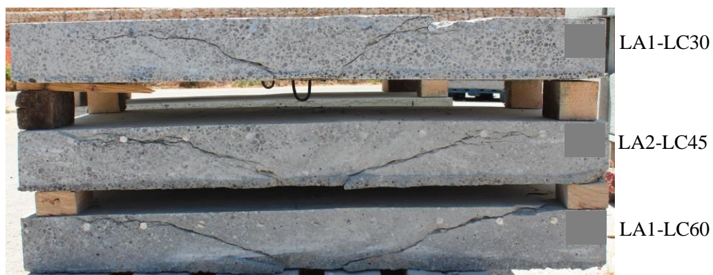
Figura 5.14 – Cone de punção das lajes LA1-LC30, LA2-LC45, e LA1-LC60.
