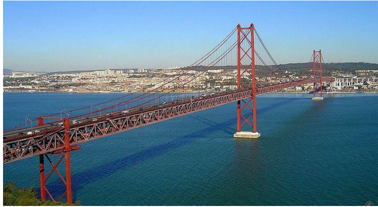
Figura 2.7 – Ponte 25 de Abril (FCT, 2013).
