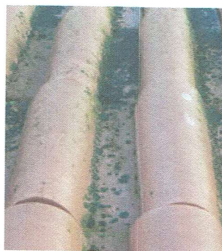
TELHAS FISSURADAS
