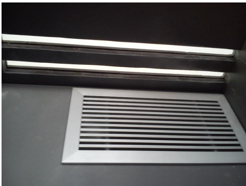
Figura.5-11 Instalação das grelhas de extração
