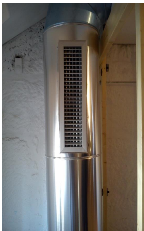
Figura 5-21 Aspeto final da instalação das grelhas na rede aerólica
