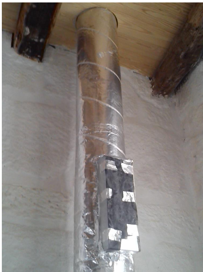
Figura.5-8 Isolamento da rede aerólica
