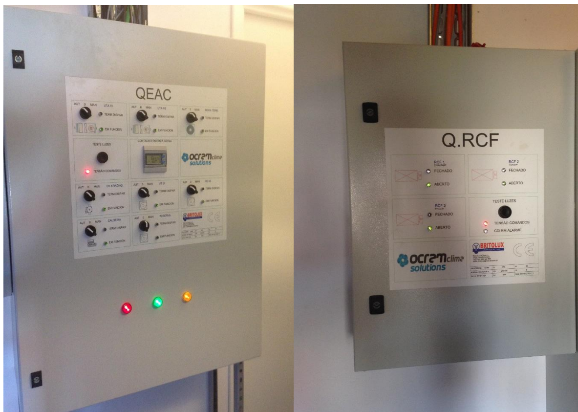
Figura 5-24 Instalação do QEAC e Q.RCF
