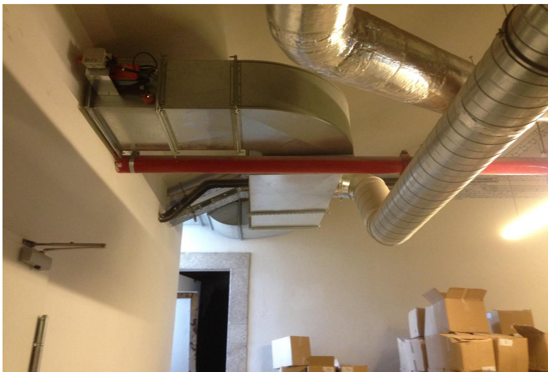
Figura 5-26 Instalação do registo corta-fogo na rede aerólica
