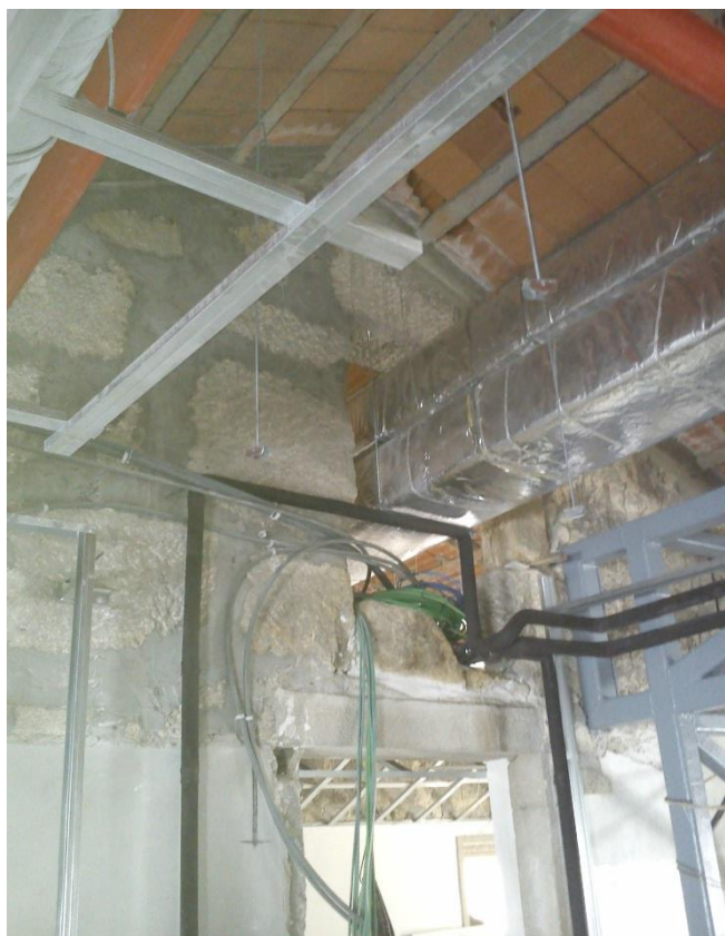
Figura 5-3 Passagem das condutas pelos negativos existentes
