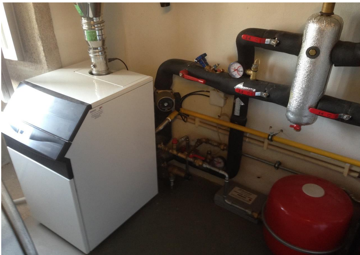
Figura 5-23 Instalação da caldeira Baxiroca Power HT, e respetiva instalação hidráulica
