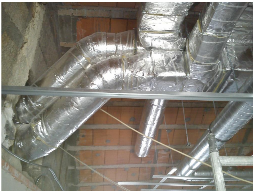
Figura.5-7 Material aplicado em obra depois de efetuado o levantamento de chapa
