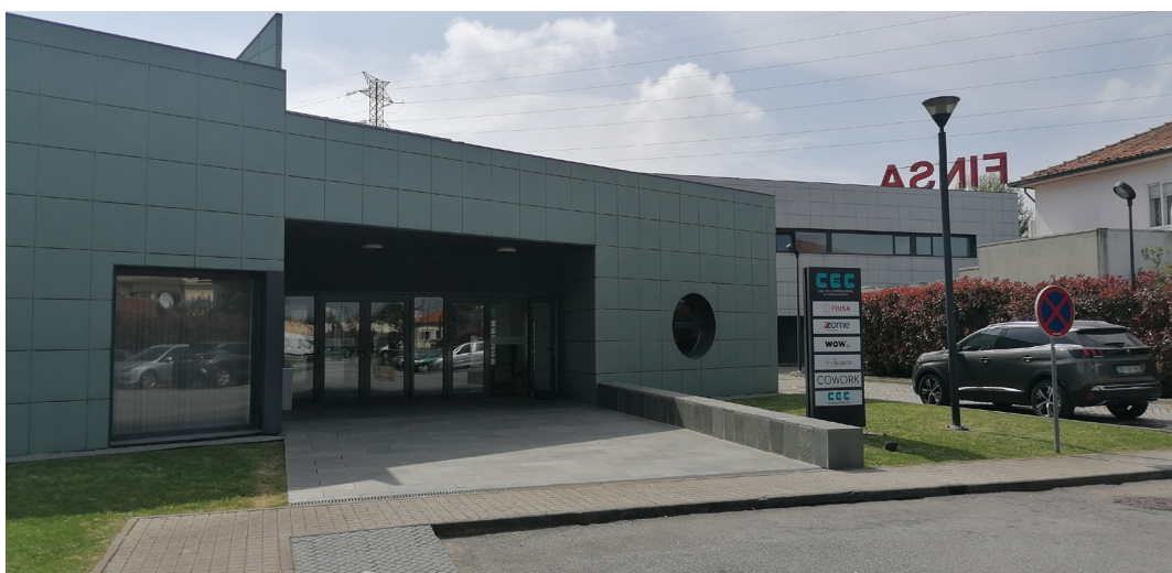
Figura 68. Entrada do edifício, Work on Wood by FINSA.
