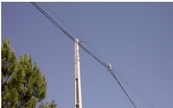
Figura 5.55: Sequência da passagem cabos.
