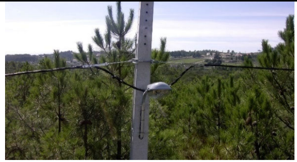
Figura 5.174: Apoios MT com rede BT.
