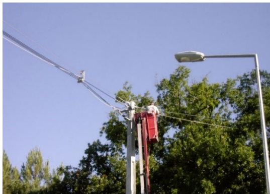
Figura 5.51: Sequência da passagem cabos.
