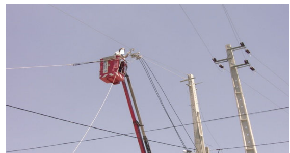
Figura 5.70: Sequência da passagem cabos.
