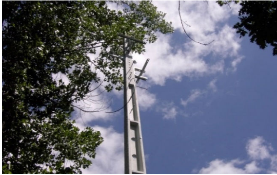
Figura 5.27: Travessas de Montagem BD 35.
