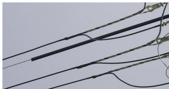
Figura 5.130: Ligação de condutores.
