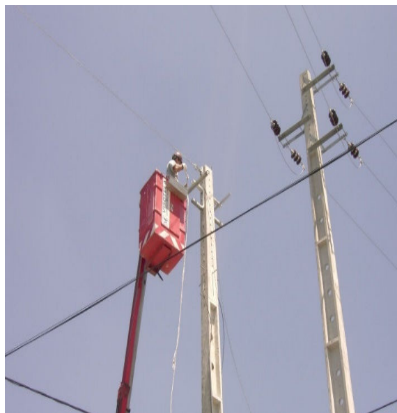
Figura 5.45: Início da passagem cabos.
