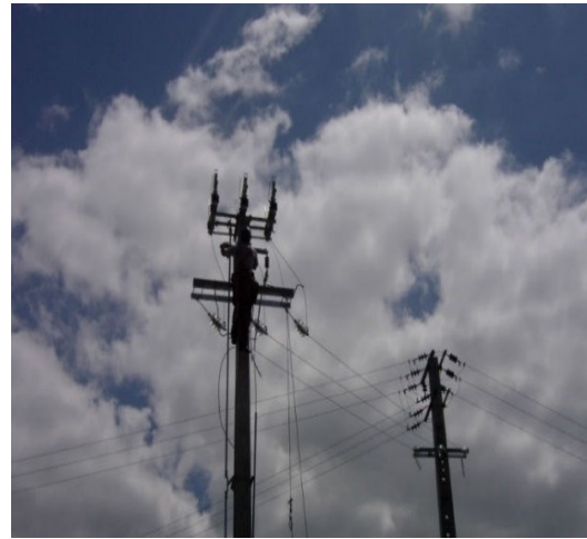
Figura 5.17: Travessas Montagem – Figura 5.18: Travessas Montagem. Amarração.
