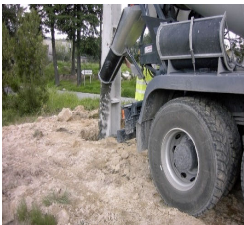
Figura 5.13: Betonagem.
