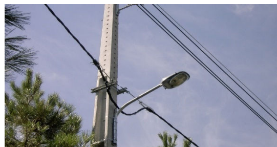
Figura 5.168: Apoios MT com rede BT.
