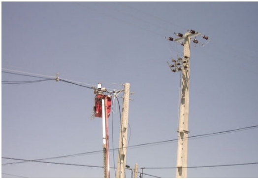
Figura 5.89: Execução de amarração.
