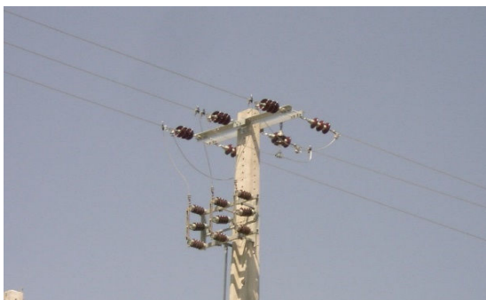
Figura 5.165: Seccionador loteamento
