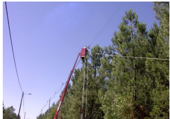
Figura 5.52: Sequência da passagem cabos.
