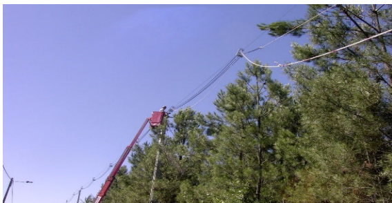
Figura 5.53: Sequência da passagem cabos.
