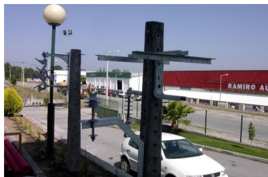
Figura 4.19: Estudo, Montagem das ferragens.
