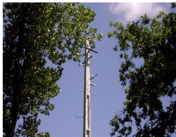
Figura 5.24: Travessas de Montagem BD 35.
