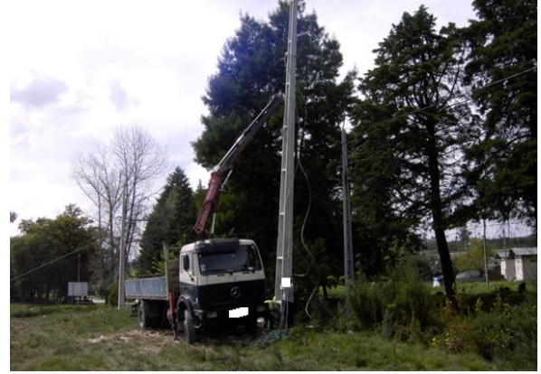
Figura 5.10: Arvoreamento apoio com auxílio grua.
