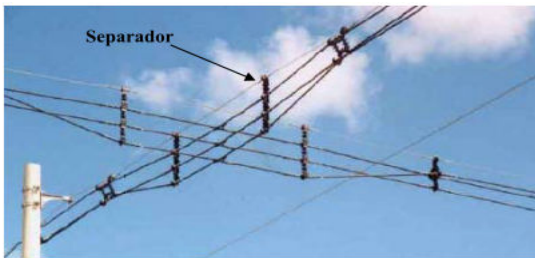
Figura 3.4: Uso de espaçadores em cruzamentos [8].
