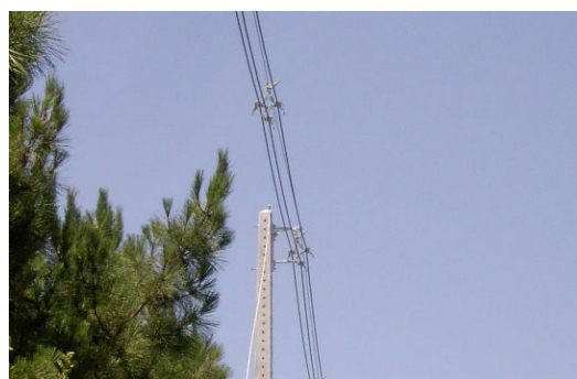
Figura 5.146: Condutores com espaçadores.
