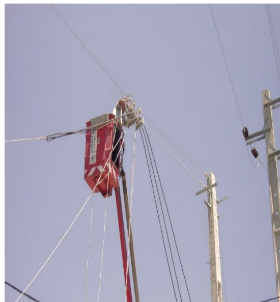
Figura 5.46: Sequência da passagem cabos.
