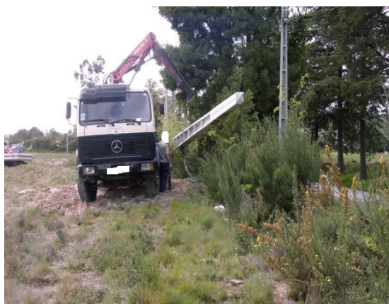
Figura 5.7: Arvoreamento apoio com auxílio grua. Figura 5.8: Arvoreamento apoio com auxílio grua.
