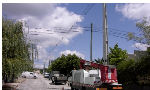
Figura 5.57: Sequência da passagem cabos.
