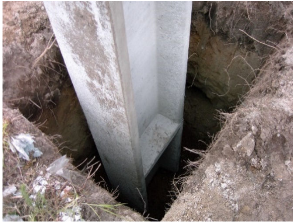
Figura 5.11: Arvoreamento apoio, já na cova.
