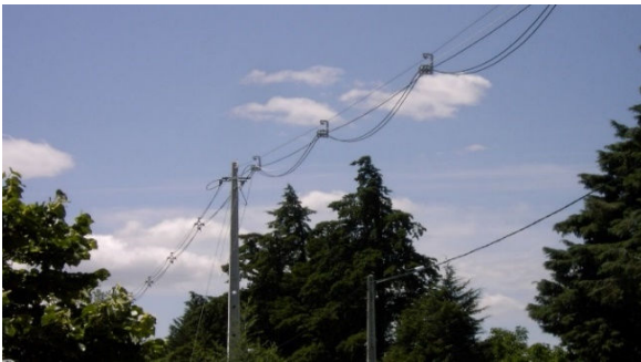
Figura 5.65: Sequência da passagem cabos.
