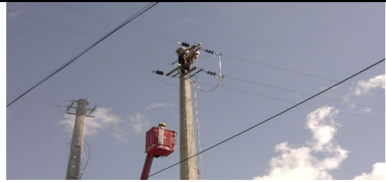
Figura 5.160: Seccionador loteamento
