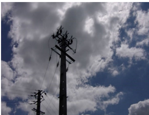
Figura 5.23: Travessas de Montagem.
