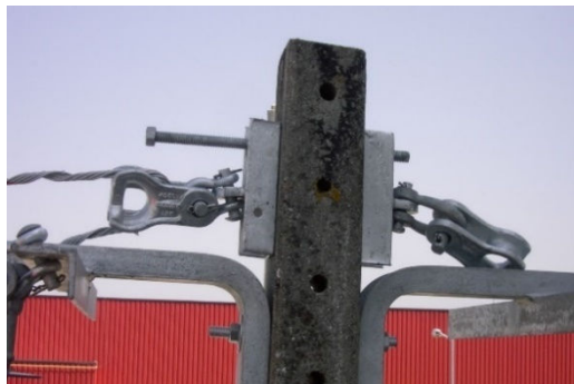
Figura 4.14: Estudo, Montagem das ferragens.
