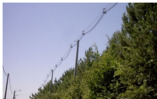
Figura 5.72: Sequência da passagem cabos.
