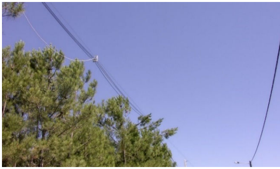
Figura 5.63: Sequência da passagem cabos.
