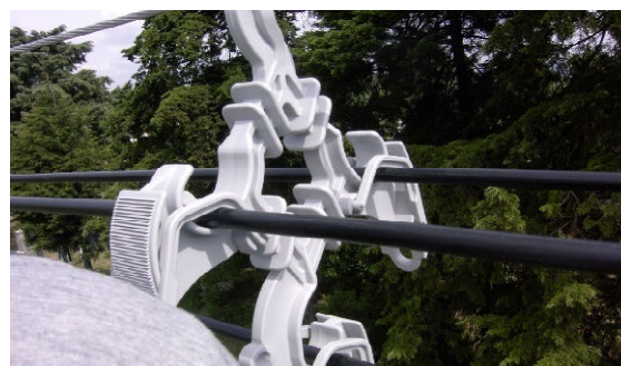
Figura 5.86: Sequência da colocação espaçadores.
