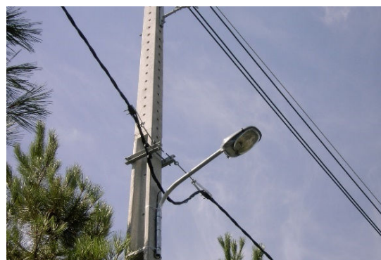
Figura 5.170: Apoios MT com rede BT.
