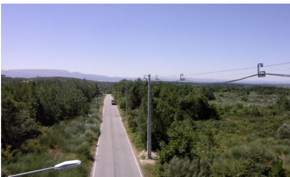
Figura 5.67: Sequência da passagem cabos.
