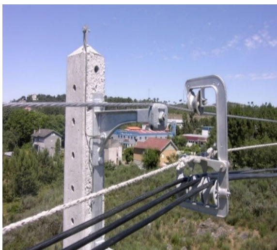
Figura 5.35: Montagem armação Lateral.
