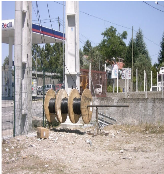
Figura 5.41: Colocação de bobines de cabo.
