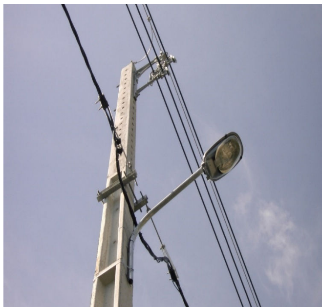
Figura 4.26: Dois níveis de tensão no mesmo apoio.
