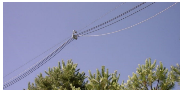
Figura 5.54: Sequência da passagem cabos.
