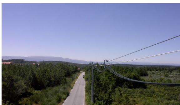
Figura 5.59: Sequência da passagem cabos.
