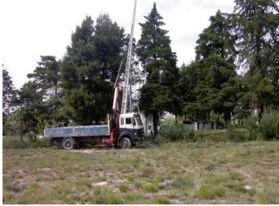
Figura 5.9: Arvoreamento apoio com auxílio grua.
