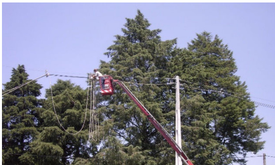
Figura 5.49: Sequência da passagem cabos.
