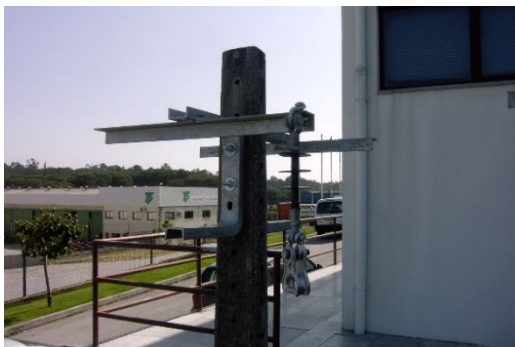
Figura 4.16: Estudo, Montagem das ferragens.
