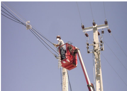
Figura 5.91: Execução de amarração.
