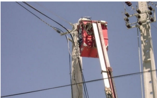
Figura 5.93: Execução de amarração.
