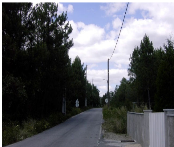
Figura 5.37: Colocação do cabo mensageiro.
