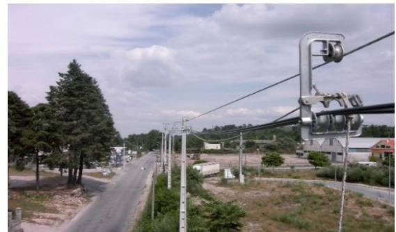
Figura 5.50: Sequência da passagem cabos.
