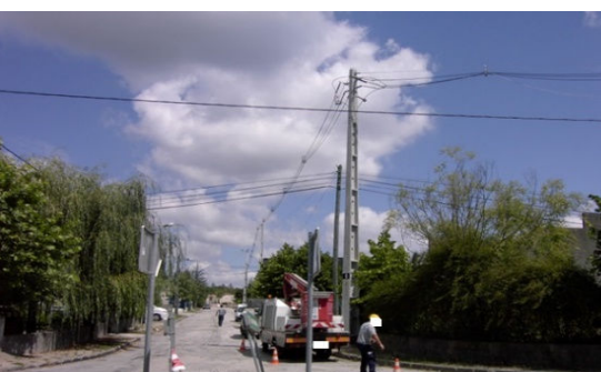
Figura 5.78: Sequência da passagem cabos.
