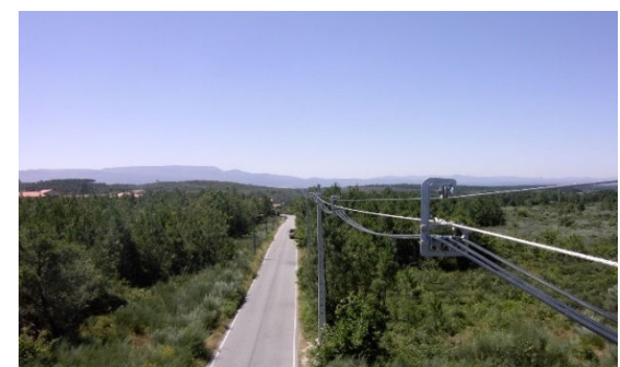
Figura 5.60: Sequência da passagem cabos.
