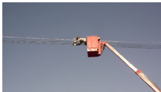
Figura 5.84: Sequência da colocação espaçadores.
