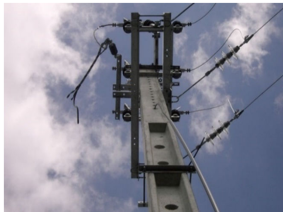
Figura 5.22: Travessas Montagem.
