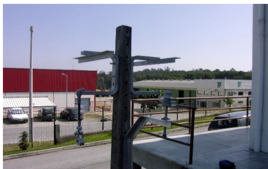
Figura 4.18: Estudo, Montagem das ferragens.
