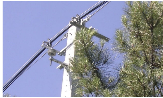
Figura 5.64: Sequência da passagem cabos.
