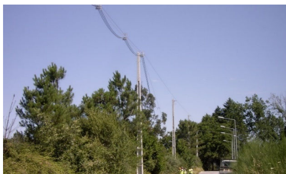
Figura 5.71: Sequência da passagem cabos.
