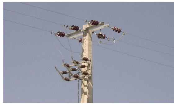
Figura 5.166: Seccionador loteamento
