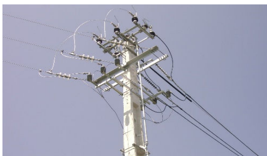
Figura 5.127: Ligação de condutores.
