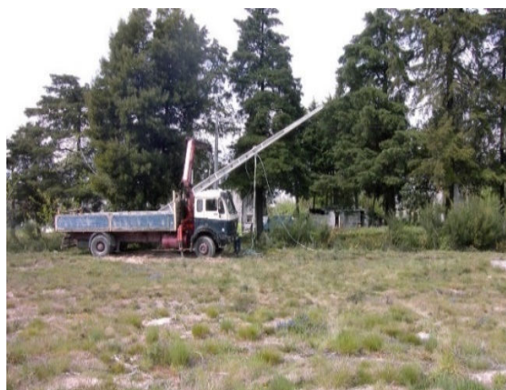
Figura 5.7: Arvoreamento apoio com auxílio grua. Figura 5.8: Arvoreamento apoio com auxílio grua.
