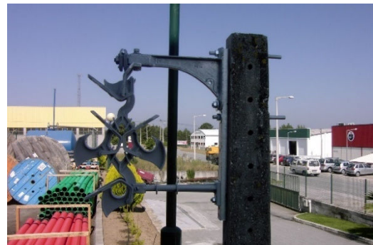
Figura 4.15: Estudo, Montagem das ferragens.
