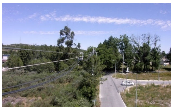
Figura 5.73: Sequência da passagem cabos.
