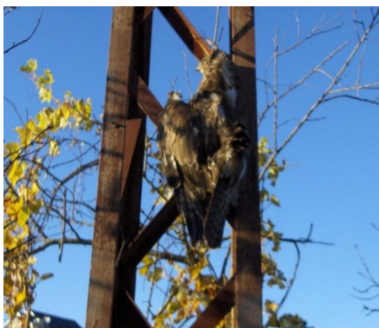
Figura 3.12: Consequências do contacto direto de aves com a linha de MT.
