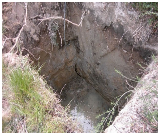
Figura 5.4: Abertura de cova concluída.
