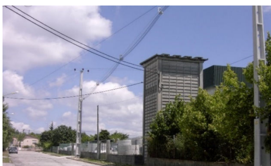
Figura 5.76: Sequência da passagem cabos.
