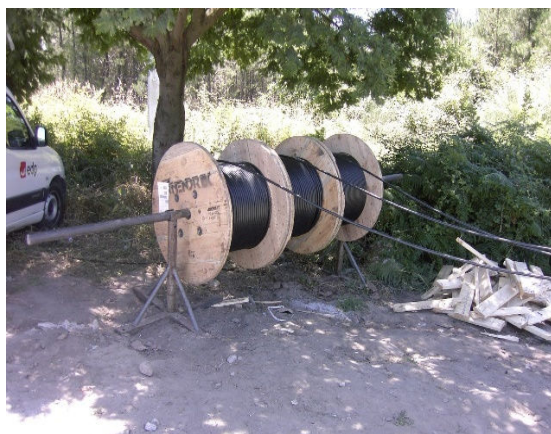
Figura 5.43: Colocação de bobines de cabo.
