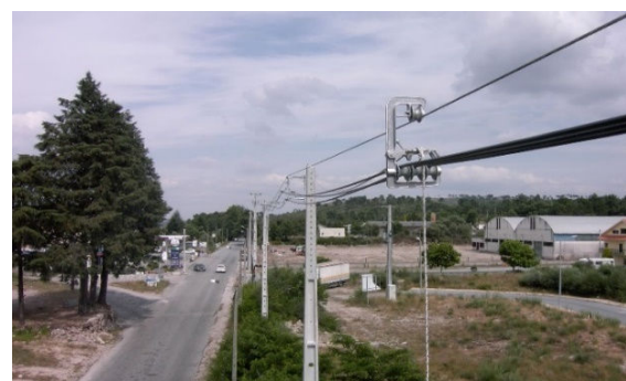
Figura 5.58: Sequência da passagem cabos.
