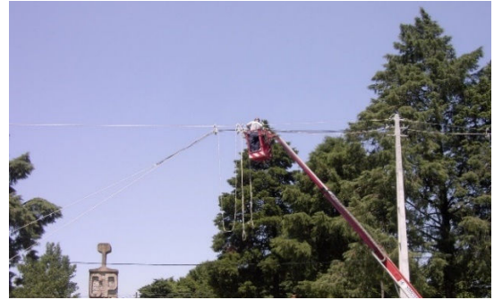
Figura 5.48: Sequência da passagem cabos.
