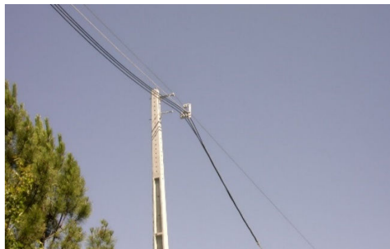
Figura 5.56: Sequência da passagem cabos.
