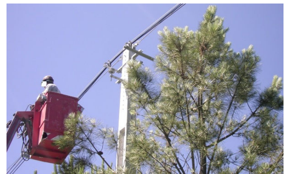
Figura 5.68: Sequência da passagem cabos.
