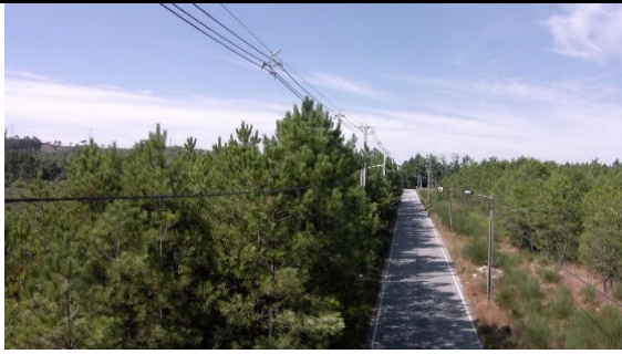
Figura 5.173: Apoios MT com rede BT.
