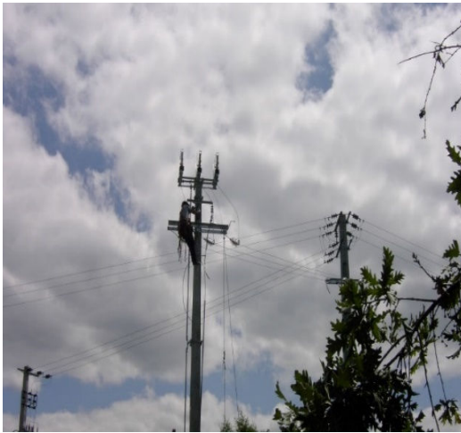
Figura 5.17: Travessas Montagem – Figura 5.18: Travessas Montagem. Amarração.
