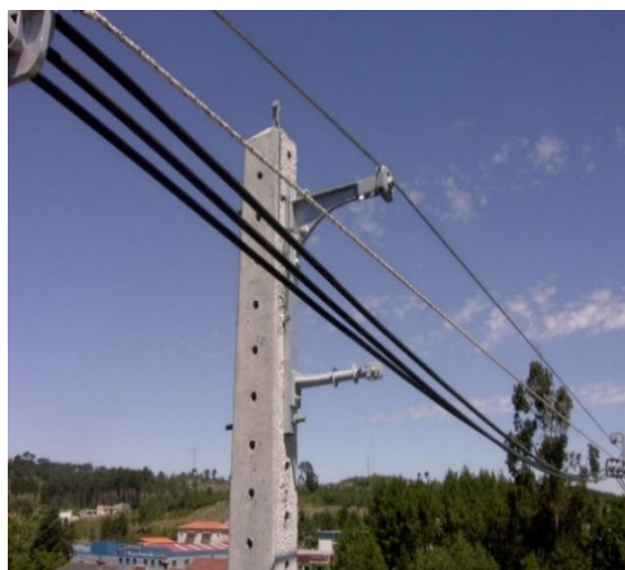
Figura 5.36: Montagem armação Lateral.
