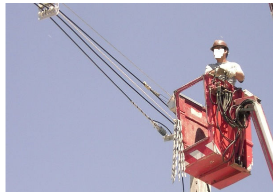
Figura 5.92: Execução de amarração.
