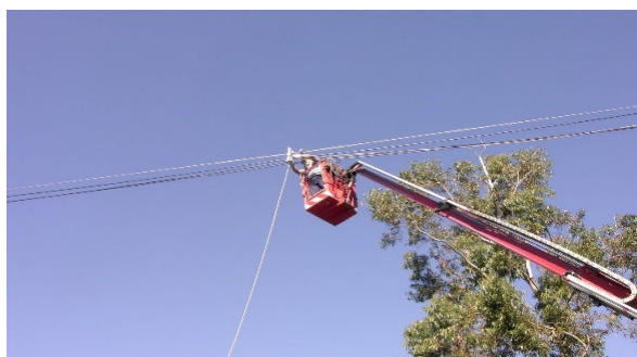
Figura 5.85: Sequência da colocação espaçadores.
