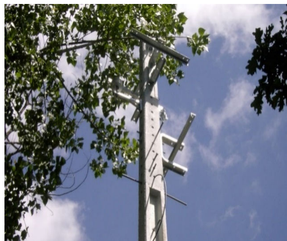
Figura 5.26: Travessas de Montagem BD 35.
