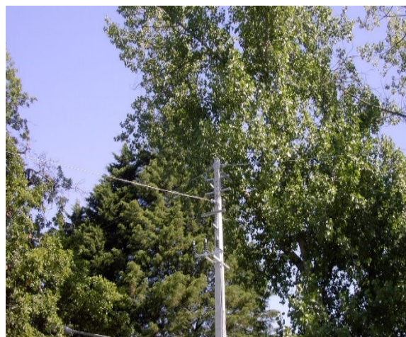
Figura 5.38: Colocação do cabo mensageiro.
