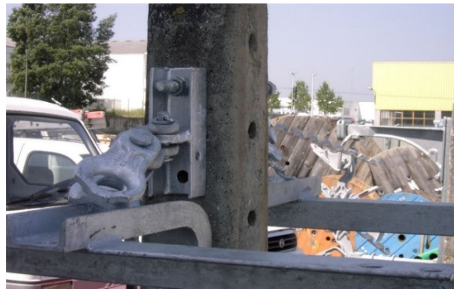
Figura 4.13: Estudo, Montagem das ferragens.
