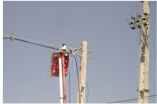
Figura 5.90: Execução de amarração.
