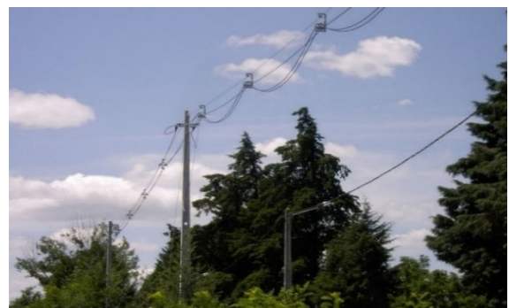
Figura 5.61: Sequência da passagem cabos.
