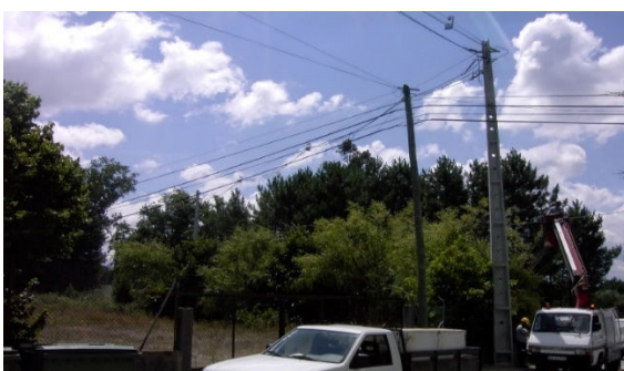
Figura 5.77: Sequência da passagem cabos.
