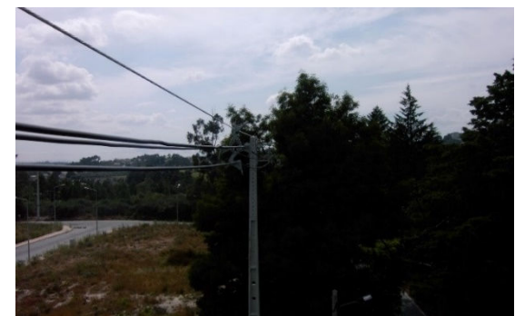
Figura 5.62: Sequência da passagem cabos.
