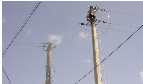
Figura 5.162: Seccionador loteamento
