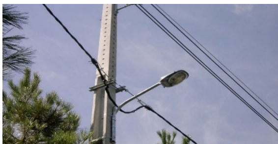
Figura 5.167: Apoios MT com rede BT.
