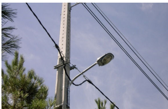
Figura 5.169: Apoios MT com rede BT.
