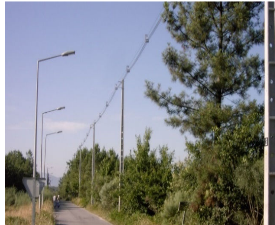
Figura 5.80: Sequência da passagem cabos.
