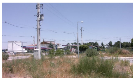
Figura 5.75: Sequência da passagem cabos.
