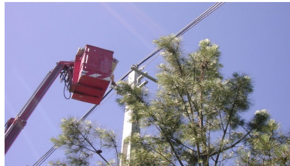
Figura 5.66: Sequência da passagem cabos.
