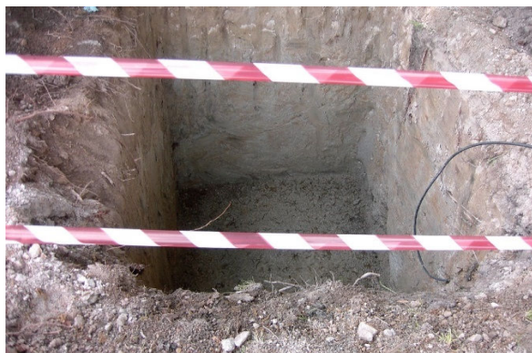
Figura 5.5: Abertura de cova com sinalização.
