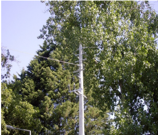
Figura 5.39: Colocação do cabo mensageiro
