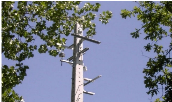
Figura 5.29: Travessas de Montagem BD 35.
