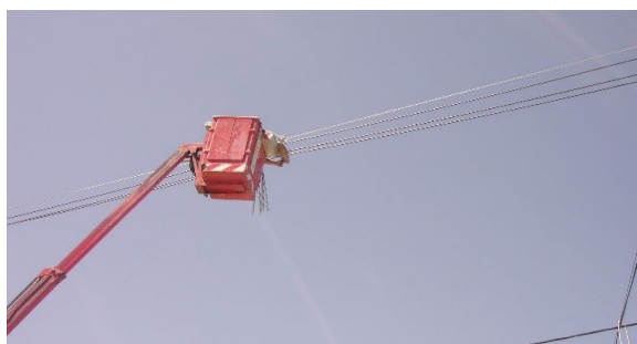
Figura 5.87: Sequência da colocação espaçadores.
