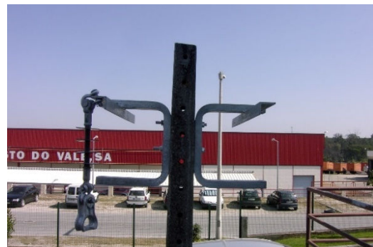
Figura 4.17: Estudo, Montagem das ferragens.
