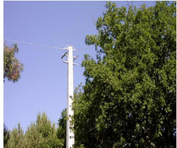
Figura 5.40: Colocação do cabo mensageiro.
