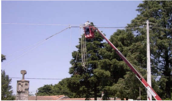
Figura 5.47: Sequência da passagem cabos.
