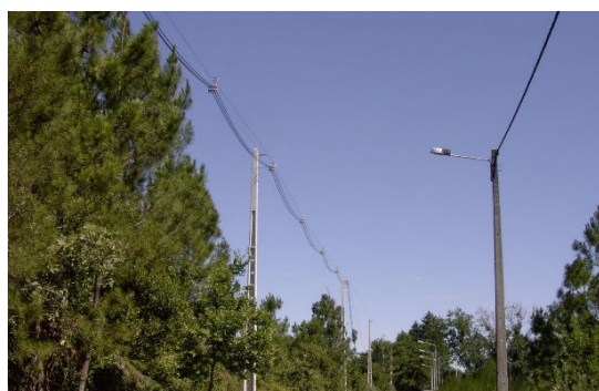
Figura 5.74: Sequência da passagem cabos.
