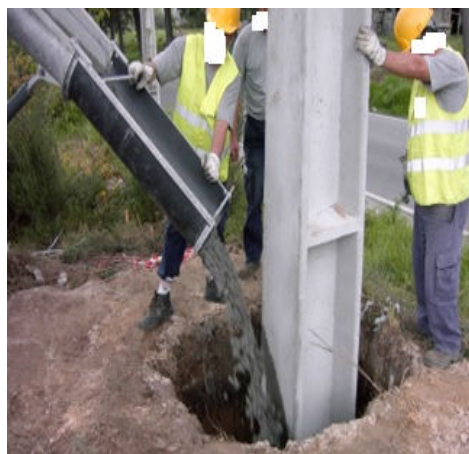
Figura 5.14: Betonagem.
