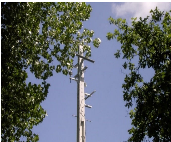
Figura 5.25: Travessas de Montagem BD 35.
