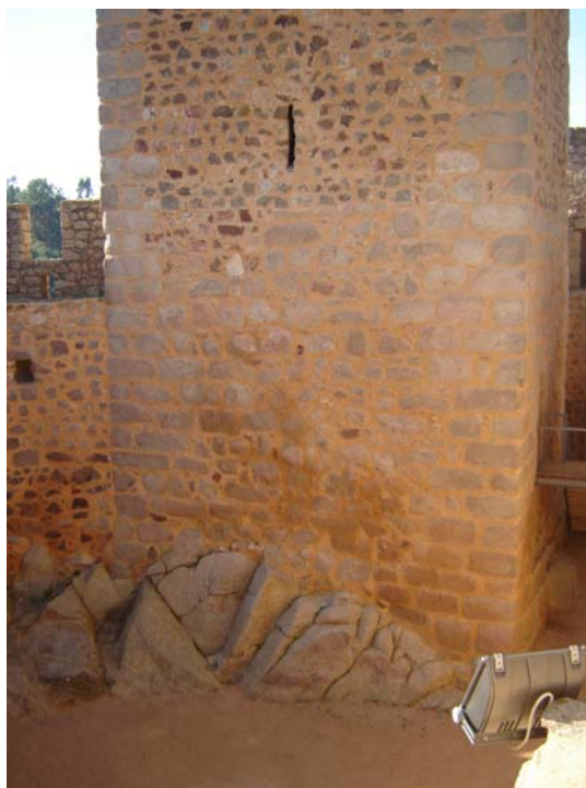
Figura 98. Aspeto da torre de menagem do castelo de Almourol depois da intervenção.
