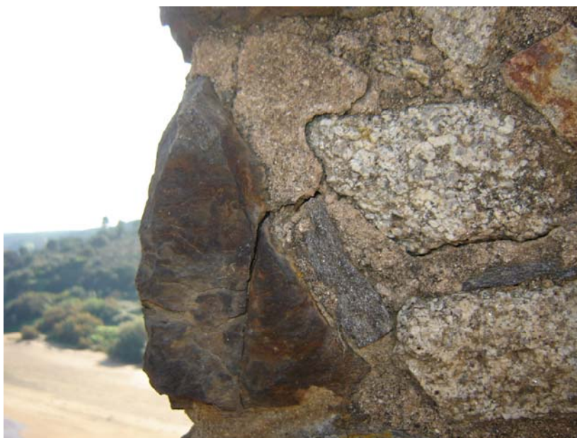
Figura 107. Fratura na ligação.
