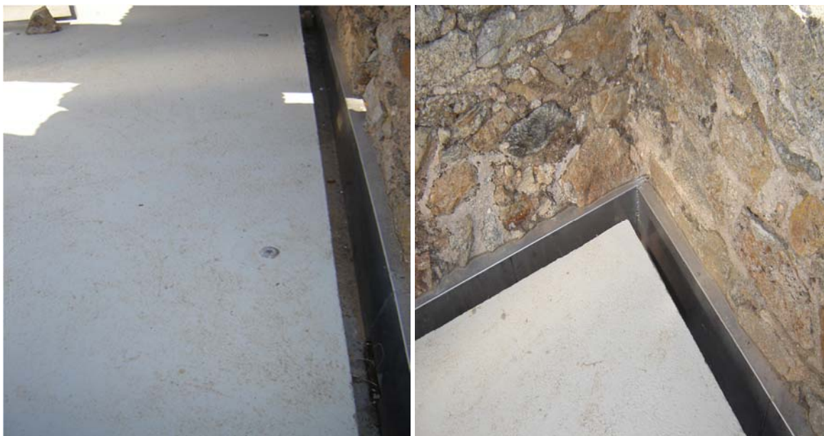
Figura 100. Após a intervenção no terraço da torre de menagem.
