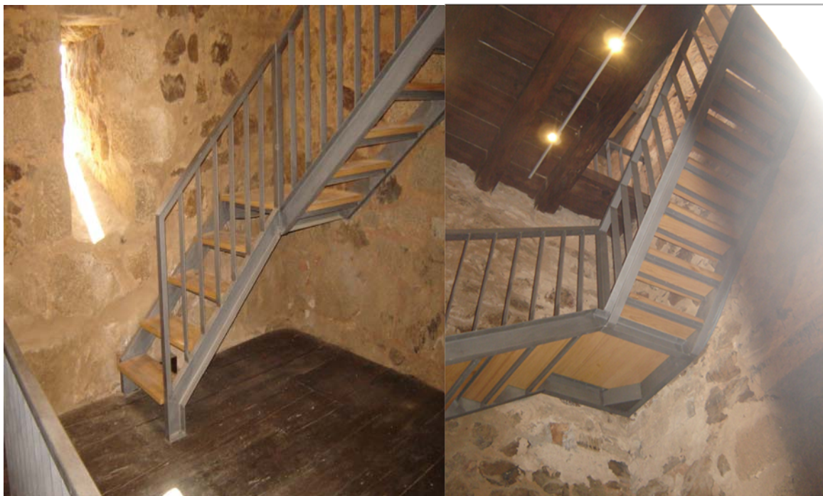
Figura 102. Colocação de iluminação e uma escada de circulação interior da torre de menagem.
