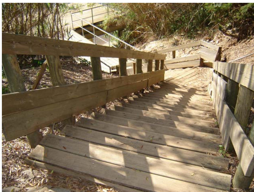
Figura 118. Escada de acesso ao cais de embarque fluvial.
