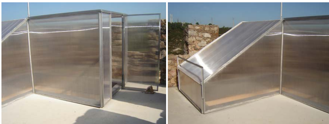
Figura 101. Colocação de proteção no terraço da torre de menagem do castelo de Almourol.
