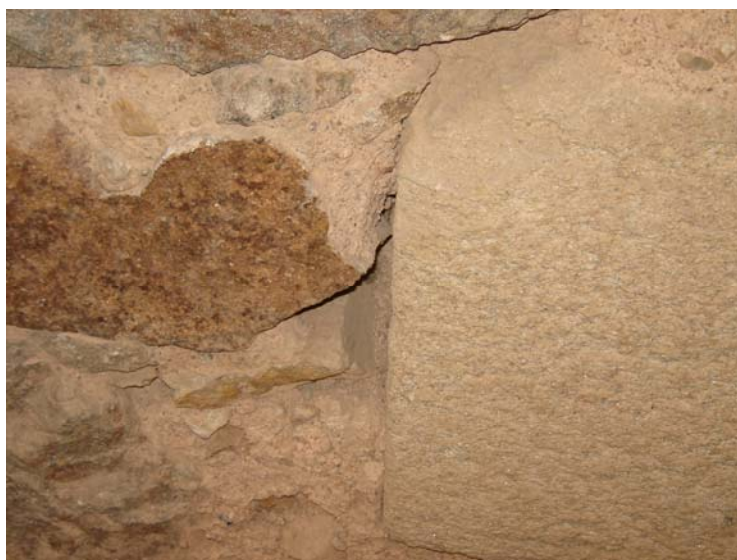
Figura 111. Rocha fraturada no interior da torre de menagem.
