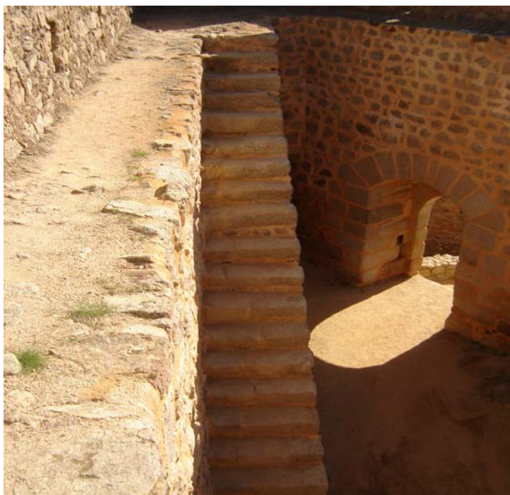
Figura 116. Escadas de acesso ao adarve.
