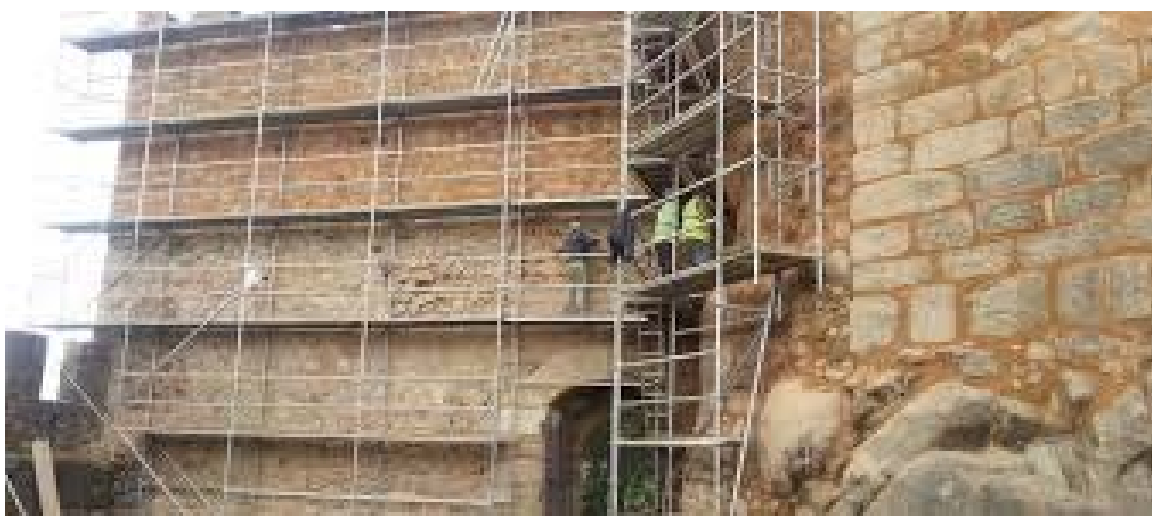
Figura 96. Intervenção no interior das muralhas do castelo de Almourol.
