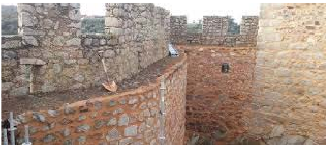
Figura 94. Intervenção no interior das muralhas do castelo de Almourol.
