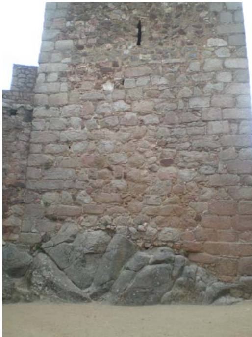
Figura 97. Aspeto da torre de menagem do castelo de Almourol antes da intervenção.
