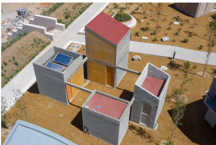
Figura 15- Protótipo de habitação social modular, o espaço vazio pode ser usado para ampliações futuras - México - Laboratório de Habitação social de APAN -Escritório de Tatiana Bilbao
