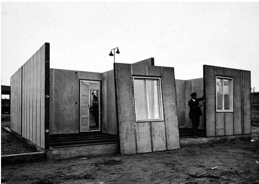
Figura 27 - Montagem da Casa de Cobre - Gropius
