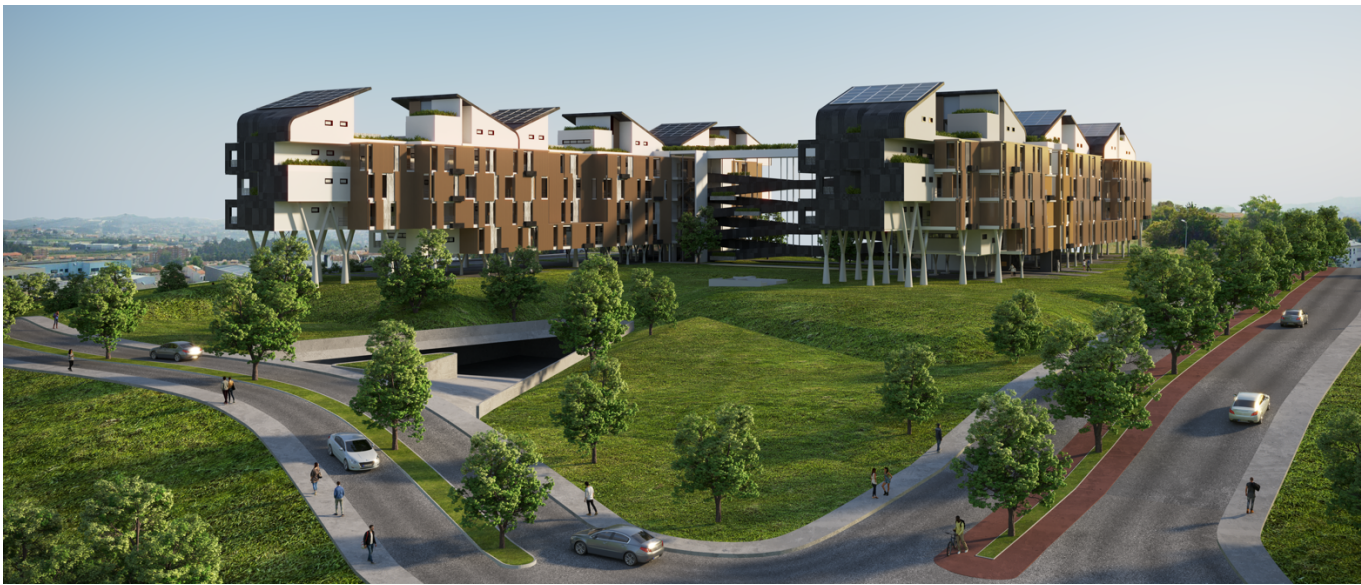
Figura 49 - Edifício habitacional Vista posterior
