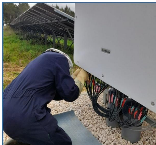
Figura 7 - Trabalhos elétricos em tensão numa CF
