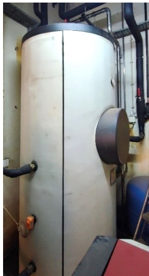
Figura 2.31 - Depósito de AQS (1 500 l) instalado na central térmica do edifício
