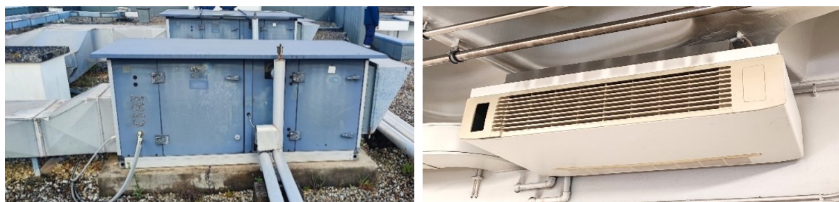
Figura 2.11 - Da esquerda para a direita: unidade de tratamento de ar e termoventilador instalado no edifício
