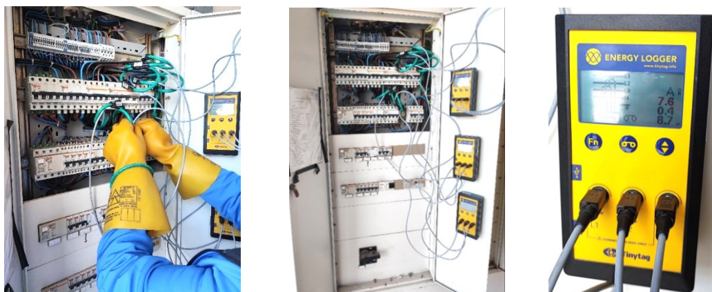
Figura 3.6 - Monitorizações a circuitos e equipamentos com impacto significativo na faturação energética anual do edifício
