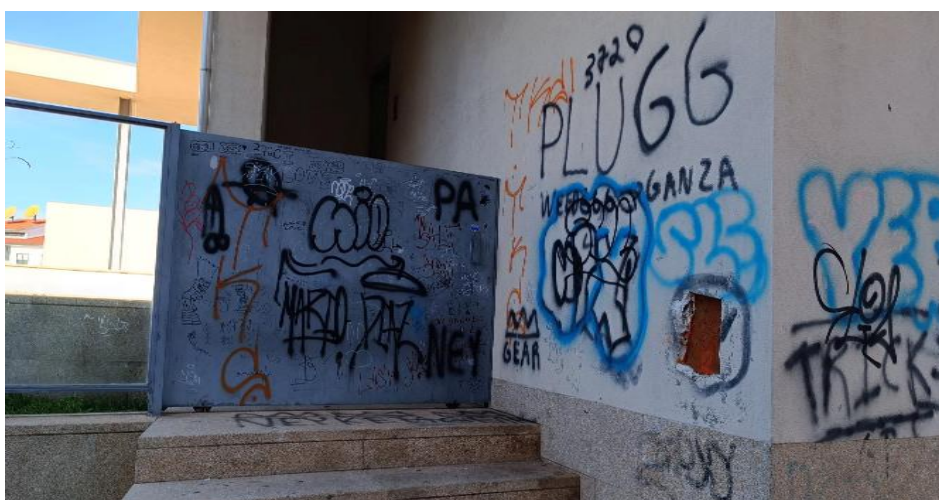
Figura 4 - Registo fotográfico da Biblioteca Municipal (elaborado pelo autor, 2024)
