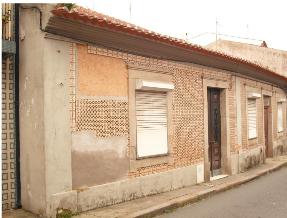
Aspecto da fachada em 2011
