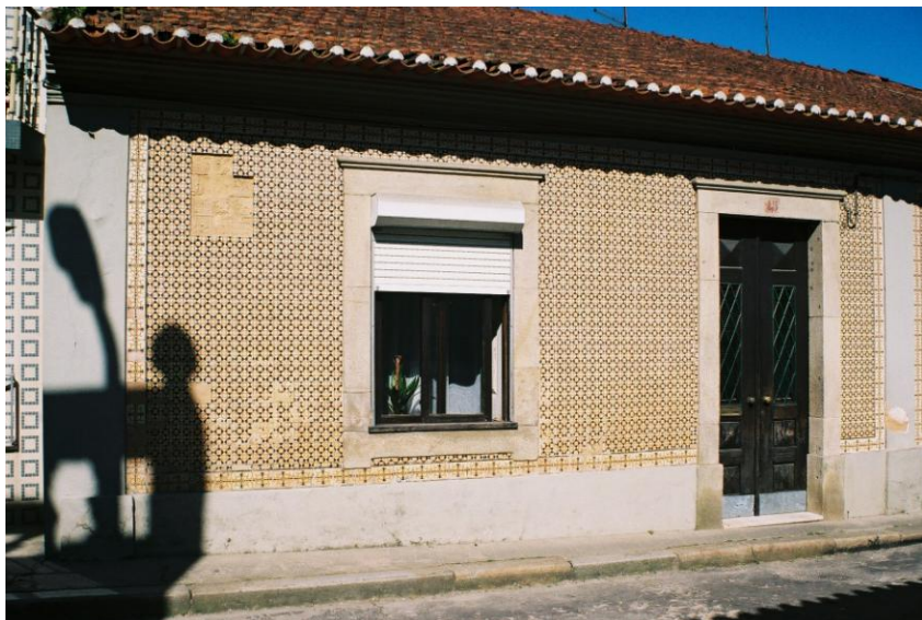
Aspecto da fachada em 2005
