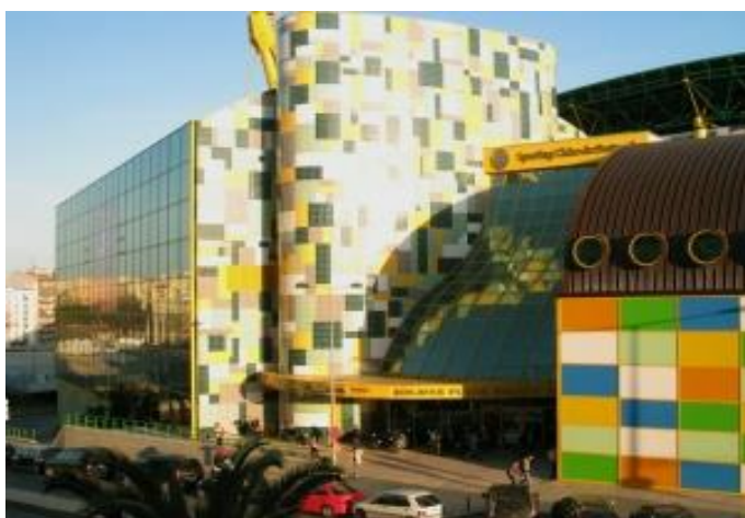
Figura 2- Vista exterior do pavilhão multidesportivo (imagem retirada do bloge "wiki sporting")
