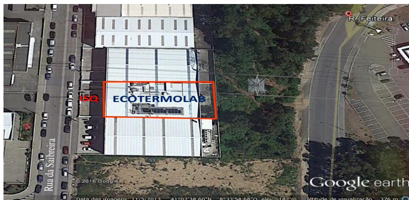
Figura 6 – Edifício ECOTERMOLAB, ISQ
