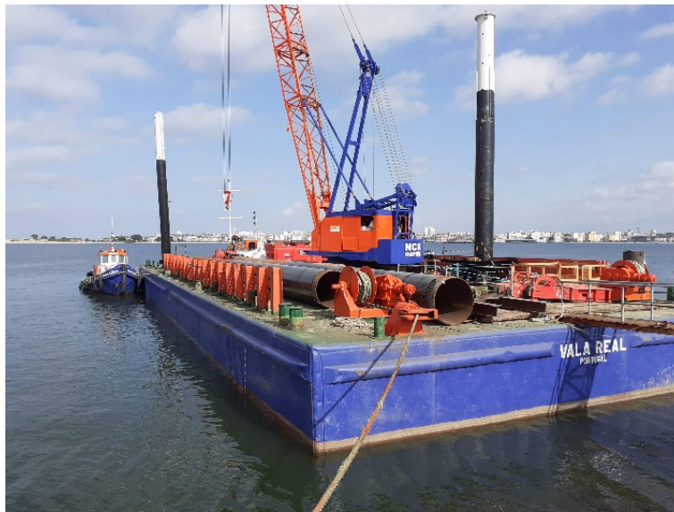
Figura 21 - Mobilização de estacas para a cravação
