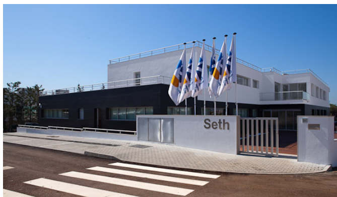
Figura 14 - Sede Queijas Exterior
