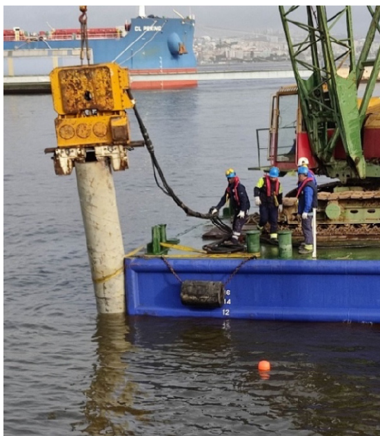
Figura 19 - Trabalhos de reparação da estaca danificada
