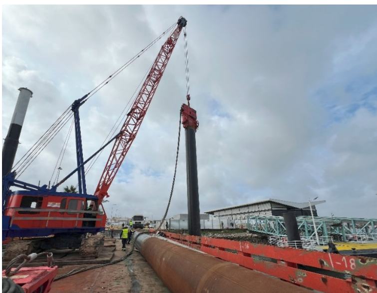
Figura 22 - Cravação de estaca
