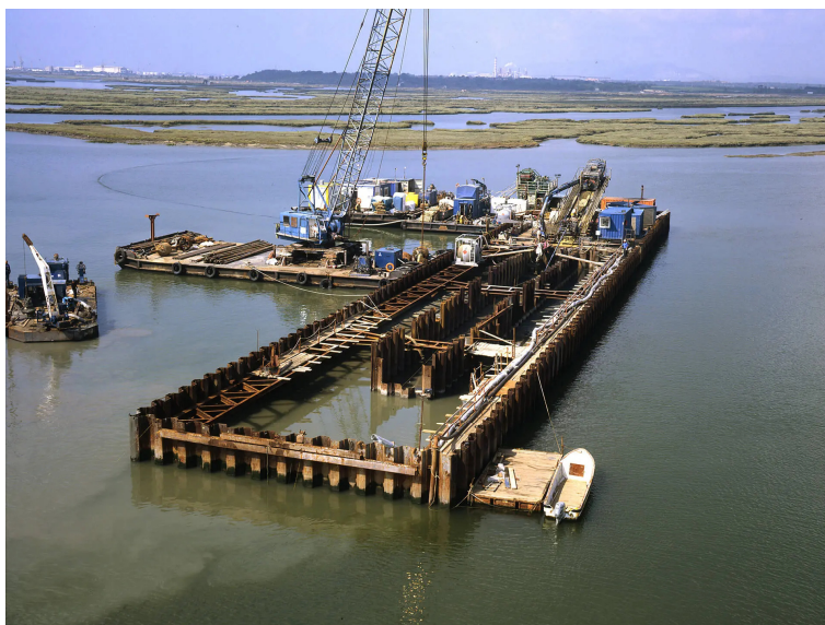
Figura 5 - Ensecadeira de estacas prancha
