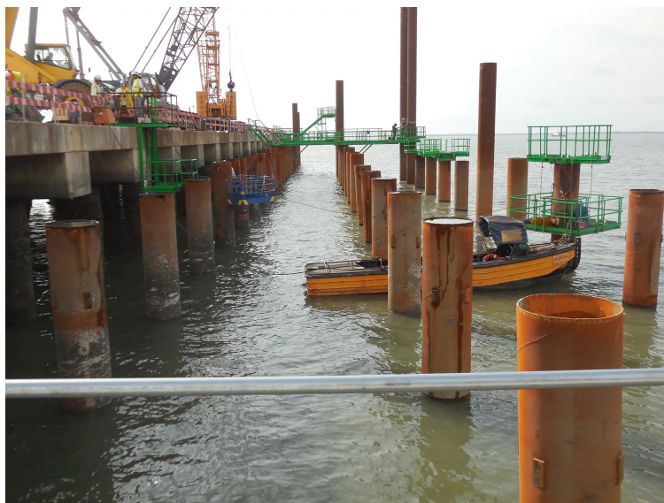
Figura 6 - Construção de cais com estacas tubulares
