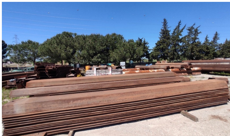
Figura 3 - Exemplo de estacas prancha
