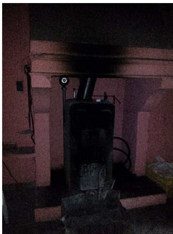
Figura 3. 15 – Aspeto da caldeira instalada no Edifício Sede.
