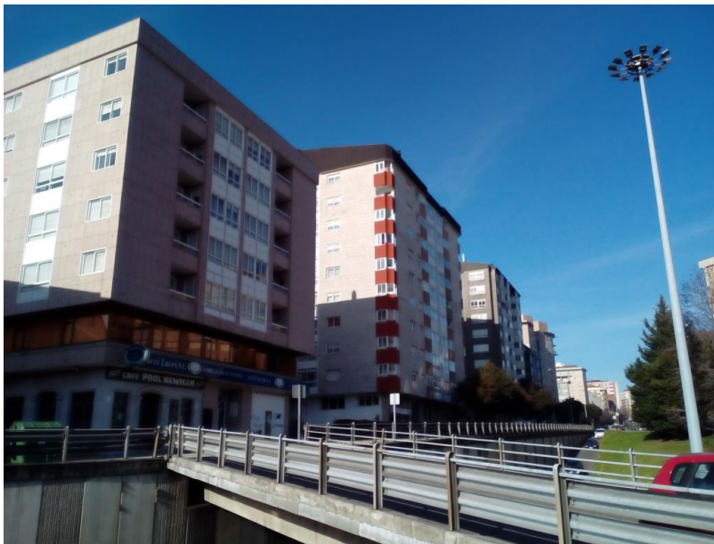
30. Envoltorio de la zona de intervención.
