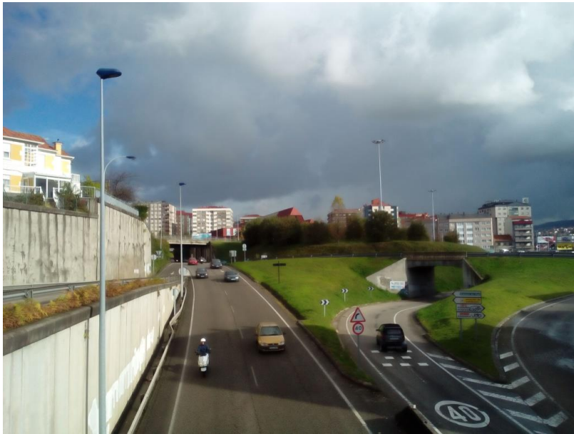
52. Vista de la estación y parque desde el puente de la calle Emilia Pardo Bazán.
