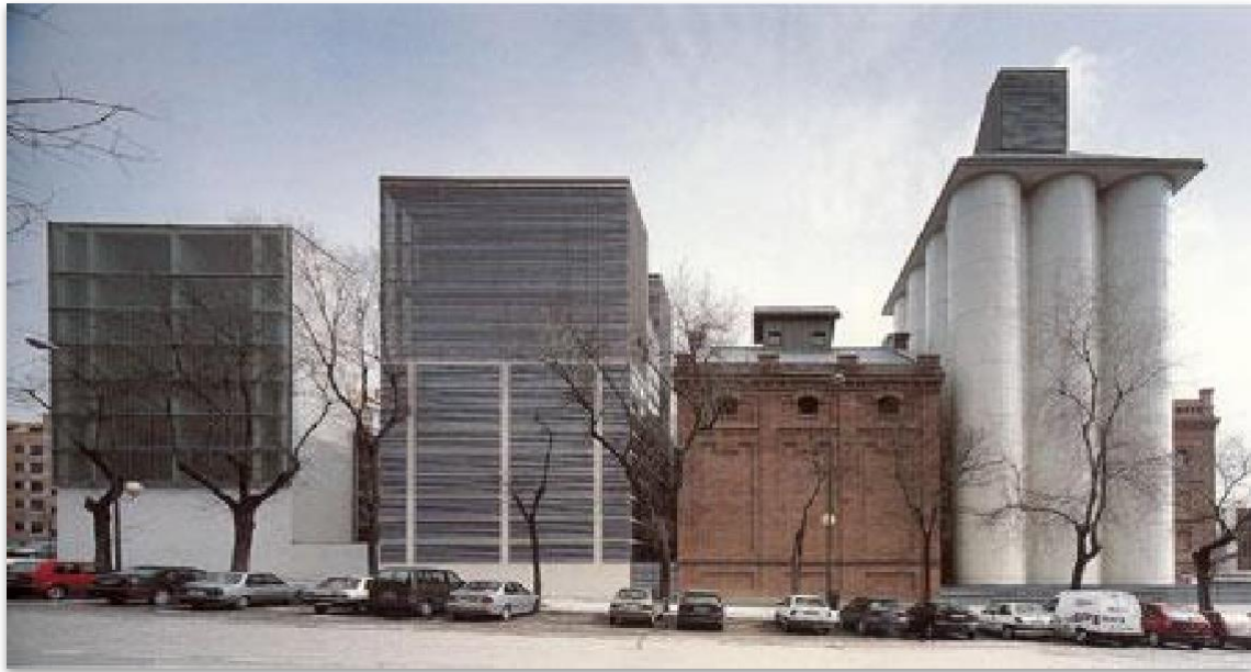
Fig.6. La fábrica de cerveza “El águila” y las demás construcciones a posteriori.
