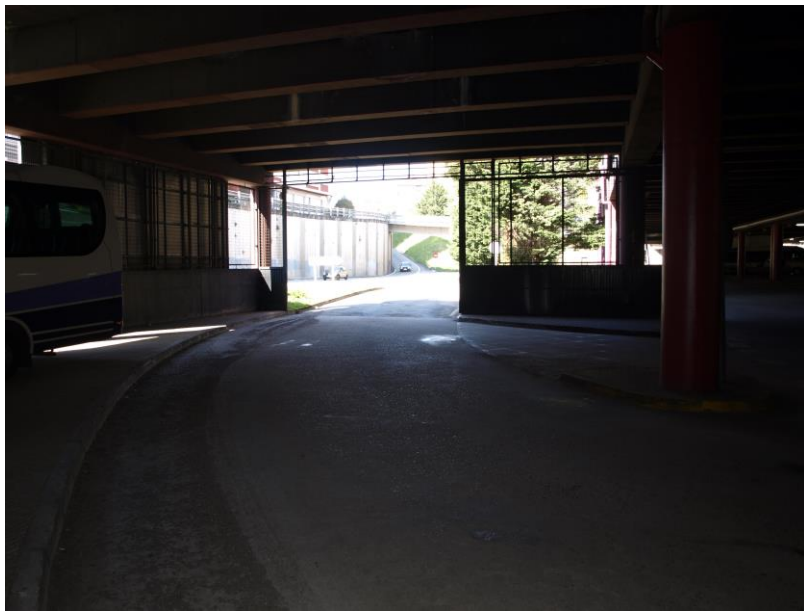
78. Entrada de vehículos de transporte a la estación.
