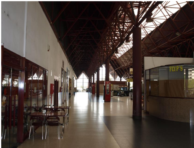
84. Configuración de una de las naves que componen la estructura de la cubierta.
