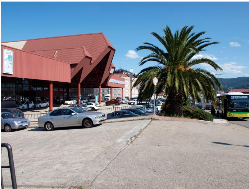
39. Imagen del desnivel del parking en relación a la Avd. de Madrid.
