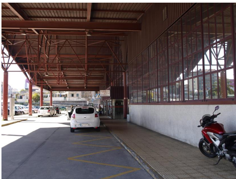
63. Zona de estacionamiento de la fachada principal.
