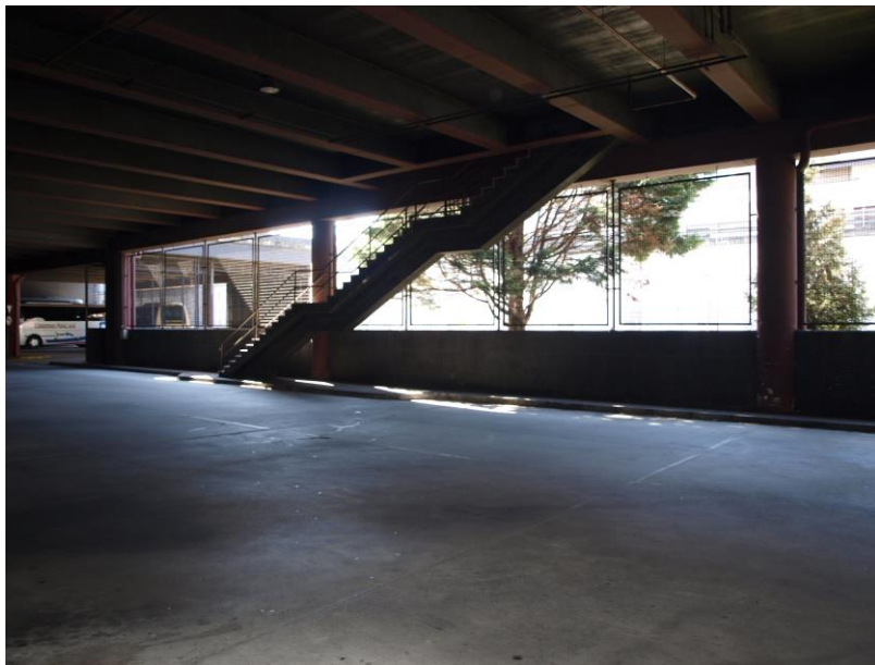
69. Escaleras que conducen a las dársenas.
