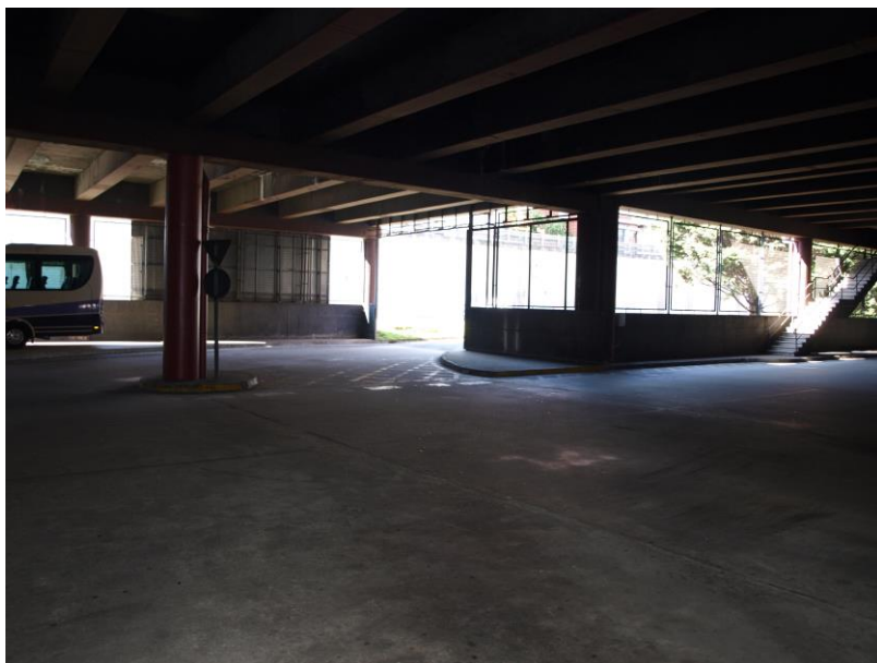
77. Entrada de vehículos de transporte a la estación.
