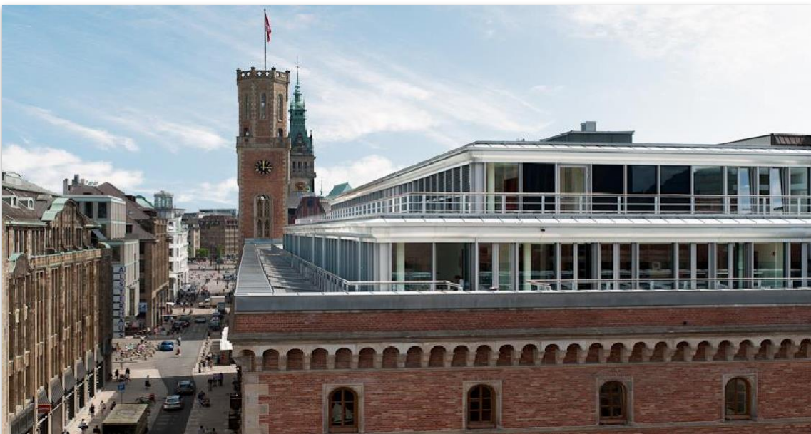
Fig.4. El “Alte Post” de Hamburgo y su intervención de reutilización
