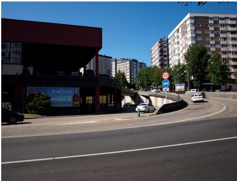
12. Viales que rodean a la estación.
