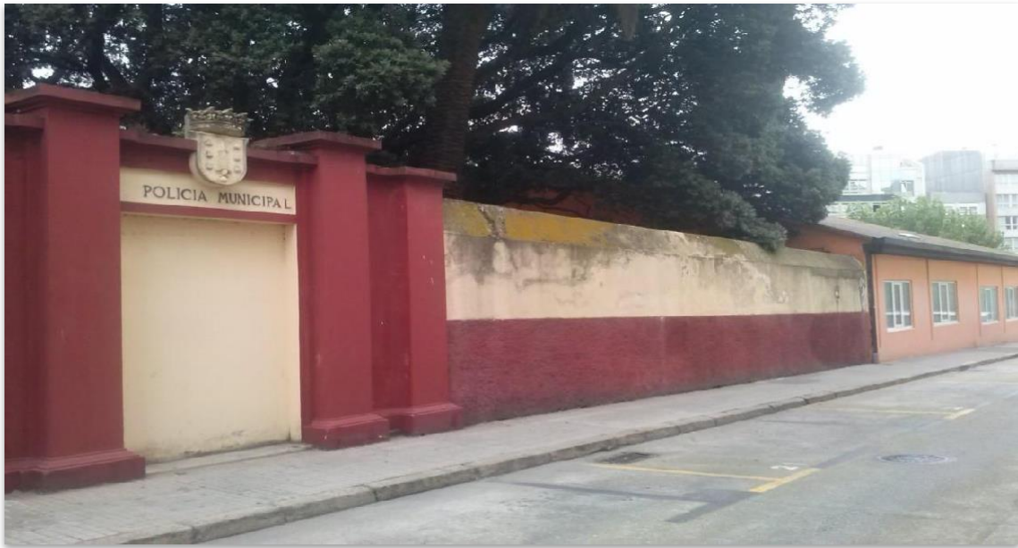
Fig.8. Antigua entrada al centro hospitalario, actualmente tapiada.
