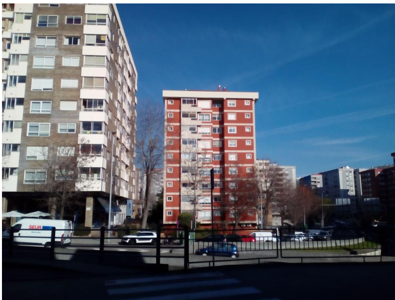
19.Fachada de edificio residencial cercano a la estación.
