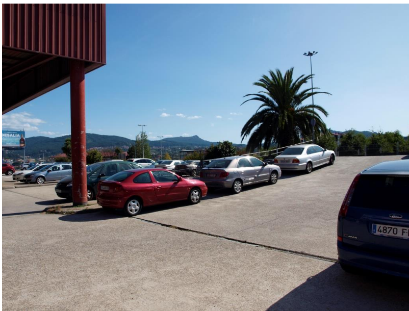
40. Imagen del desnivel del parking en relación a la Avd. de Madrid.
