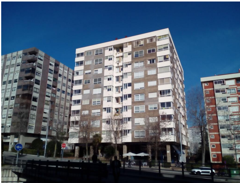
18.Fachada de edificio residencial cercano a la estación.
