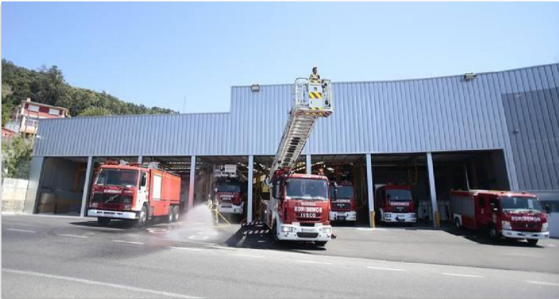
Fig. 13. La nueva fachada del parque de bomberos de Teis.
