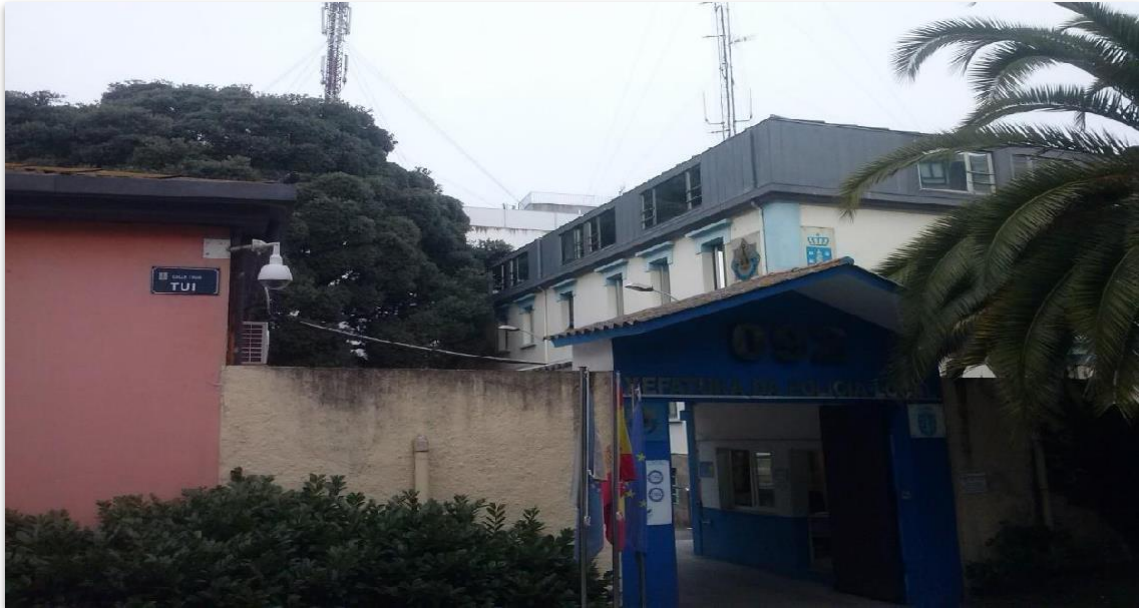
Fig.9. Entrada actual a la jefatura, y la edificación principal.
