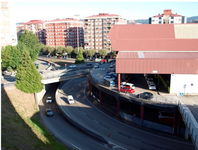
25. Vista de la estación desde una de las viviendas colindantes.
