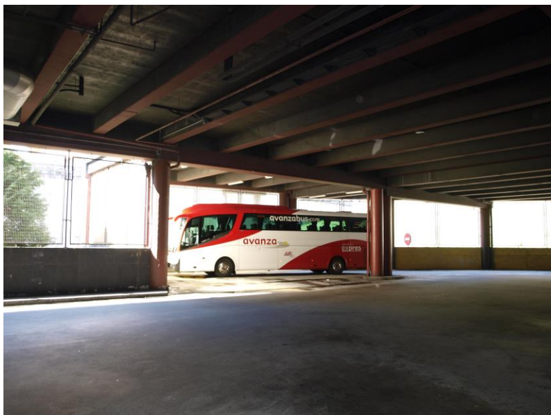
71. Espacio residual que conectaría con el segundo sótano de la estación.
