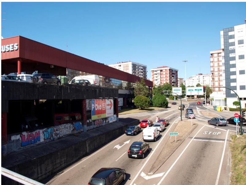
41. Final de la Avd. Antonio Palacios en la estación de autobuses.
