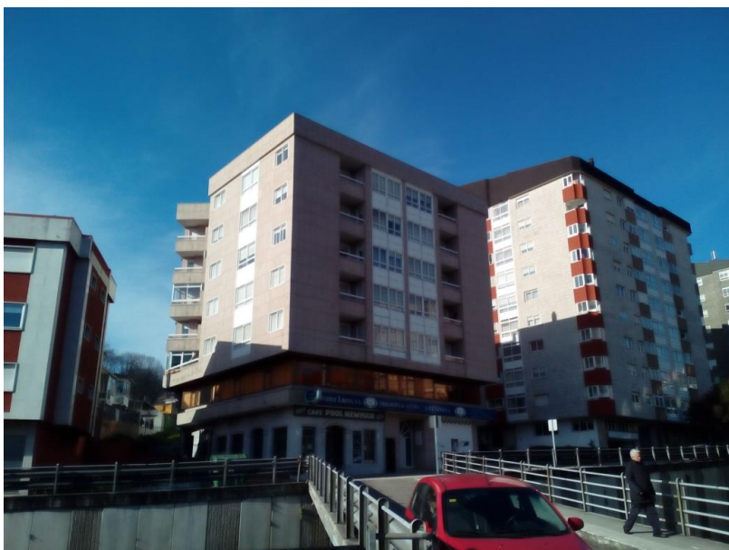
29.Fachada de edificio residencial cercano a la estación.
