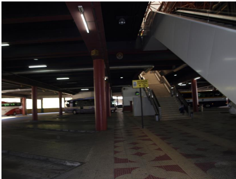
81. Escaleras de uso público que conectan la planta -1 a la planta principal.
