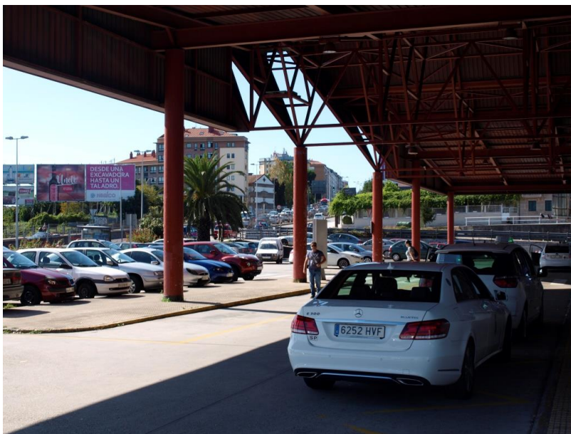
46. Parking y estructura metálica de la cubierta de la estación.
