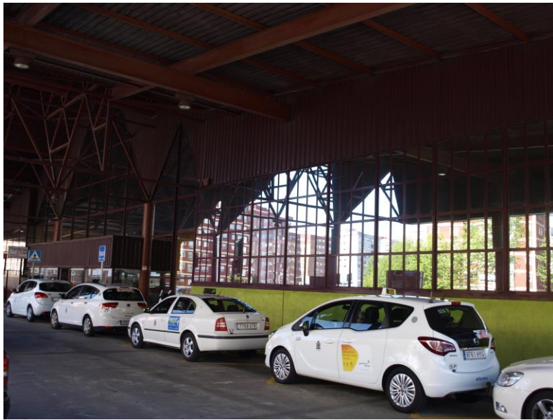
56. Fachada posterior bajo la cubierta.
