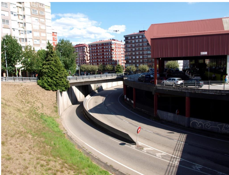
24. Puente y viales que rodean la estación.
