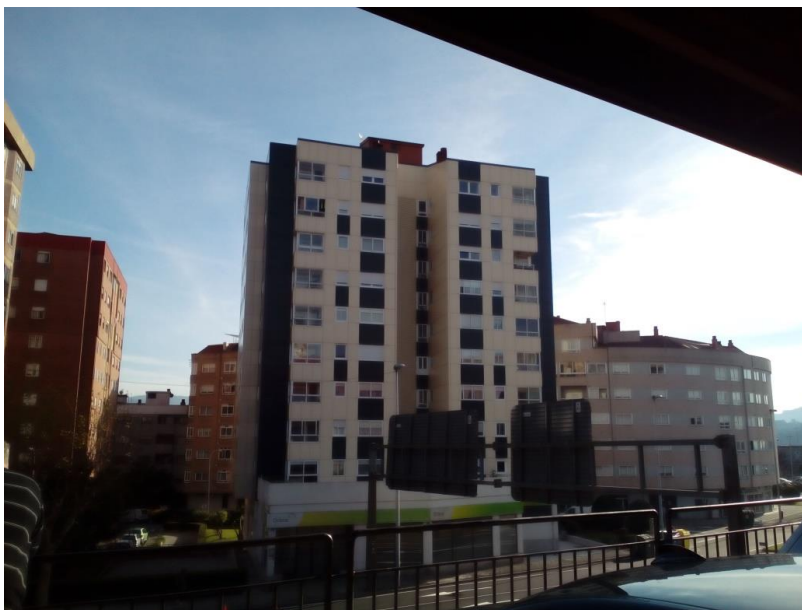
22. Fachada de edificio residencial cercano a la estación.
