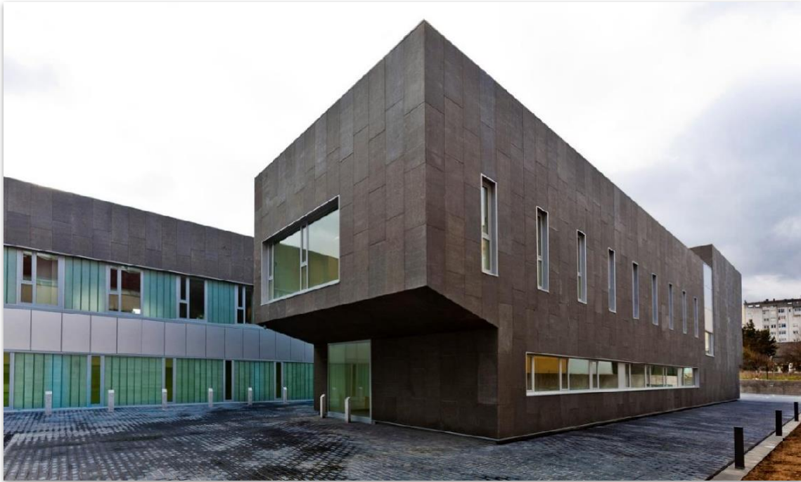
Fig.21.Fachada principal del anexo de la protección civil.
