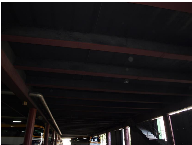
80. Estructura metálica que soporta la planta principal de la estación.
