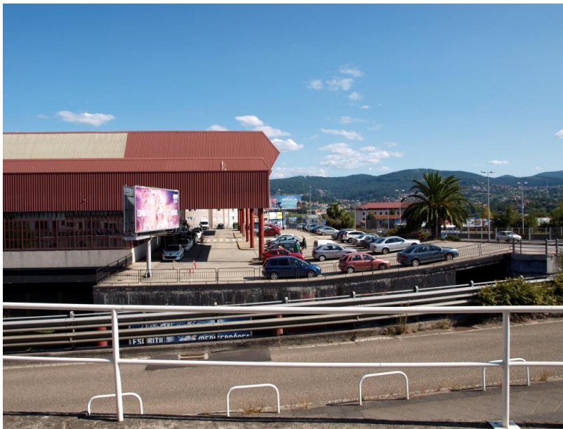
33. Vista lateral del parking de la estación.
