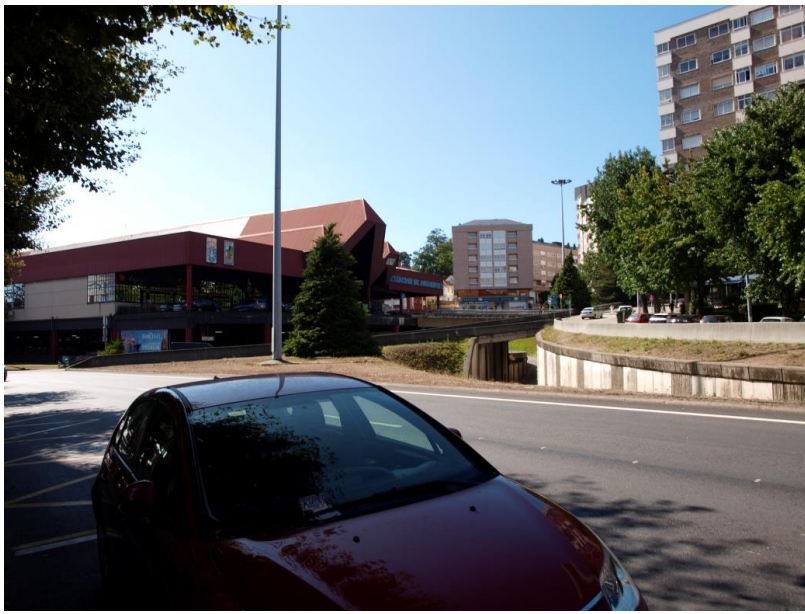
15. Fachada posterior de la estación desde Avd. Martínez Garrido.
