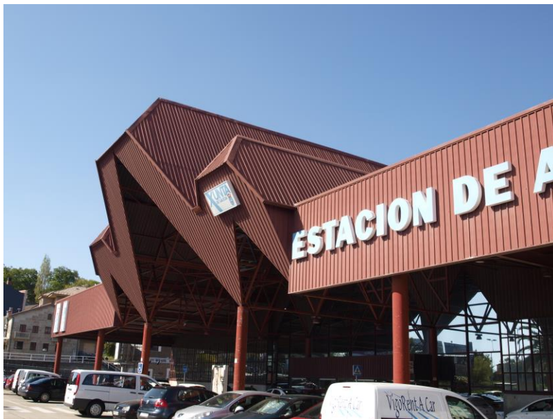
65. vista de la cubierta desde la zona de estacionamiento.
