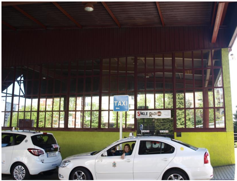
55. Fachada posterior bajo la cubierta.
