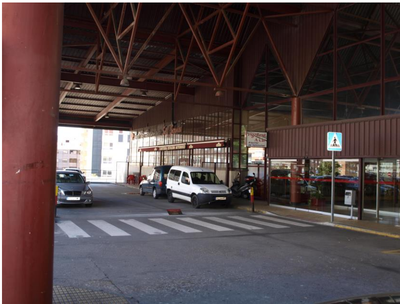
58. Acceso peatonal a la estación.
