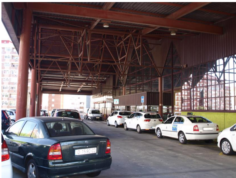
57. Estructura metálica vista de la cubierta de la estación.
