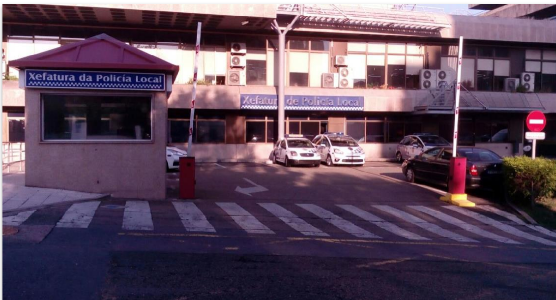
Fig.16. Fachada principal de la actual jefatura de policía local de Vigo.
