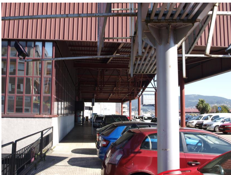
66. Vista lateral de la fachada principal y estructura de cubierta.
