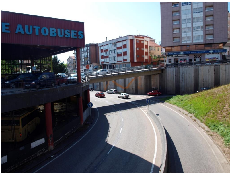
23. Puente que conecta la Avd Gregorio Espino con la estación.
