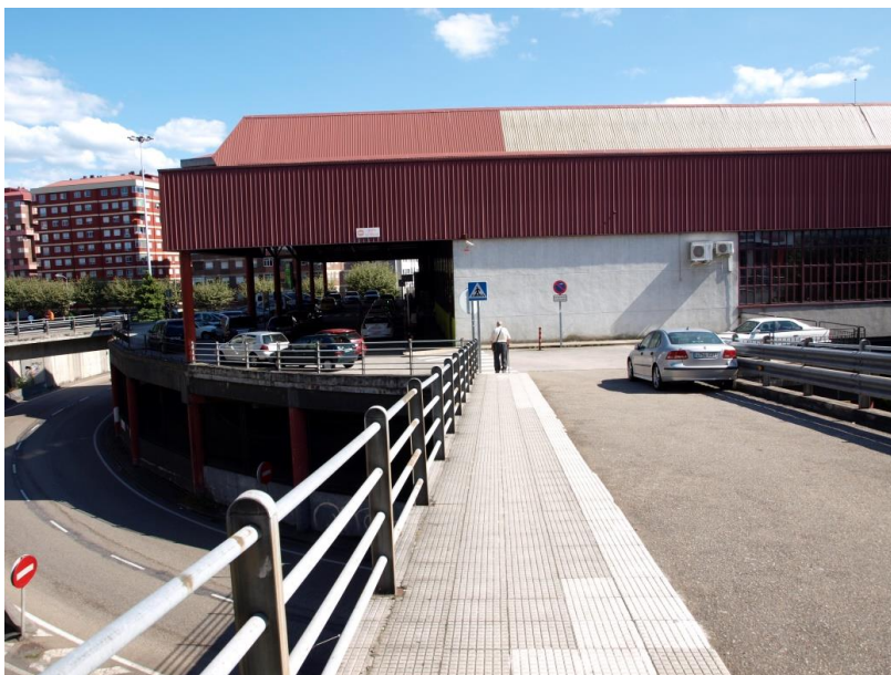
28.Puente que conecta la estación con la Avd. Gregorio Espino.
