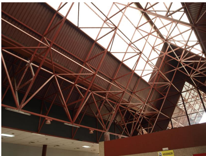
89. Estructura metálica que conforma la cubierta de la estación.
