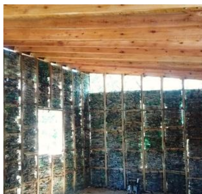
Figura 77 - interior da obra da casa del Té (De Masi, 2020)
