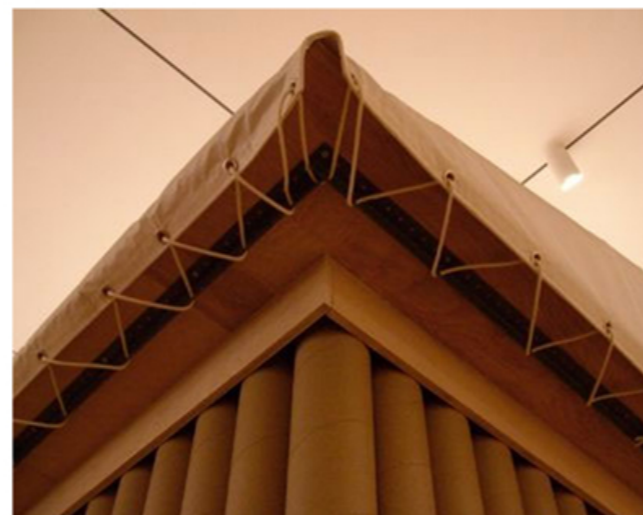
Figura 115 - "Bainha" de tela em estrutura metálica (Archdaily, 2019)
