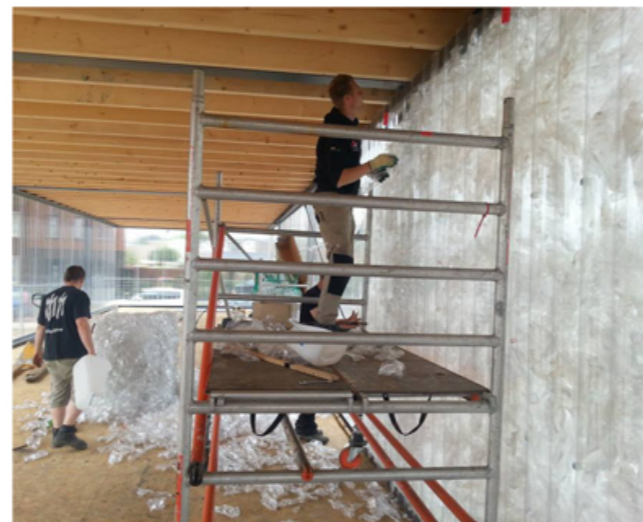
Figura 109 - Processo de encaixe das garrafas PET nos painéis de PC (Loos,FM, 2019)
