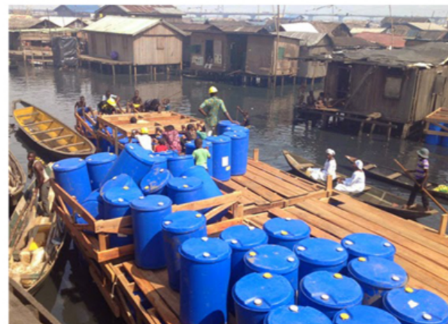
Figura 97 - Processo de encaixe dos bidons (Nlé, 2012)
