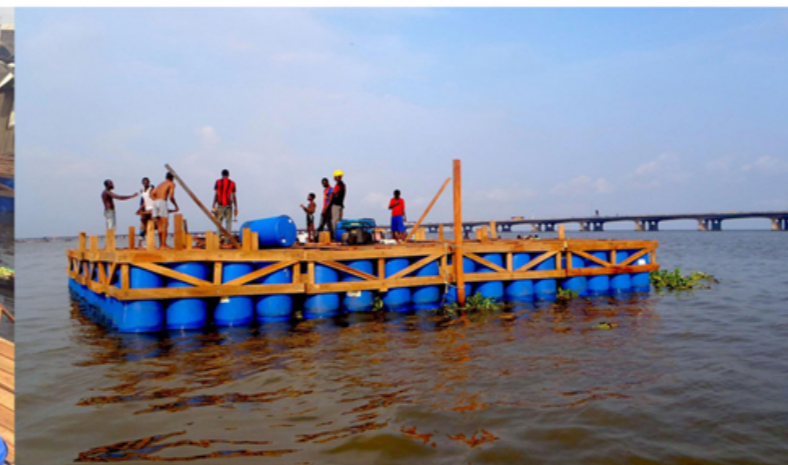
Figura 98 - Início da construção superior em madeira (Nlé, 2012)
