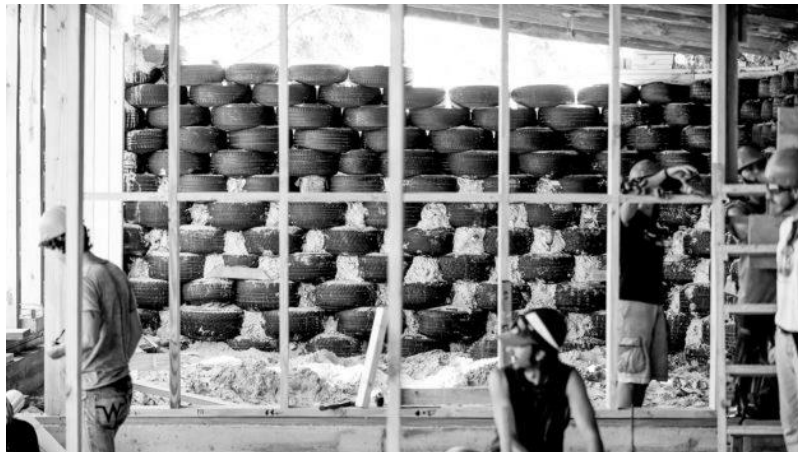
Figura 65 - Construção de Earthship desenhada por Michael Reynolds (My San Antonio, 2018)
