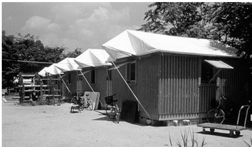
Figura 64 - Casas temporárias em cartão, bambu, caixas de plástico e telas (Shigeru Ban, 1995)
