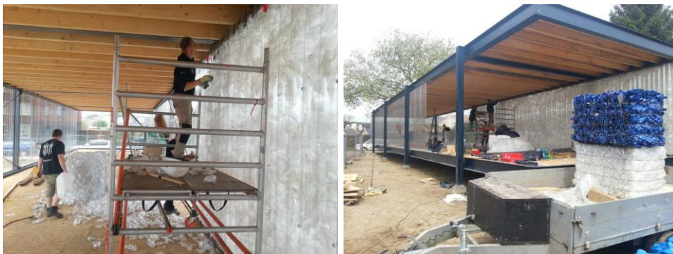
Figura 9 – enchimento das paredes de policarbonato com garrafas de plástico PET prensadas (Créditos: Loos.Fm (2019))
