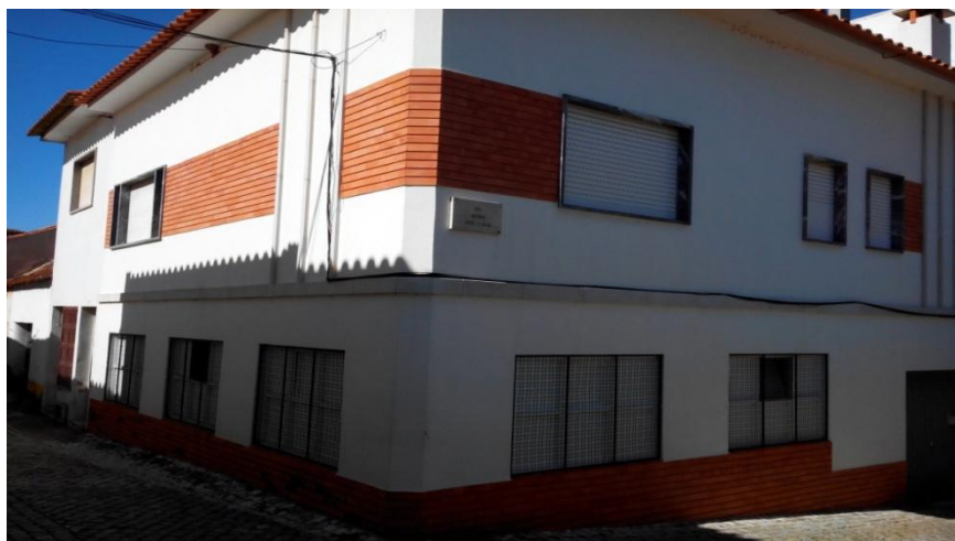
Figura 53 – Exemplo de edifícios de classificação Sem Interesse
