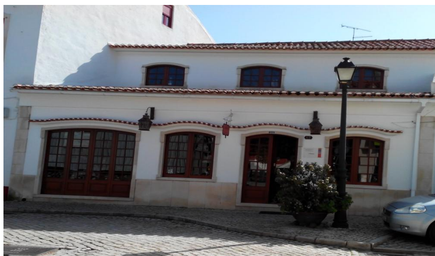
Figura 52 – Exemplo de edifícios de classificação Acompanhamento
