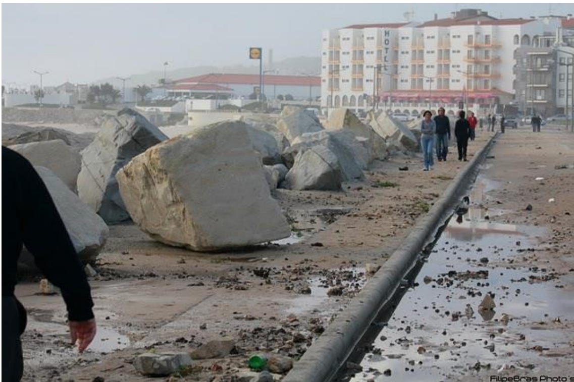
Figura 69: Imagem do efeito de galgamentos a norte do Forte de Buarcos. Fonte: Fotografia de Filipe Brás, tirada a 9 de outubro de 2010
