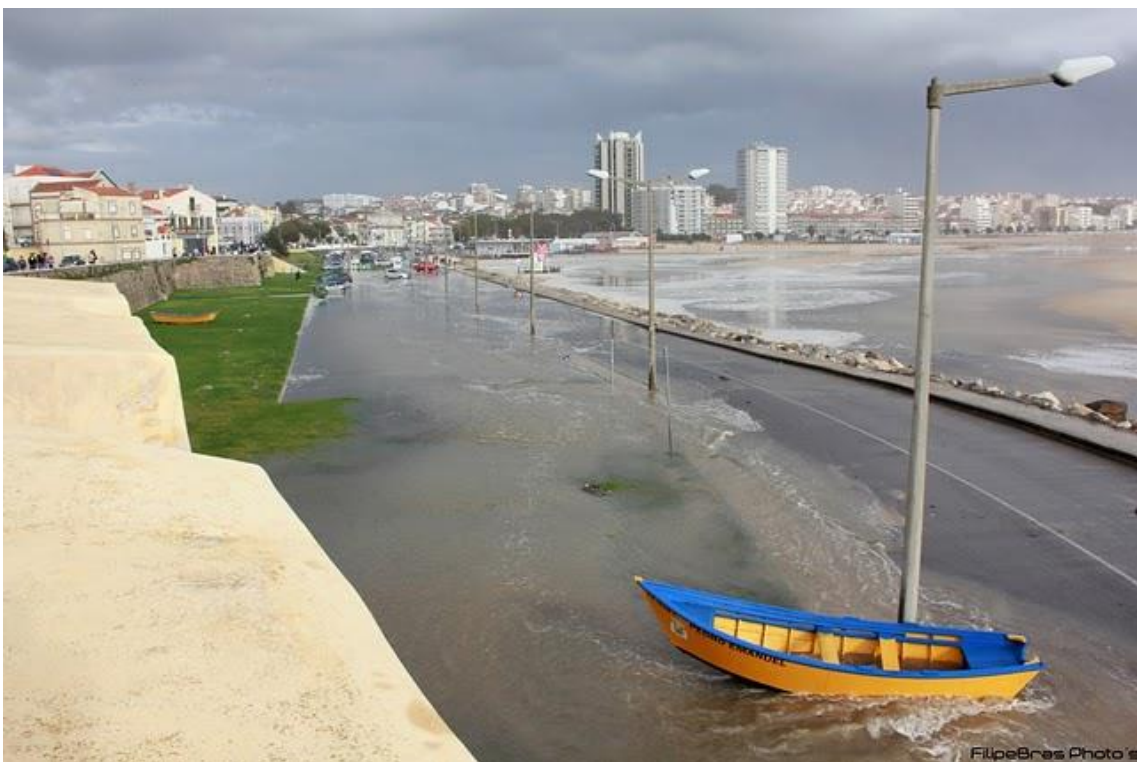
Figura 65: Imagem do efeito de galgamentos a norte do Forte de Buarcos. Fonte: Fotografia de Filipe Brás, tirada a 9 de outubro de 2010
