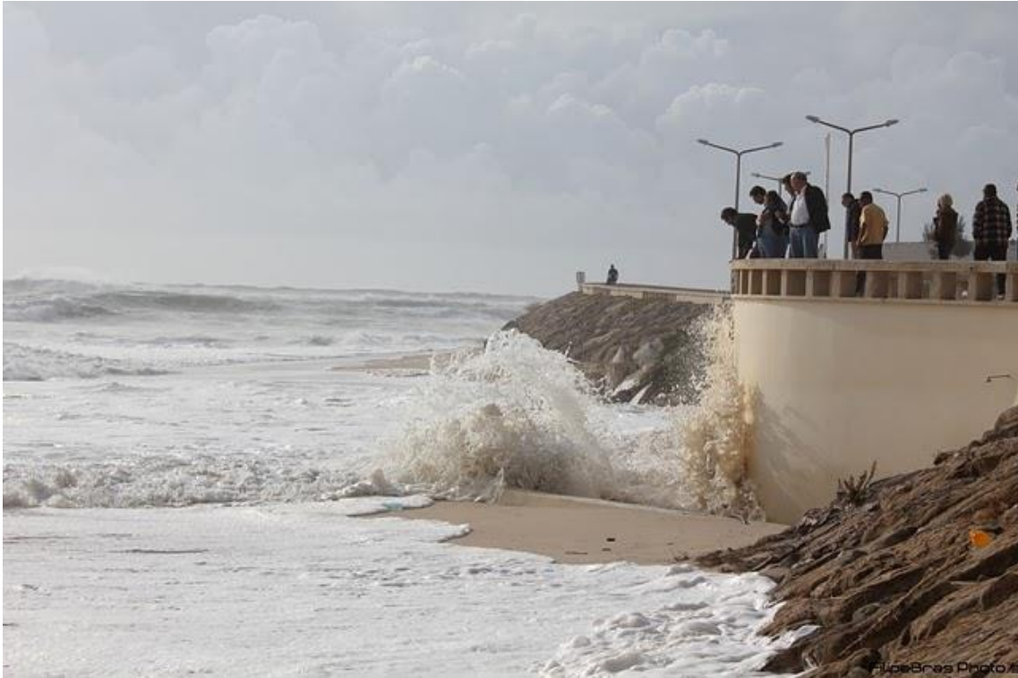
Figura 72: Imagem do efeito de galgamentos a norte do Forte de Buarcos. Fonte: Fotografia de Filipe Brás, tirada a 9 de outubro de 2010
