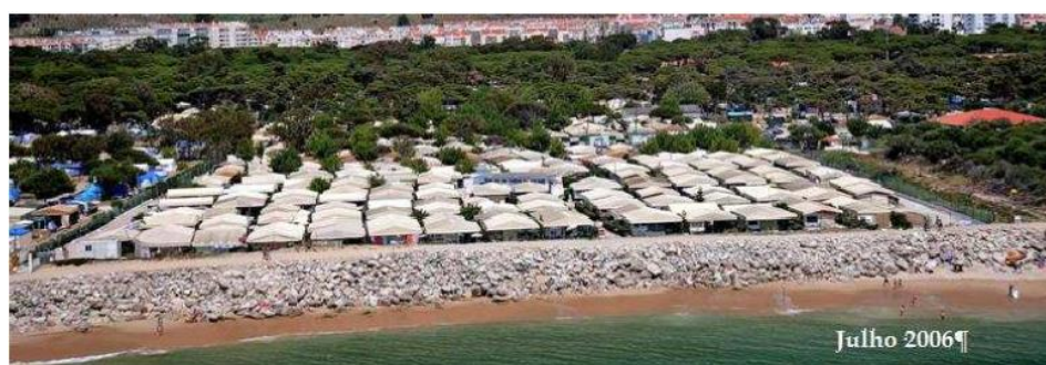
Figura 32: Situação na zona do parque de campismo, antes e após as intervenções (reperfilamento da obra aderente e alimentação artificial com areia). (FERNANDO VELOSO-GOMES 2009)
