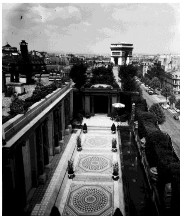
Fig. 3 — Achilles Duchêne. Terraço da Av. d'Iena residência do Sr. C. Gulbenkian em Paris
