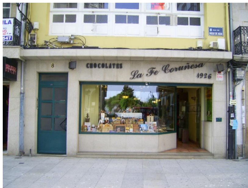
Estado actual de la antigua fábrica de Chocolate "La Fe Coruñesa". FUENTE: Autoría Propia.
