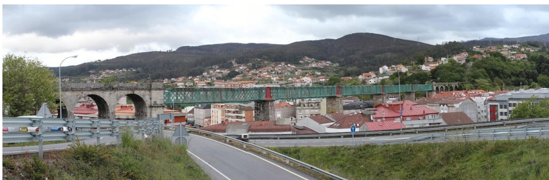
Fig. 35: Viaductos de ferrocarril en Redondela.
