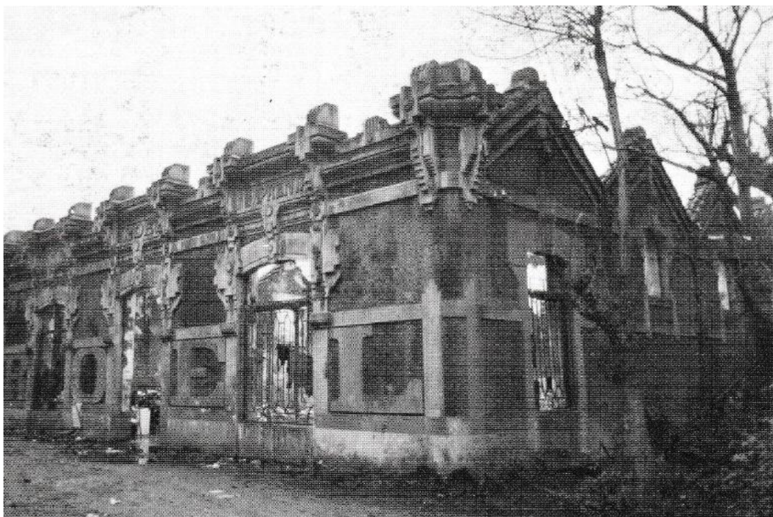
Fig. 150: Restos de la Imprenta Roel antes de su demolición (FUENTE: Casabella & Martínez, 1989, p. 62).
