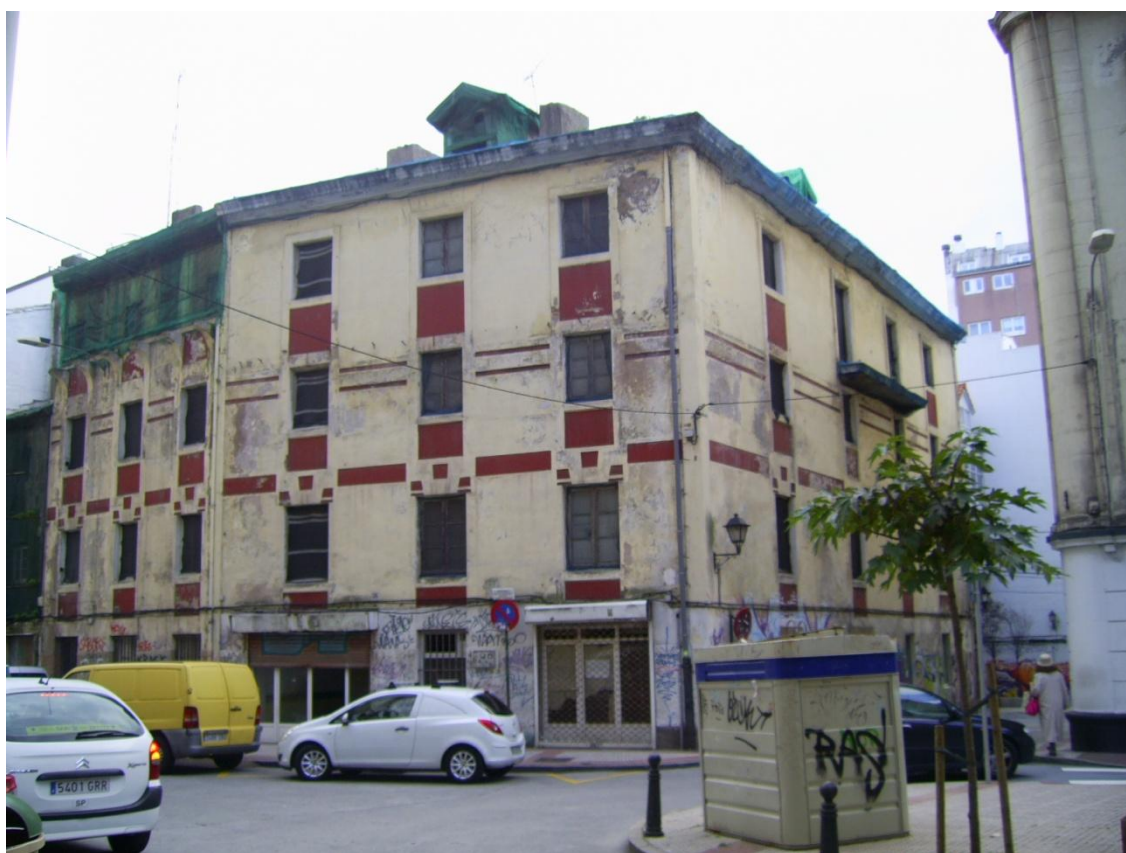
Fig. 185: Aspecto actual de la antigua fábrica de losetas.
