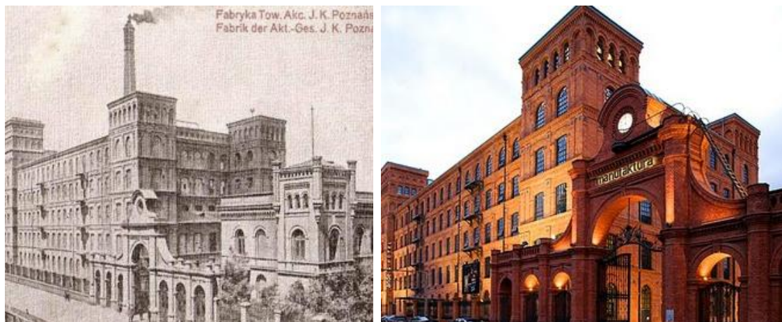
Fig. 21-22: Antigua Fábrica textil convertida en un Centro Comercial, Polonia.
