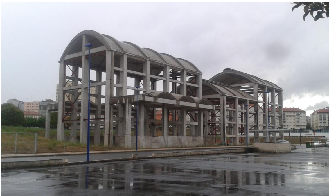
Fig. 45: Estado actual de la fábrica de la Cros, después de la consolidación de la estructura.
