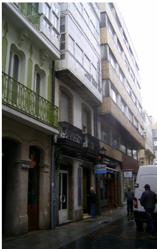
Estado Actual de la antigua fábrica de jabón.
