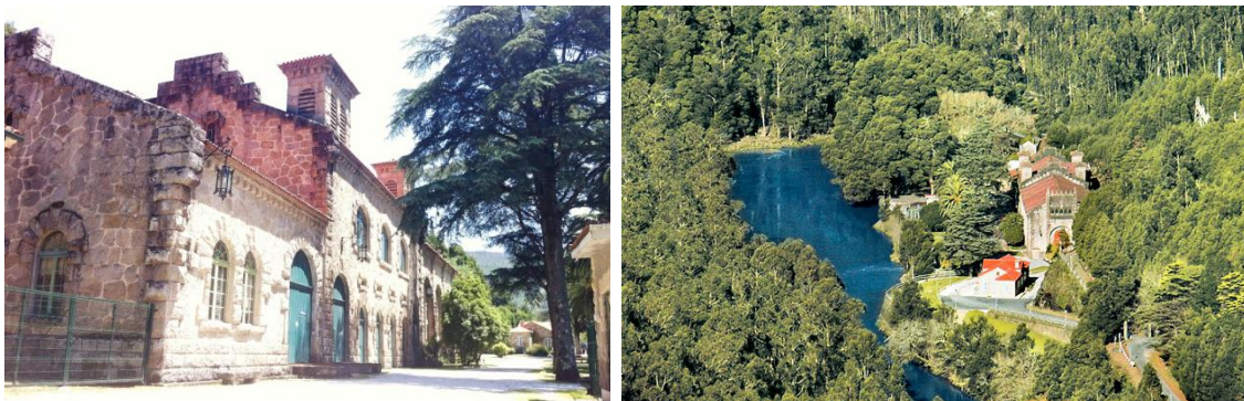
Fig. 33-34: Centrales hidroeléctricas del río Tambre.
