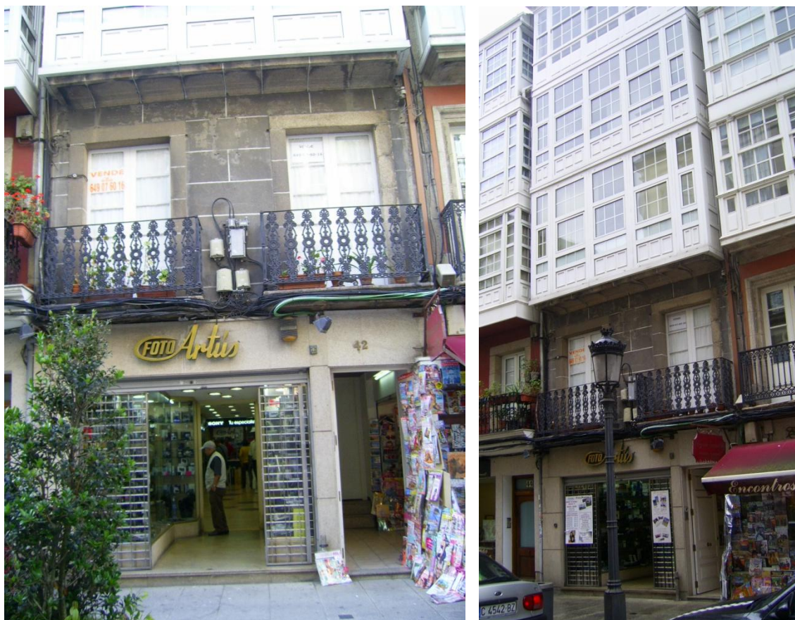
Fig. 215-216: Estado actual de la antigua fábrica de hielo del Sr. Juan Sanz, en la calle Riego de Agua, número 42.
