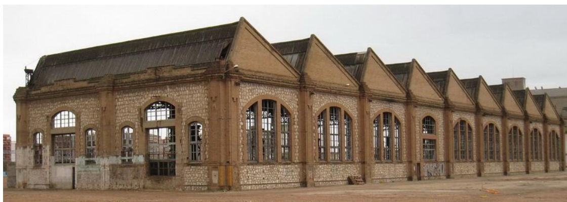
Fig. 11: Fábrica tipo shed: Naves de Macosa de Valencia.
