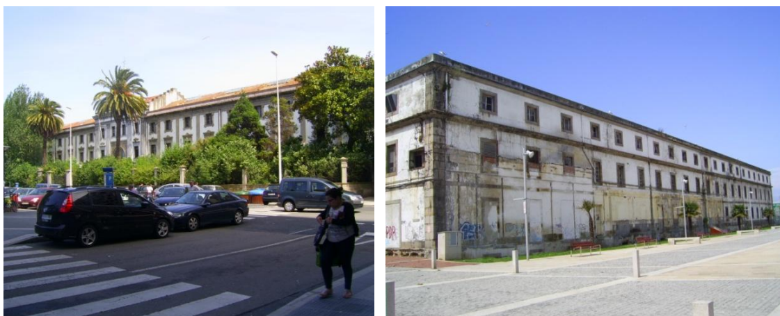
Fig. 197-198: Estado actual de la Fábrica de Tabacos.
