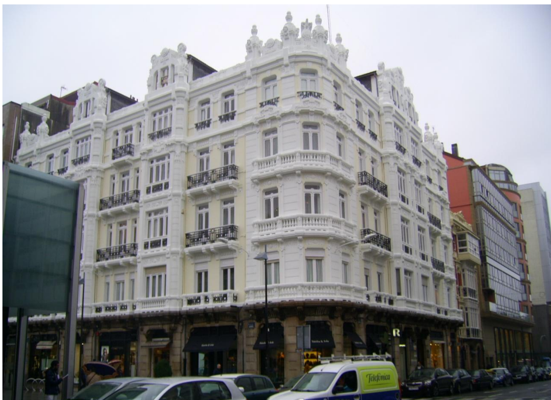
Fig. 57: Edificio modernista: Arq. Julio Galán Carbajal, 1910, Calle Compostela.
