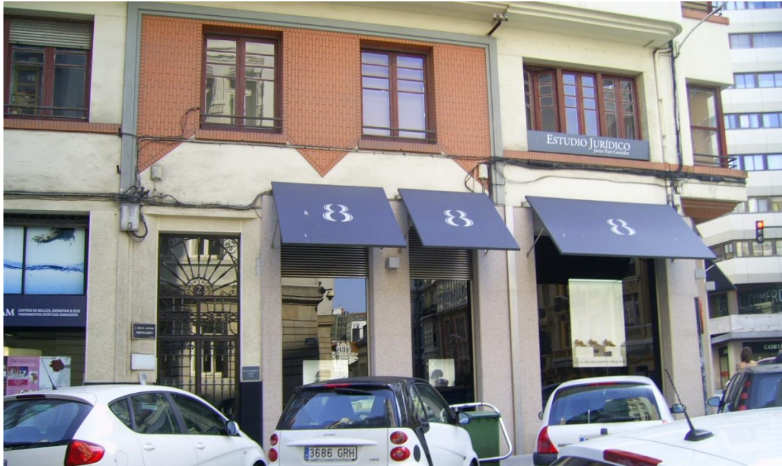
Fig. 266: Vista de la configuración de los vanos de la fachada.
