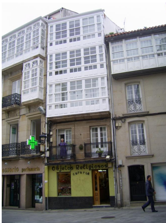
Fig. 200: Aspecto actual de la fábrica de velas de cera.
