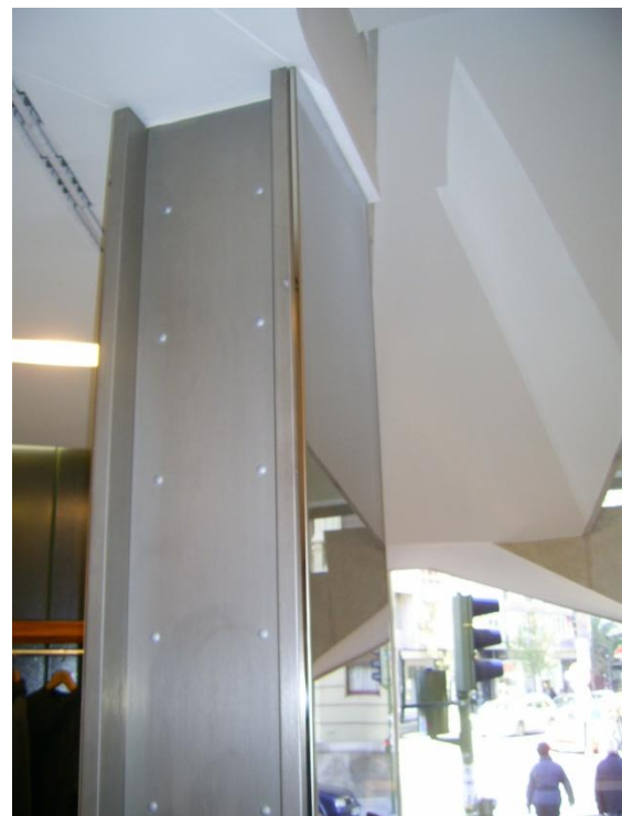
Fig. 268: Vista de los pilares del local contiguo.
