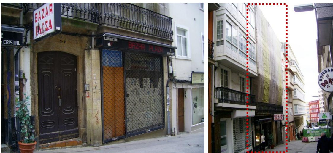
Fig. 173-174: Aspecto actual de la antigua fábrica de cajas de cartón.
