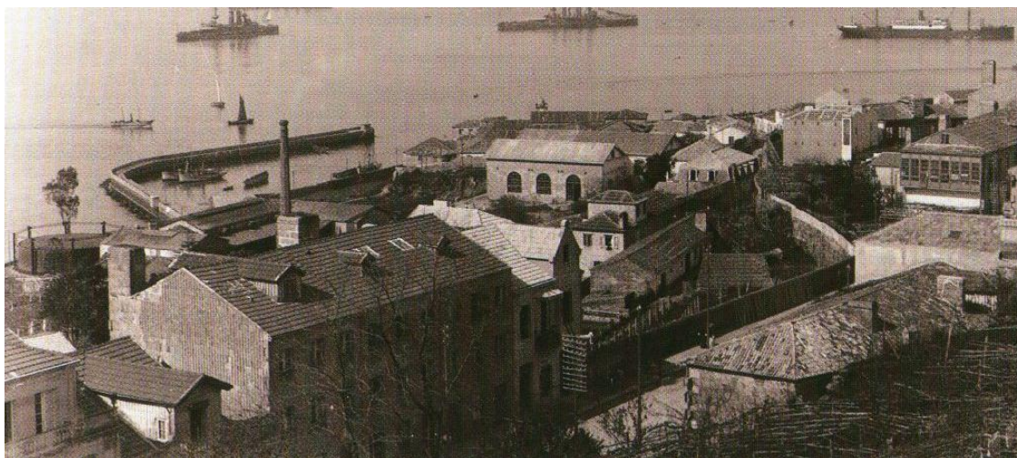
Fig. 38: Fábrica de gas de Vigo, destruida.
