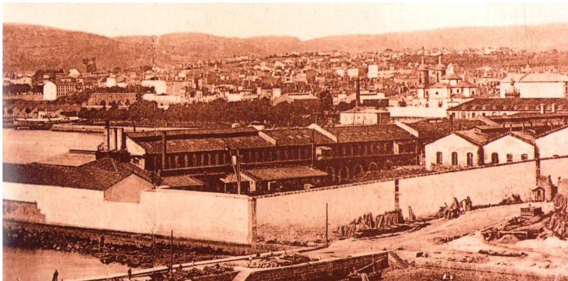
Fig. 39: Fábrica de gas de Ferrol, destruida.
