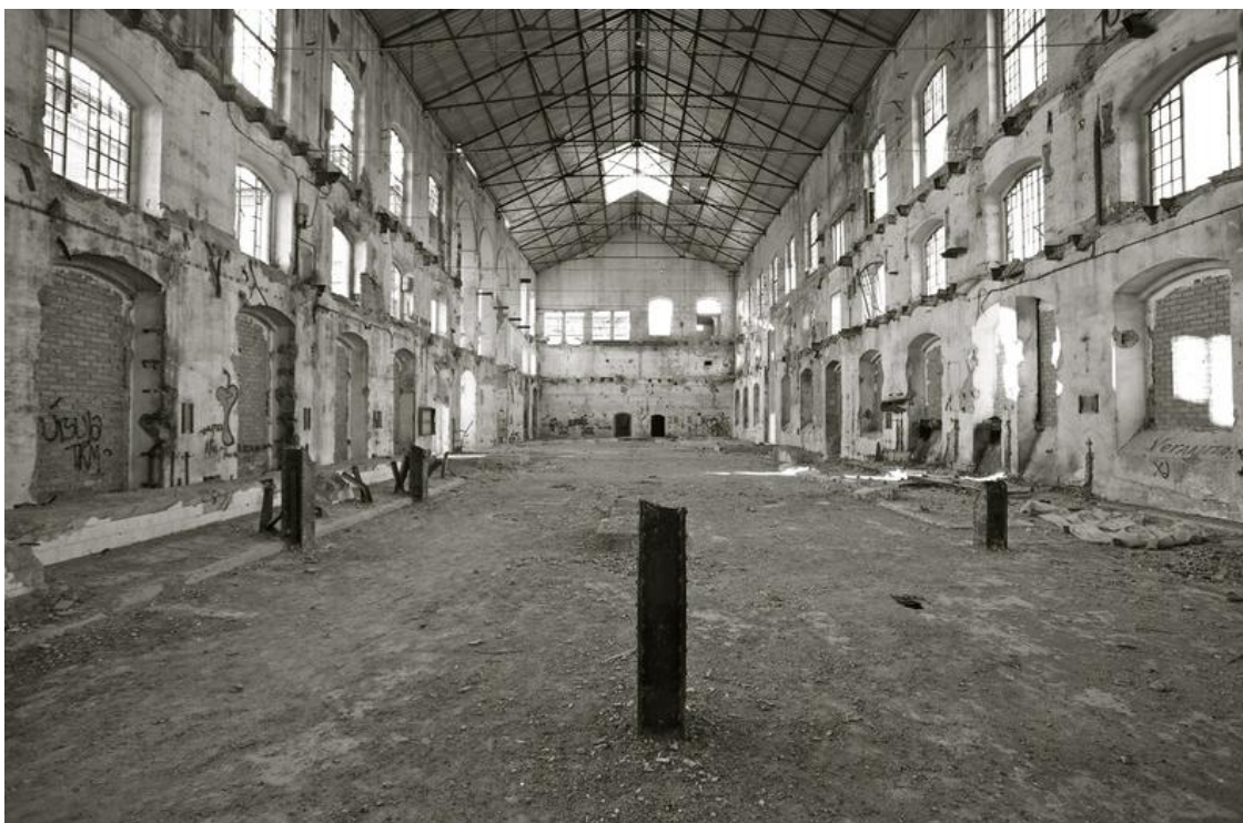
Fig. 18: Fábrica Azucarera de San Torcuato S.A., Andalucía, 1900.
