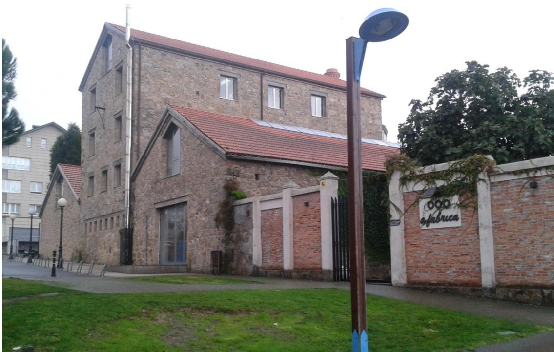
Fig. 49: Estado actual de la Fábrica de Perillo.
