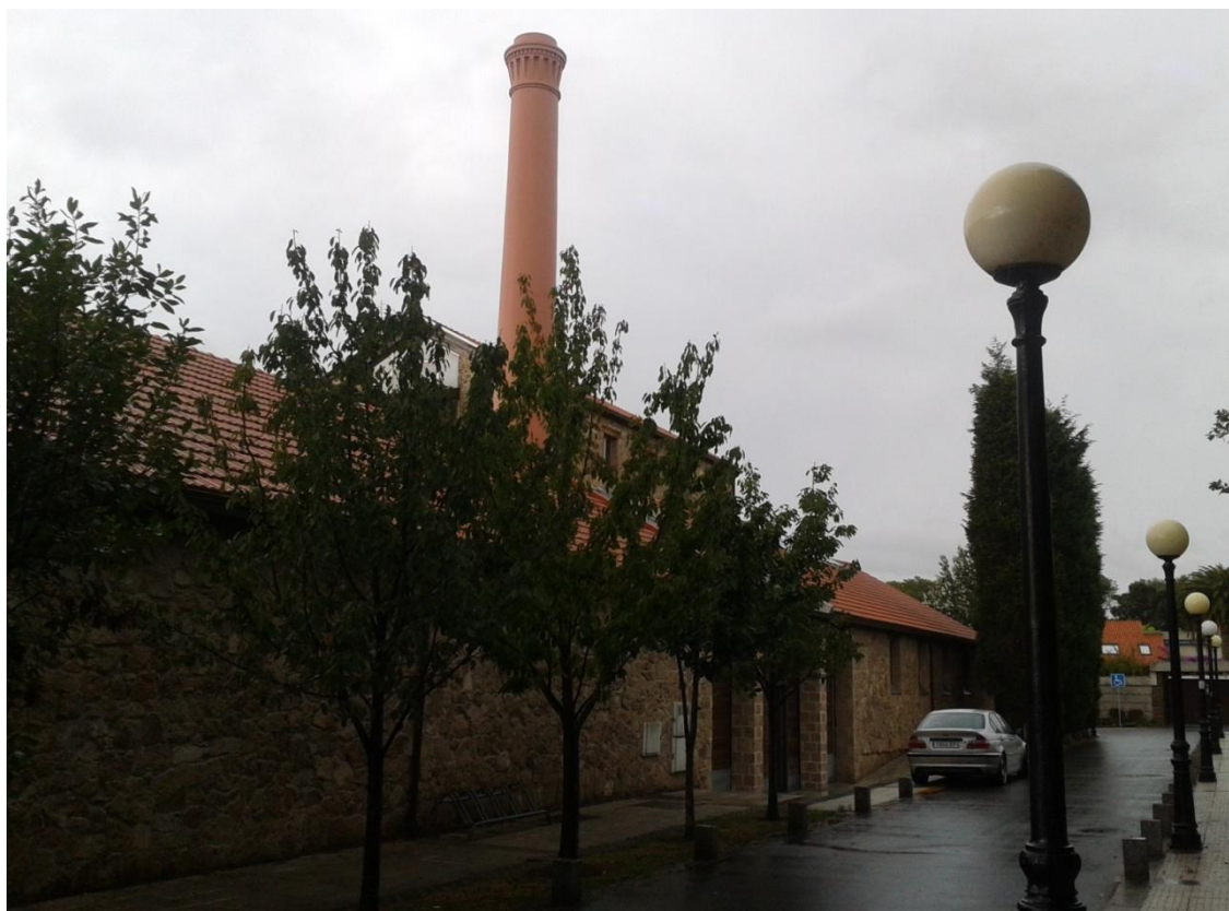
Fig. 50: Estado actual de la Fábrica de Perillo, entrada principal al centro.
