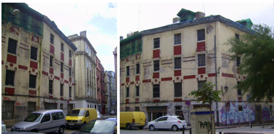
Fig. 186-187: Aspecto actual de la antigua fábrica de losetas.
