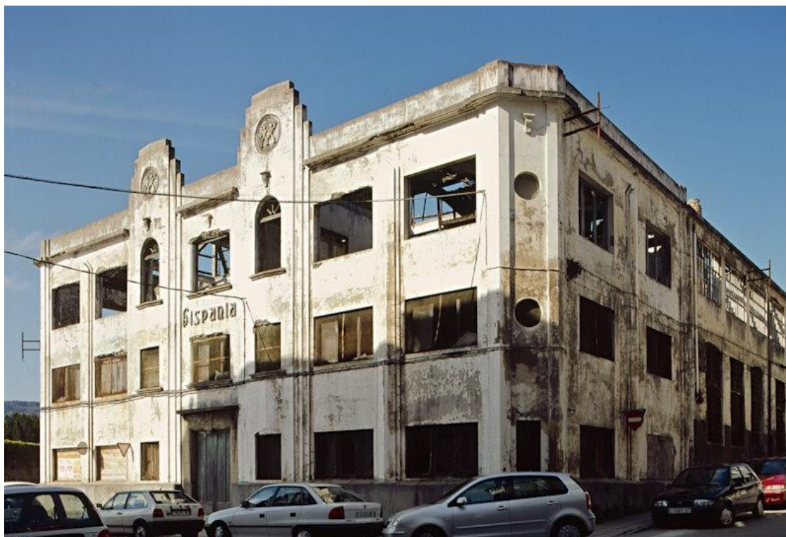
Fig. 41: Estado de la fábrica de lápices de Ferrol antes de comenzar su demolición.
