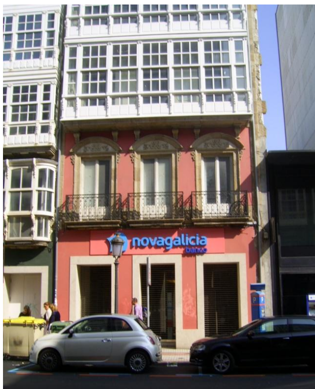
Estado actual de la antigua fábrica de chocolate del Sr. Conchado. FUENTE: Autoría Propia.
