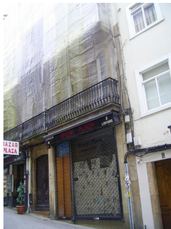
Fig. 172: Aspecto actual de la antigua fábrica de cajas de cartón.
