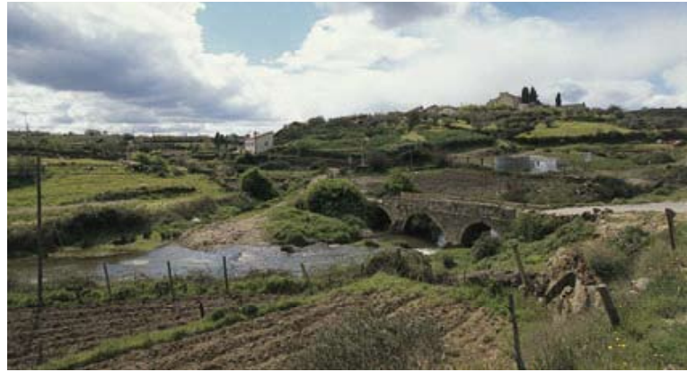
Fig. 30 – Ponte da Vermiosa (Vermiosa, Figueira de Castelo Rodrigo)
