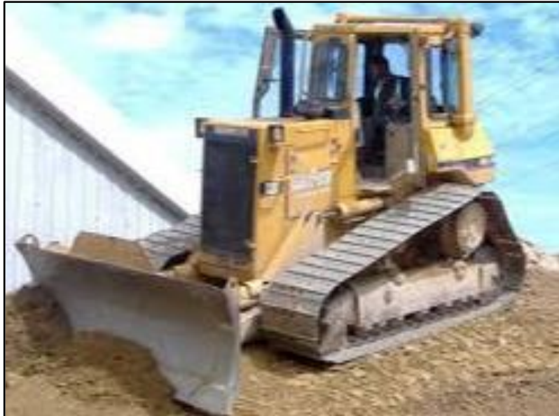
Figura 18 – Movimento Bulldozer – Fonte: Google, 2025.
