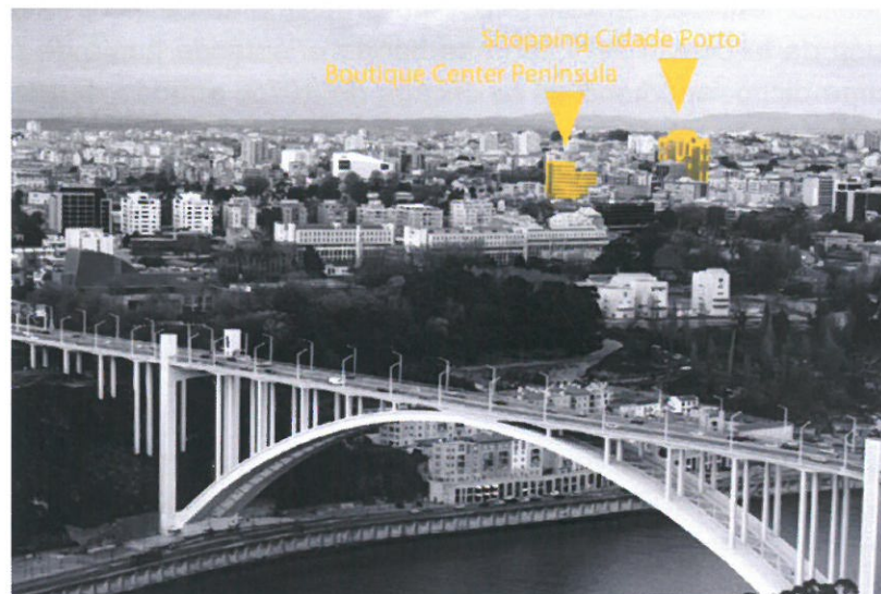
Ilustración 25 - Vista aérea Porto 2005.
