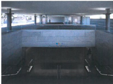
Ilustración 34 - Entrada metro CdM
