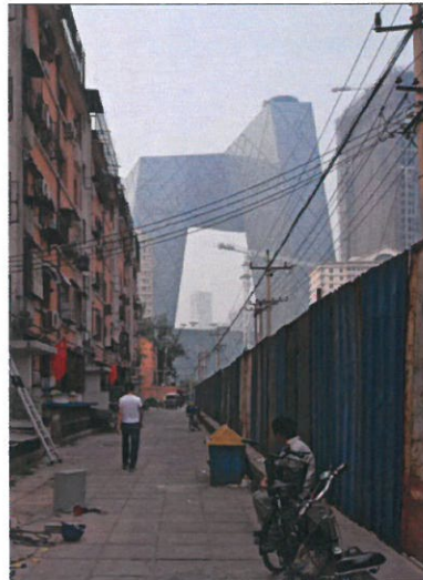
Ilustración 54 - Torre CCTV en Shanghai
