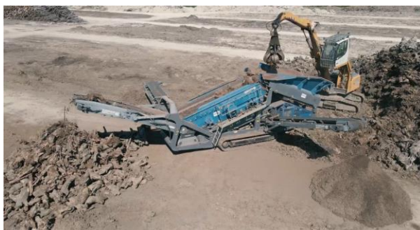
Figura 30 – Crivo Kleemann em operação de crivagem de cepos (elaboração própria).
