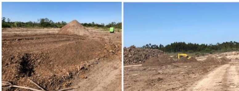
Figura 33 – Resíduos inertes provenientes da crivagem de cepos (elaboração própria).
