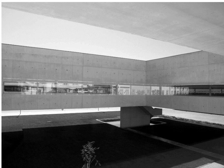
Figura 42 - Biblioteca Municipal – Viana do Castelo
