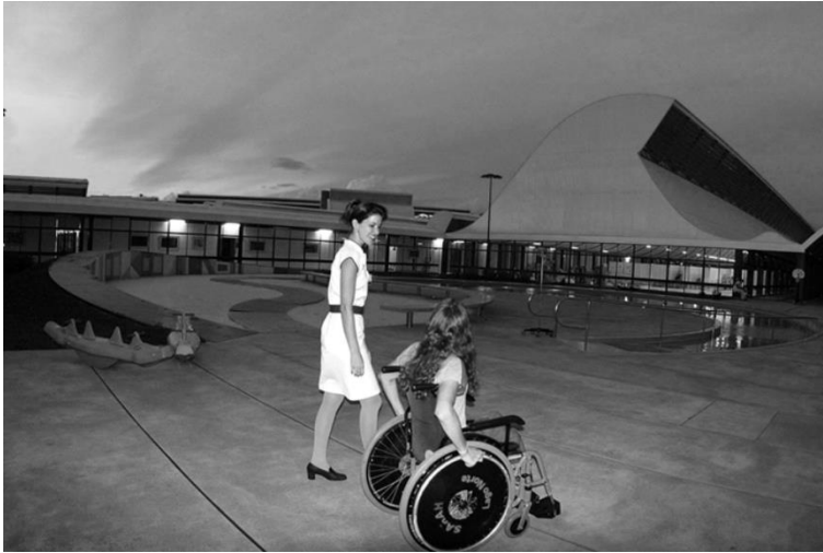
Figura 38 - Hospital Rede Sara Lago Norte
