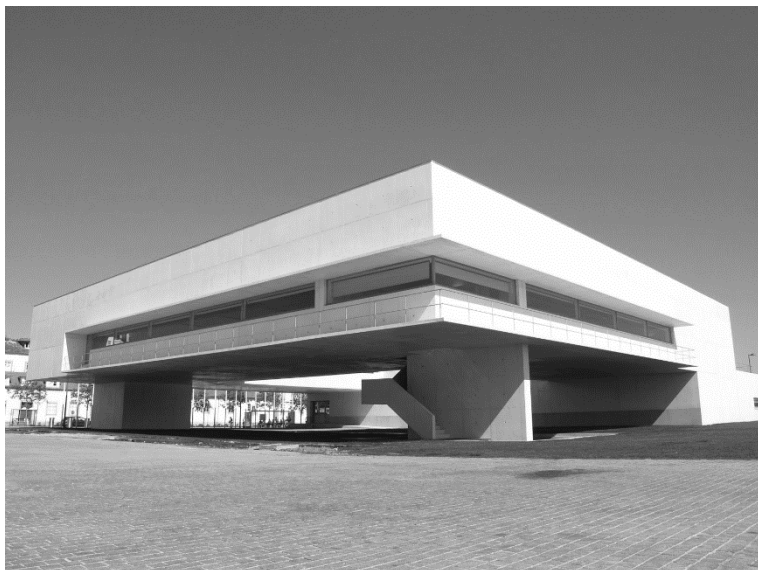
Figura 41 – Biblioteca Municipal – Viana do Castelo
