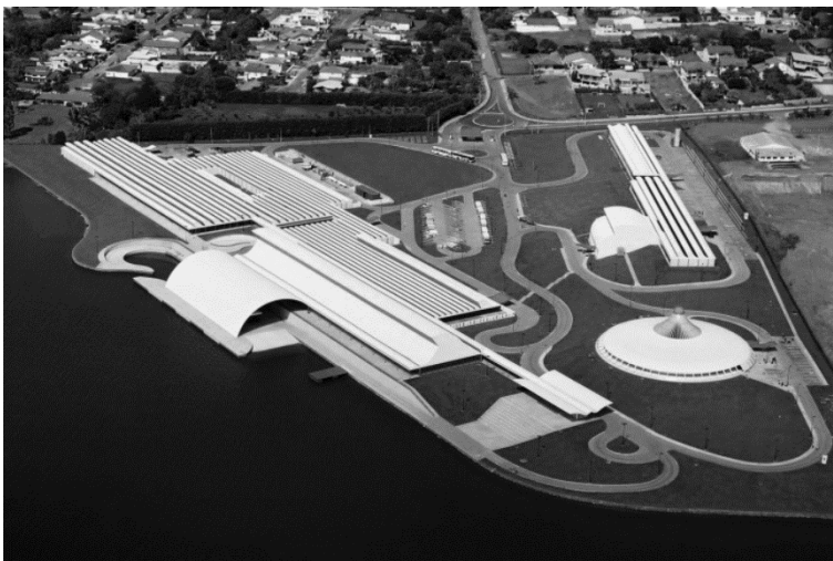
Figura 40 - Hospital Rede Sara Lago Norte
