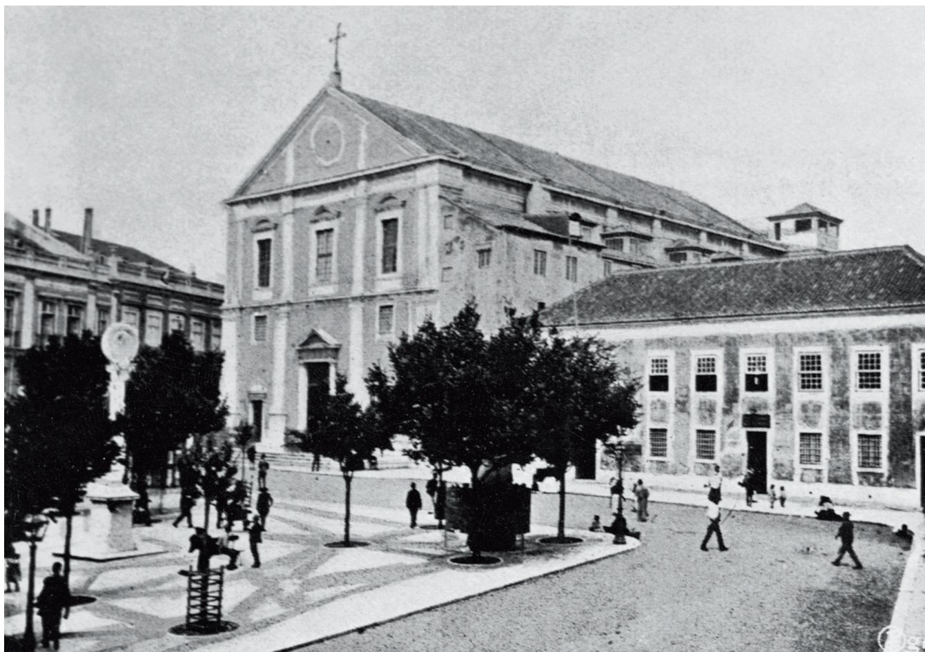
Fachada principal da Casa Professa no século XIX
