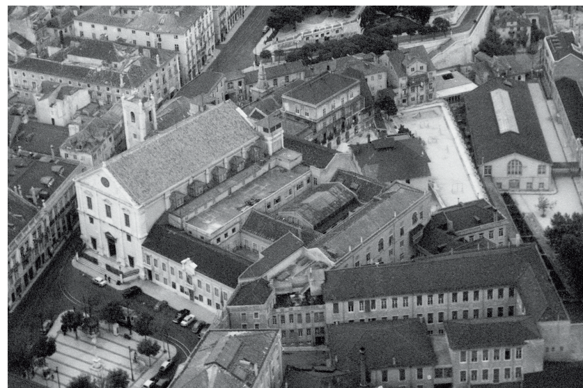
Coberturas revelando a estrutura dos primitivos claustros da Casa Professa
