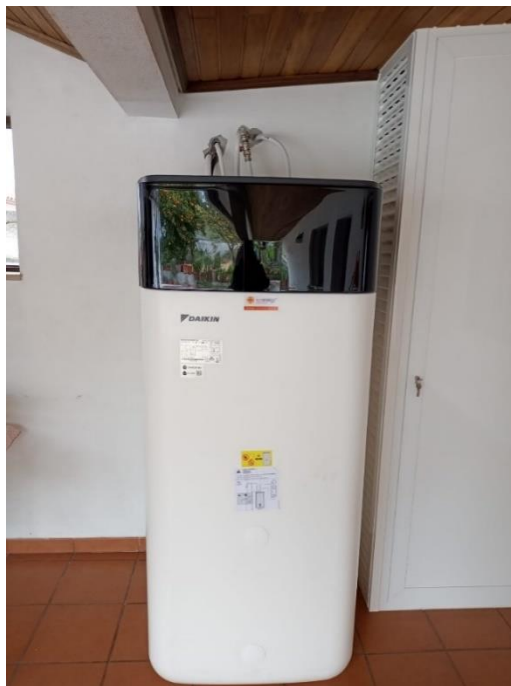
Figura 4: Unidade Interior de uma Bomba de Calor AQS Split.
