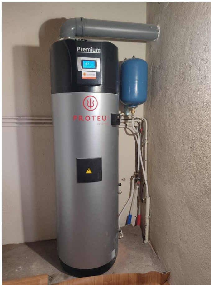
Figura 35: Aspeto final da instalação.
