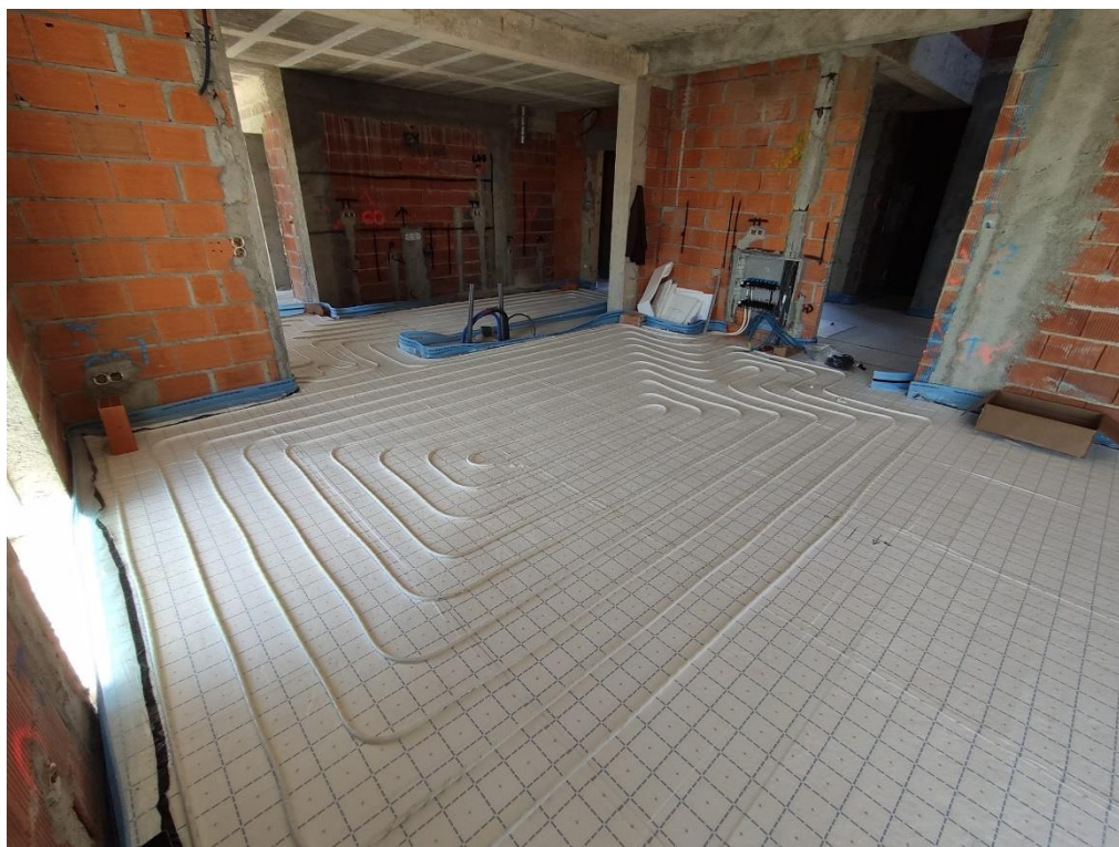
Figura 41: Instalação da placa e do tubo de circulação.
