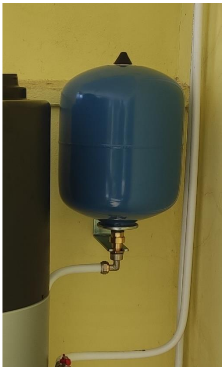
Figura 32: Vaso de Expansão 18L.
