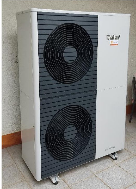
Figura 25: Colocação e instalação da Bomba de Calor.
