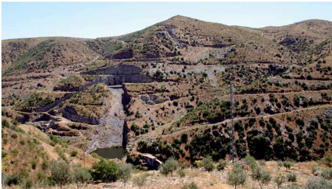
Fig. 5. As cicatrizes da abandonada barragem do Côa, na margem direita. À direita o vale da Canada do Amendoal, e à esquerda o vale do Meijapão.
