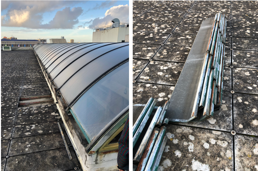
Figura 15 – Obra a dia 8 de Março (remoção dos rufos metálicos)
