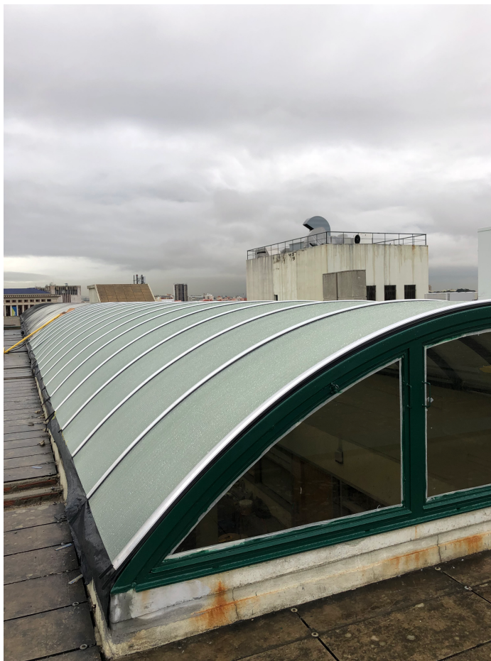
Figura 17 – Vista do topo da CI3 com painéis novos
