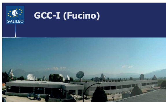
FIGURA 19 Estação de Controlo, Fucino.
