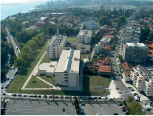
FIGURA 43 Estação GNSS da FCUP.
