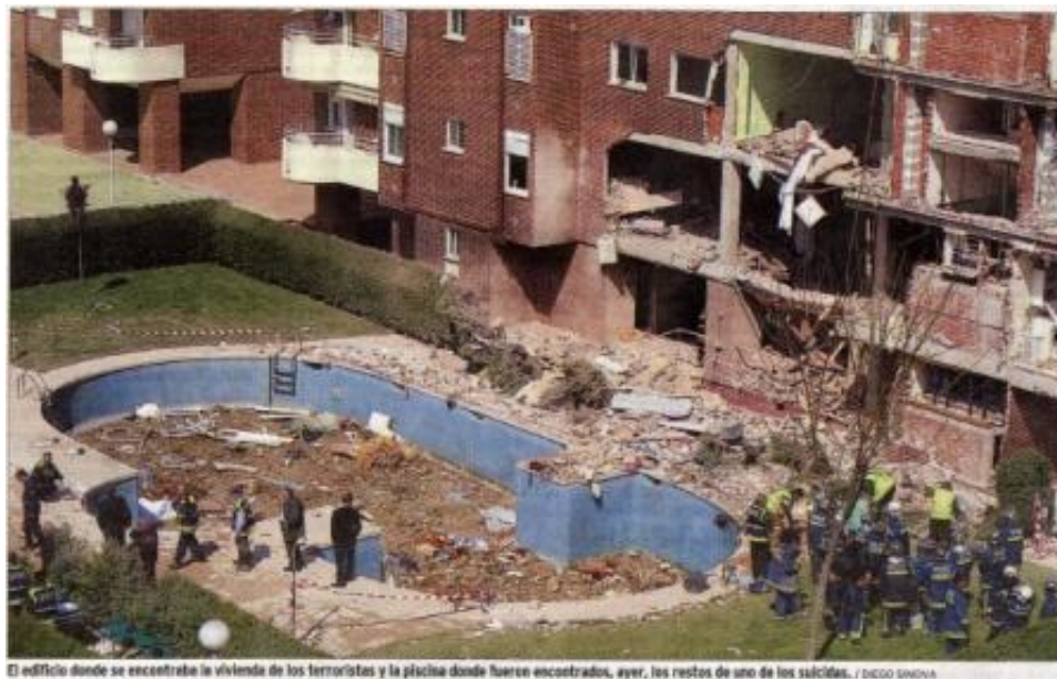
Fig. 2 - Vista das traseiras do prédio onde decorreu o ITP, após a detonação
