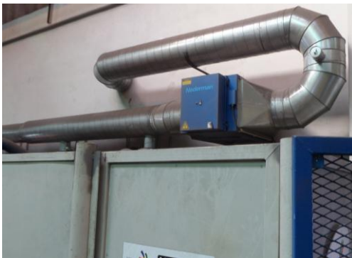
Figura 10: Sistema de extracção
