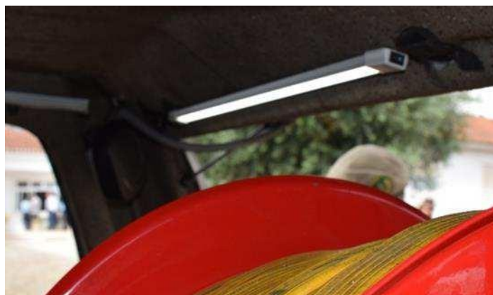
Figura 39 - Foco de luz de trabalho dentro da caixa de carga do VLCL.
