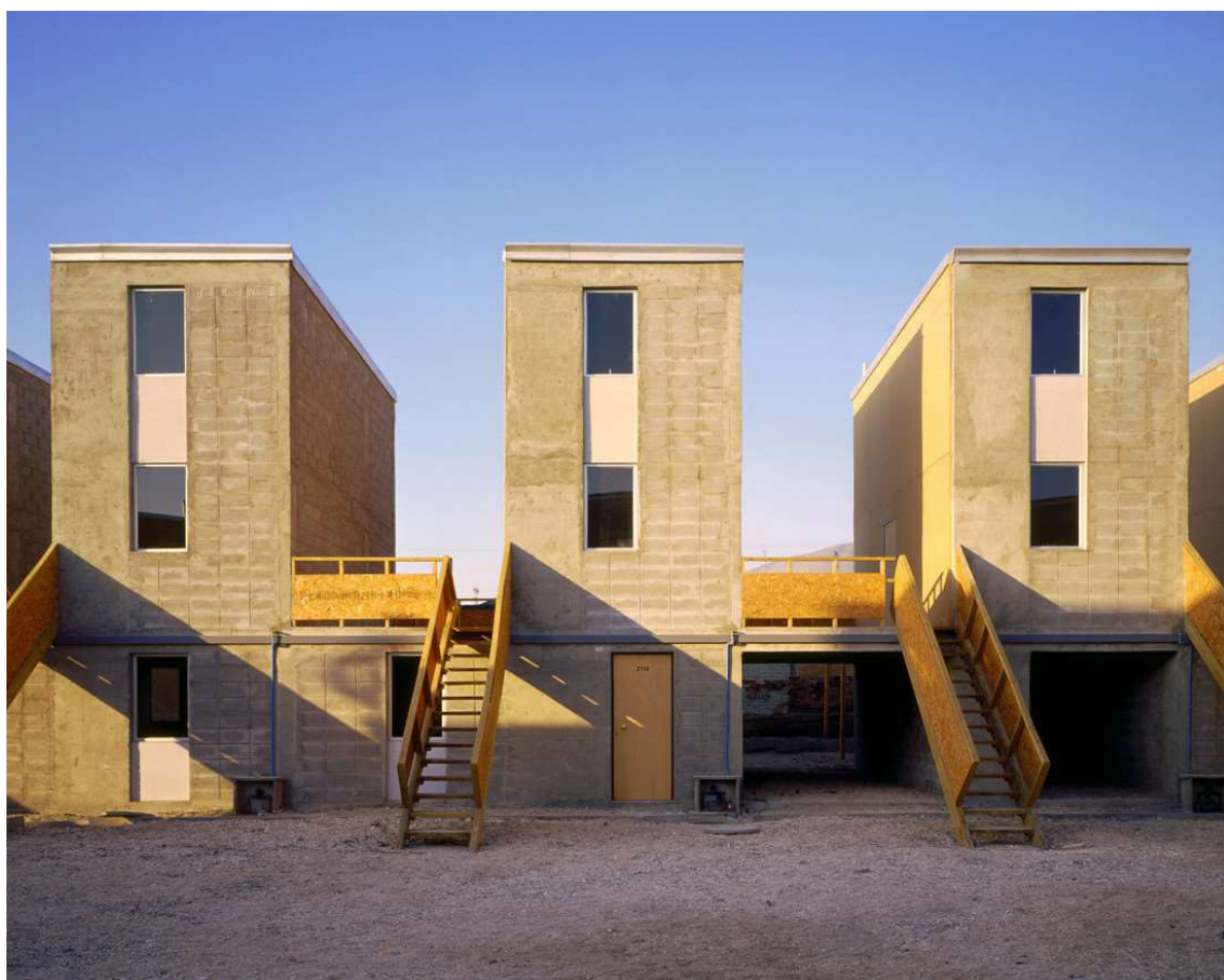
Fig. 28 - Fachada frente rua (antes da ocupação), Bairro da Quinta Monroy, Iquique, Chile Fonte: @ Elemental, Cristobal Palma
