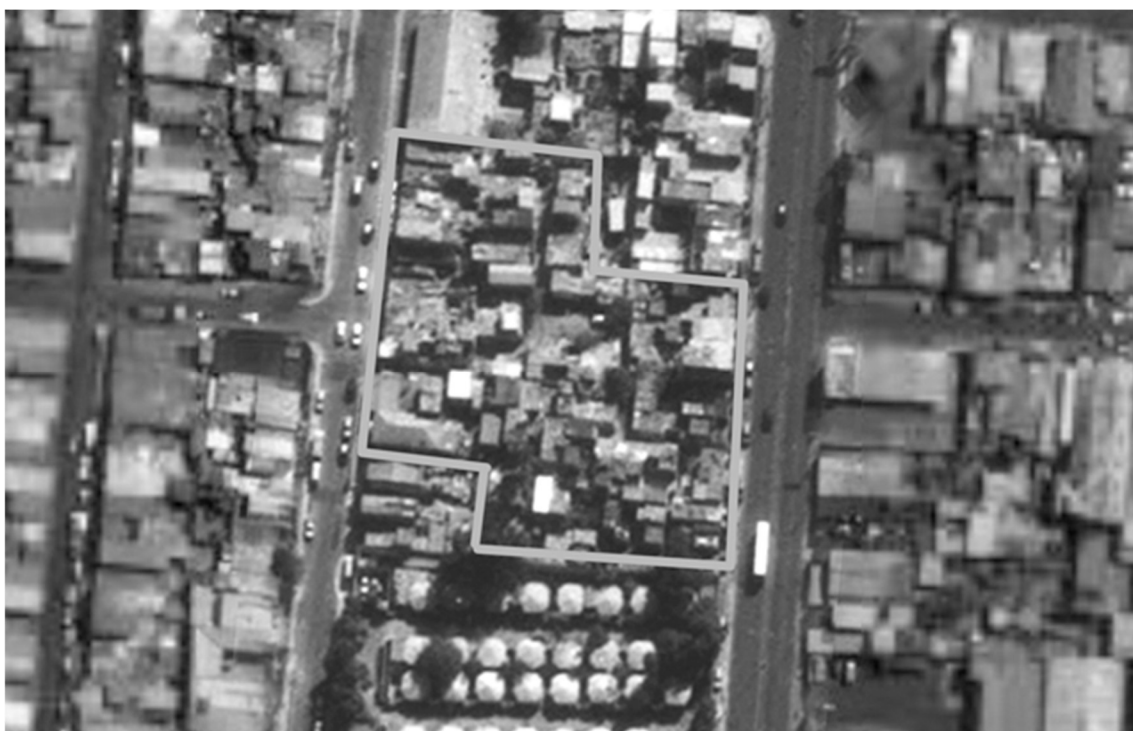
Fig. 19 - Fotografia aérea antes da intervenção, Bairro da Quinta Monroy, Iquique, Chile Fonte:
