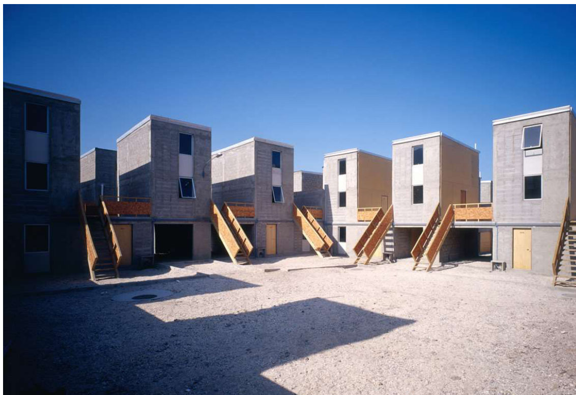
Fig. 27 - Interior do quarteirão (antes da ocupação), Bairro da Quinta Monroy, Iquique, Chile Fonte: @ Elemental, Cristóbal Palma
