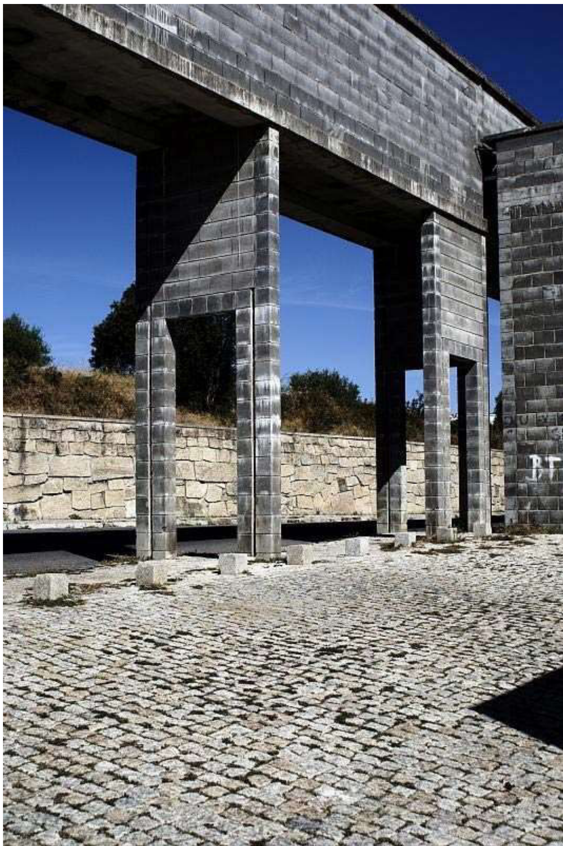
Fig. 9 - Conduto, Bairro da Quinta da Malagueira, Évora Fonte: http://socks-studio.com/img/blog/malagueira-evora-siza-08.jpg
