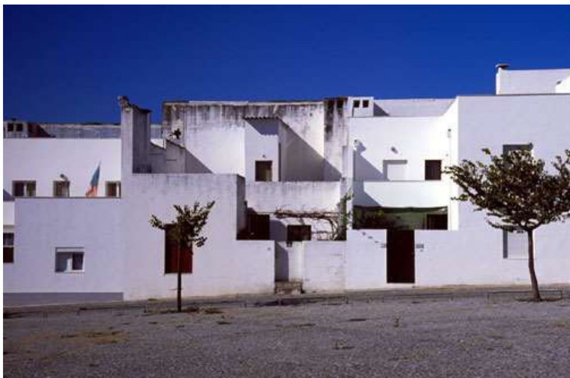
Fig. 16 - Fachada Casa Tipo A, Bairro da Quinta da Malagueira, Évora
