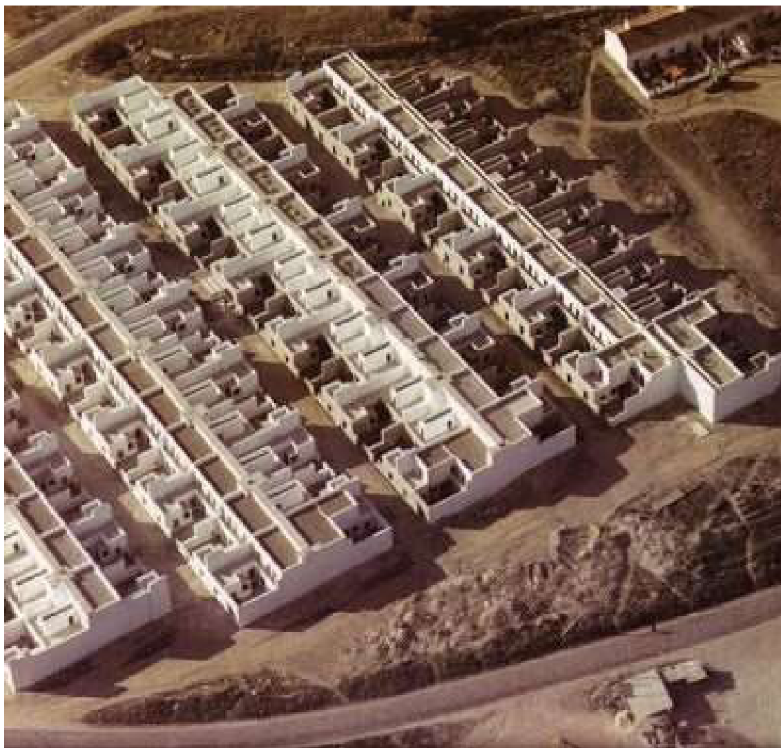
Fig. 4 - Fotografia aérea, Bairro da Quinta da Malagueira, Évora
