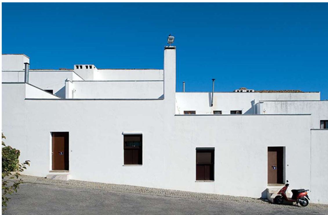
Fig. 15 - Fachada Casa Tipo A, Bairro da Quinta da Malagueira, Évora
