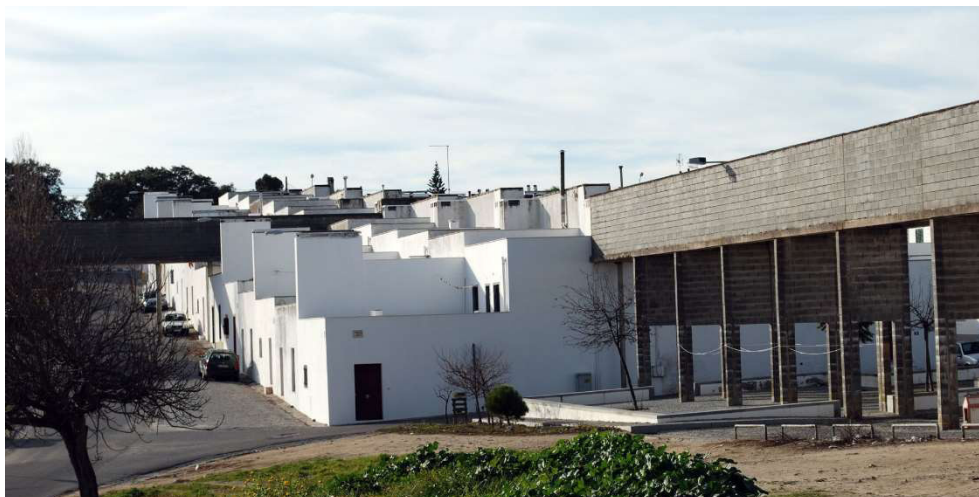
Fig. 6 - Conduta, Bairro da Quinta da Malagueira, Évora Fonte: http://www.herearchitecture.com/#
