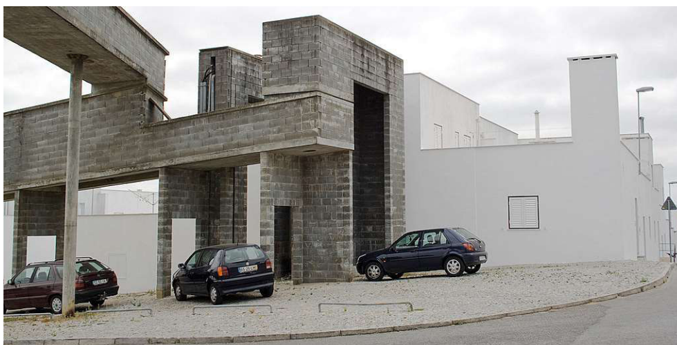
Fig. 7 - Conduta, Bairro da Quinta da Malagueira, Évora Fonte: © Javier Sánchez
