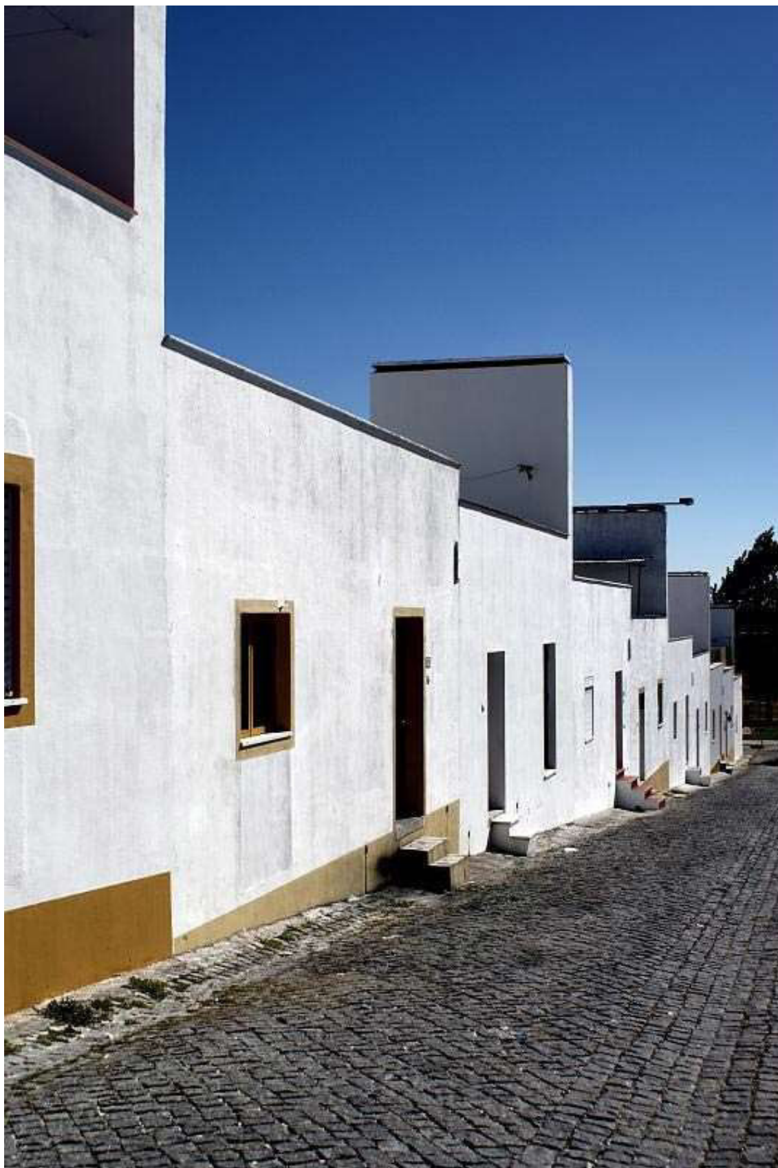
Fig. 18 - Fachada Casa Tipo A, Bairro da Quinta da Malagueira, Évora Fonte: © Vitoria Gasteiz, https://www.flickr.com/photos/ekain/albums/72157606939347532
