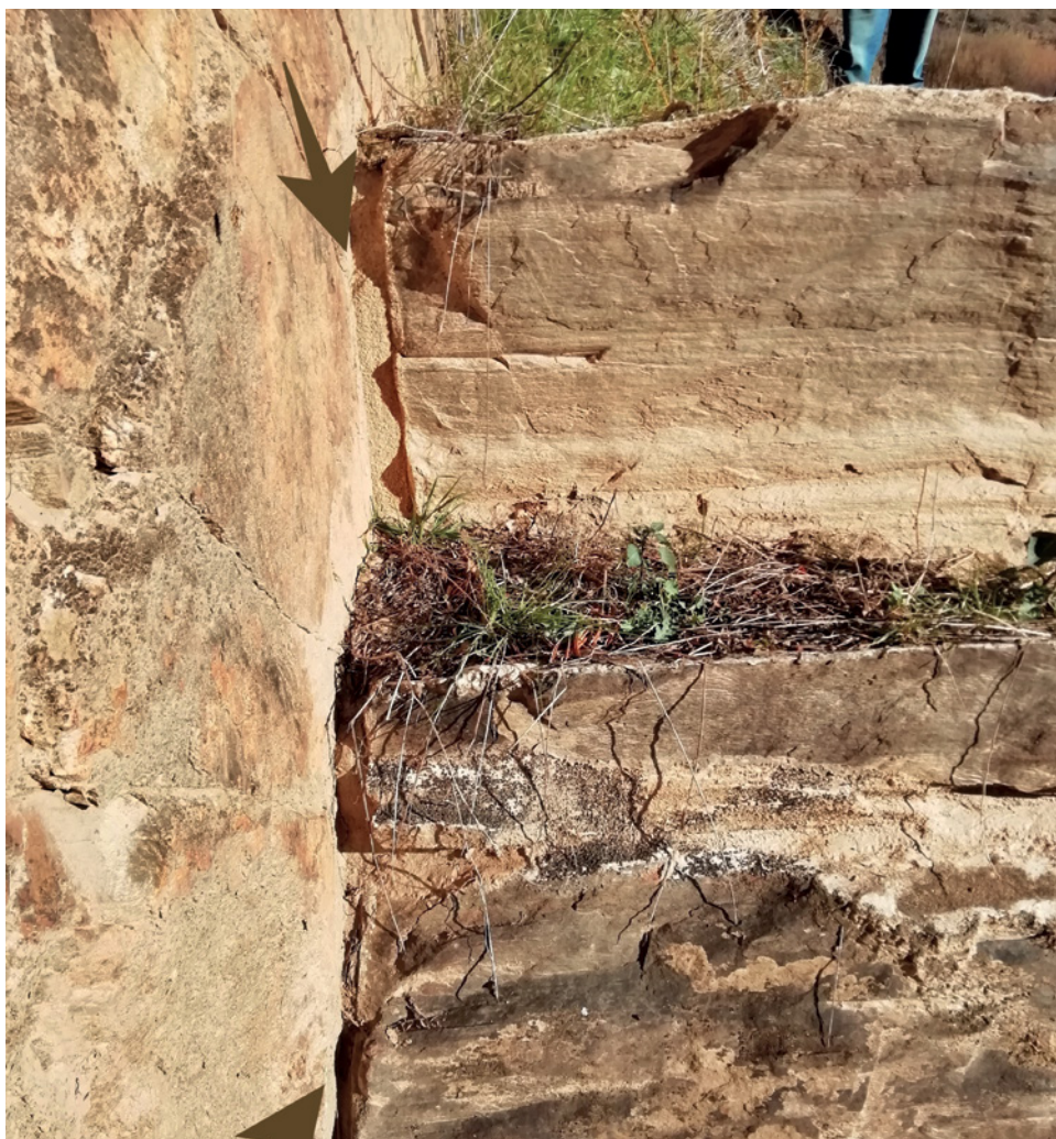
Figura 3: Rocha-tipo intervencionada no Núcleo de Arte Rupestre da Ribeira de Piscos. É possível observar que o preenchimento (assinalado) da caixa de diáclase ainda se encontra coeso, o processo de "renaturalização" em curso, bem como o desaparecimento progressivo da camada de recobrimento das intervenções, constituído por fragmentos de xisto local, mais escuro que o afloramento, razoavelmente granulados. Foto: © António Batarda Fernandes.
