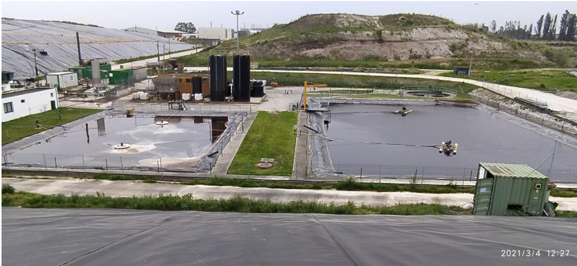
Figura 40 - Vista geral das instalações.
