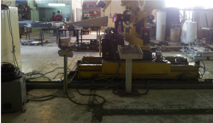
Figura 4.4 Remoção de toda a cablagem e canhas.
