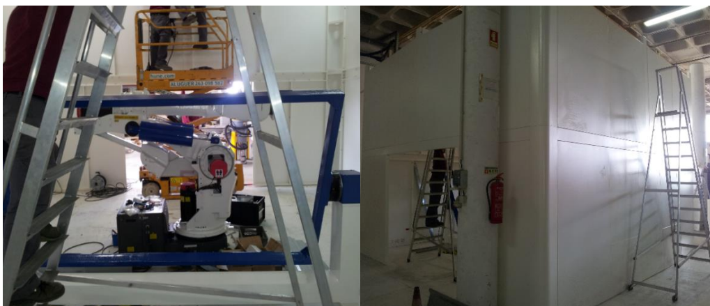
Figura 4.16 Finalização dos trabalhos de montagem
