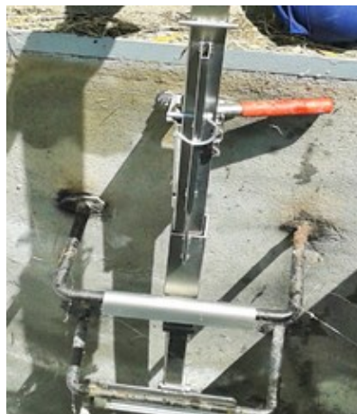
Foto 24 – Equipamento bloqueado em pré ajuste, através da cavilha (Fonte: produção própria)
