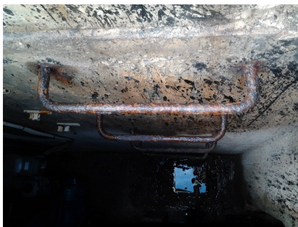
Foto 14 – Caixa de acesso a conduta (Fonte: produção própria)
