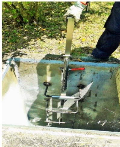
Foto 21 – Apoiado no 1º degrau é pressionado o equipamento, que através de uma mola permite pré ajuste com o 2º degrau (Fonte: produção própria)
