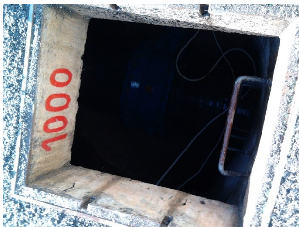
Foto 13 – Caixa de acesso a conduta (Fonte: produção própria)
