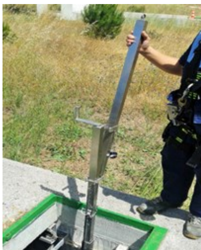
Foto 30 – Colocação do acessório para ancoragem (Fonte: produção própria)
