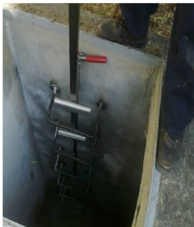
Foto 8 Colocação do dispositivo nos degraus
