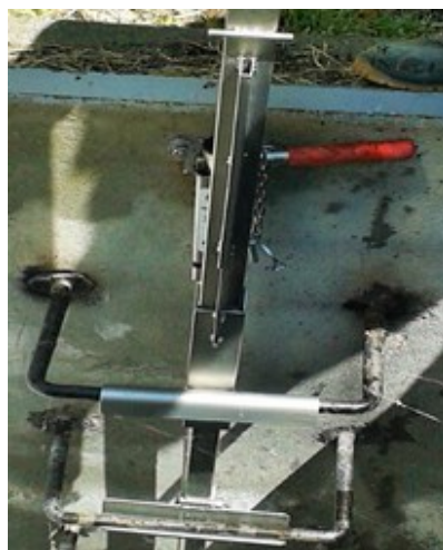
Foto 22 – Equipamento colocado em pré ajuste entre degraus (Fonte: produção própria)
