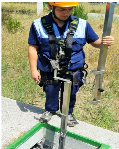
Foto 29 – Equipamento devidamente fixo entre degraus e pronto a receber o acessório de ancoragem (Fonte: produção própria)
