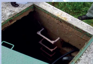
Foto 1 - Transição entre a cota do solo e a cota dos primeiros degraus da abertura
