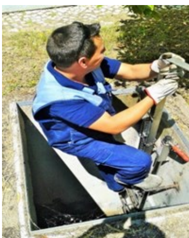
Foto 28 – Utilização no acesso descendente com apoio no equipamento (Fonte: produção própria)
