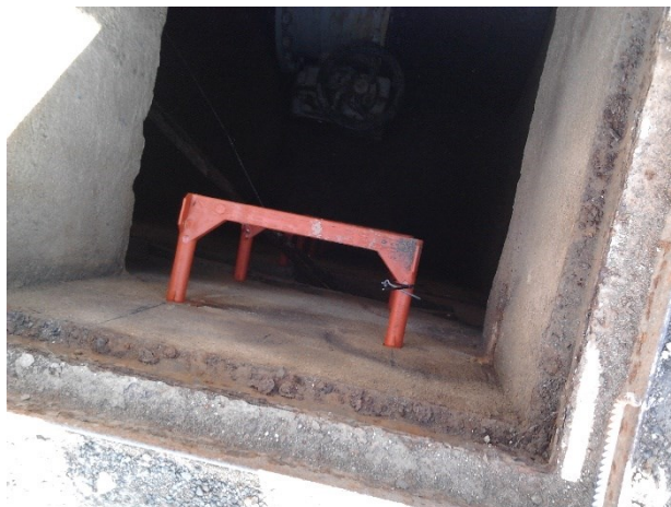
Foto 9 – Caixa de acesso a conduta (Fonte: produção própria)
