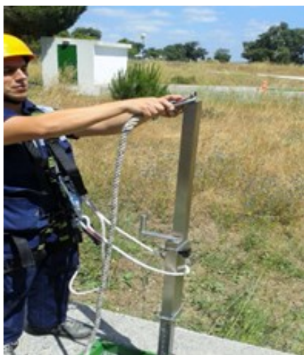
Foto 32 – Ancoragem da linha de vida (Fonte: produção própria)
