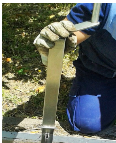
Foto 25 – Conclusão da fixação aos degraus, com ajuste fino por parafuso, através da manivela (Fonte: produção própria)
