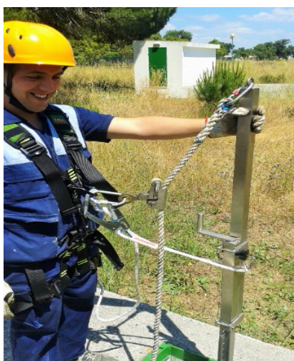
Foto 33 – Colocação na linha de vida de ancoragem anti-queda (Fonte: produção própria)
