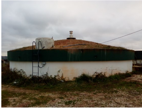
Foto 7 – Abertura de acesso a reservatório de abastecimento (Fonte: produção própria)
