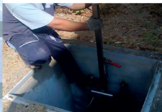
Foto 3 - Acesso ao 1º degrau com apoio no dispositivo
