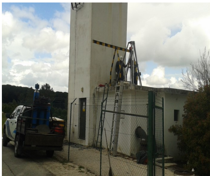
Foto 5 – Instalação de equipamento de resgate (Fonte: produção própria)
